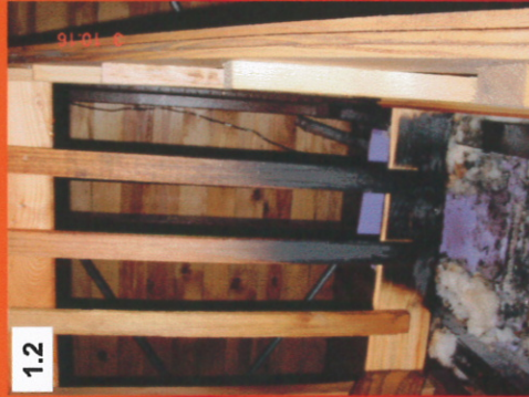
Vertikaler Sprühkopf mit 4 Düsen und Indikator-sprinkler unter Podest 3
