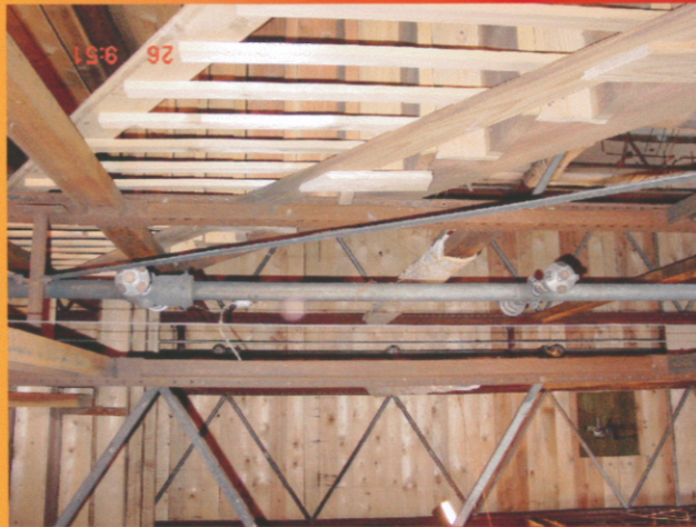
Mittleres Sprührohr über sämtliche Etagen
