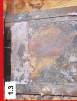
Brandschäden an der Vorder- (Foto 1.1) u. Rückseite des Geländers (Foto 1.2), auf dem Podestboden unter der Brandlast (Foto 1.3) sowie an der Brandlast selbst (Foto 1.1)
