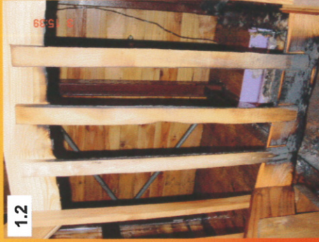
Brandschäden an der Vorder- (Foto 1.1) u. Rückseite des Geländers (Foto 1.2), auf dem Podestboden unter der Brandlast (Foto 1.3) sowie an der Brandlast selbst (Foto 1.1)
