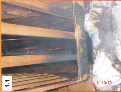
Brandschäden an der Vorder- (Foto 1.1) u. Rückseite des Geländers (Foto 1.2) sowie an der Brandlast
