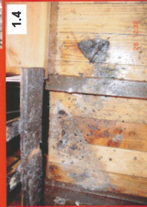
Brandschäden an der Vorder- (Foto 1.1, 1.2) u. Rückseite (1.3) des Geländers, auf dem Podestboden unter der Brandlast (Foto 1.4) sowie an der Brandlast selbst (Foto 1.1, 1.2, 1.5)
