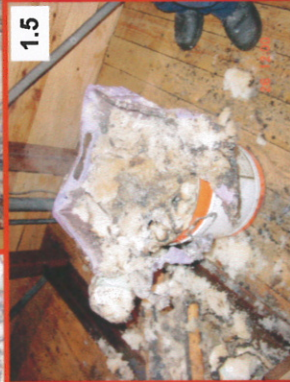
Brandschäden an der Vorder- (Foto 1.1, 1.2) u. Rückseite (1.3) des Geländers, auf dem Podestboden unter der Brandlast (Foto 1.4) sowie an der Brandlast selbst (Foto 1.1, 1.2, 1.5)
