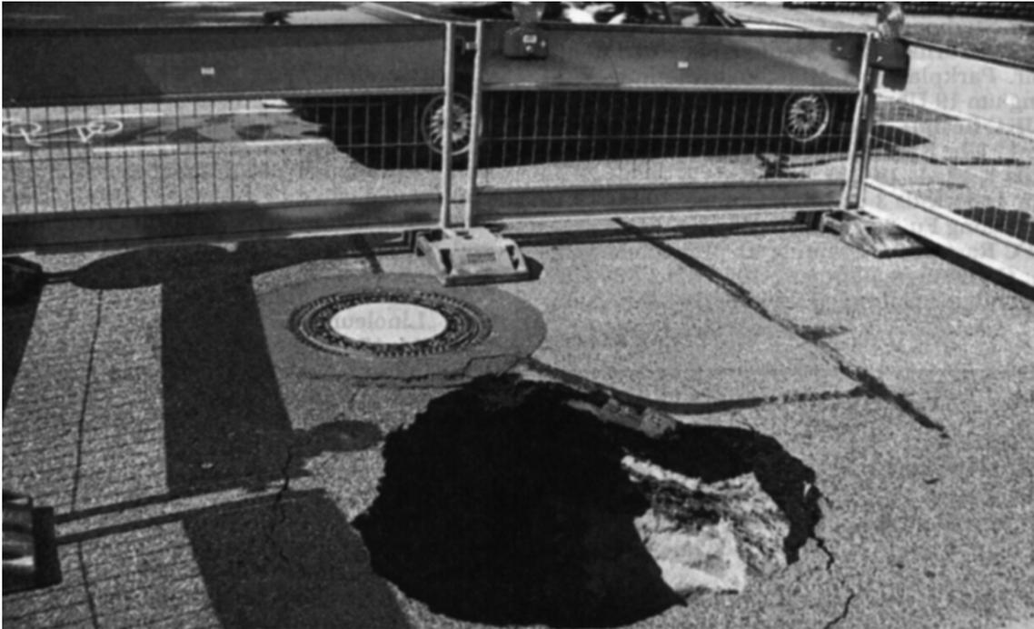
**Abb. 1.2:** Einsturz der Fahrbahndecke infolge undichten Abwasserkanals
