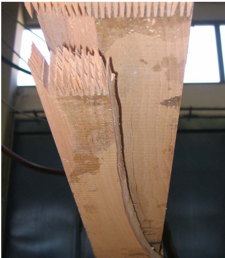
Bild B-14 Träger K1, Untersicht: KZV-Anriss in Zelle 1.44 mit anschließendem Querriss bis Zelle 1.40
