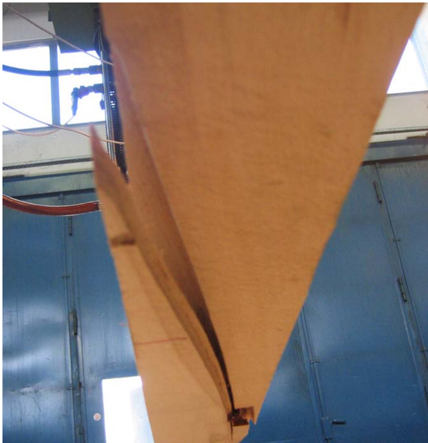
Bild B-17 Träger R7, Untersicht: Verlauf des Querrisses von Zelle 1.27 bis 1.32
