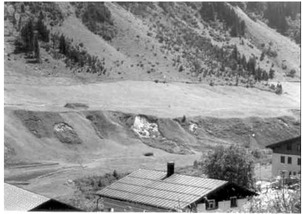
Abb. 7-17: Schuttrutschungen an der Terrassenkante im nordöstlichen Ortsteil von Lech (Photo N. Hawelka).
