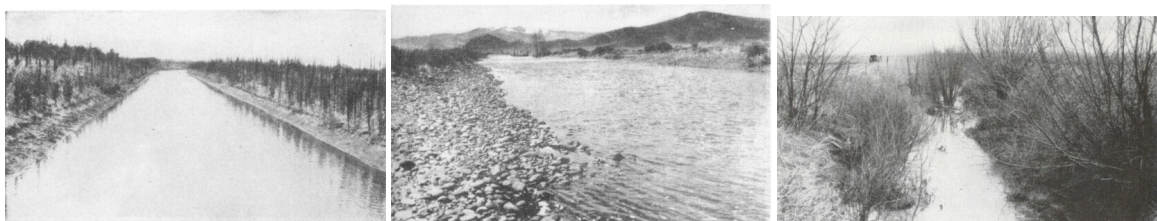
(a) k_{St} = 50 m^{1/3}/s , Betonkanal mit glatter Oberfläche (b) k_{St} = 36 m^{1/3}/s , Fluss mit Kies- und Sandsohle (c) k_{St} = 12 m^{1/3}/s , stark verwachsenes Bachbett
