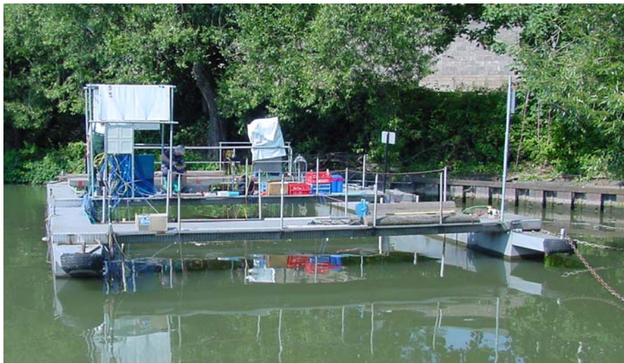
Abbildung 4.5: Schwimmende Arbeitsplattform im Becken 2, Oberhafen Frankfurt
