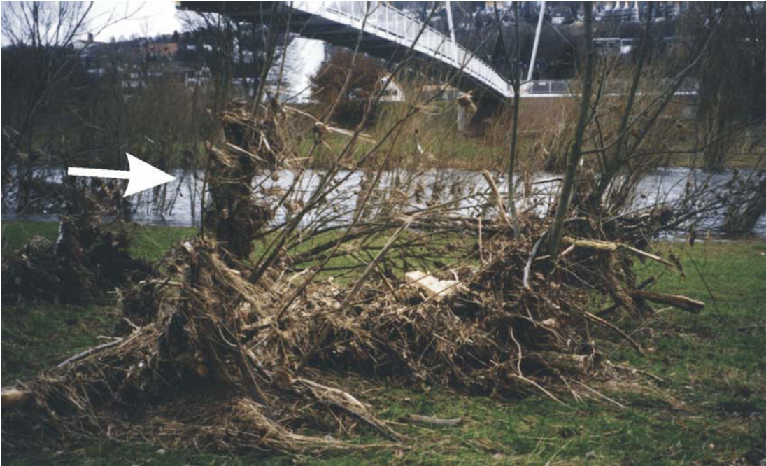
Abb. A - 34: Verklauung einer querläufigen Bewuchsanordnung durch Geschwemmsel und Totholz. (Lehmann)
