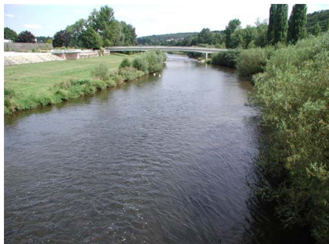
Abb. 6.7: Blick in Fließrichtung entlang des Bereich 5. Aufnahme vom Juli 2003.
