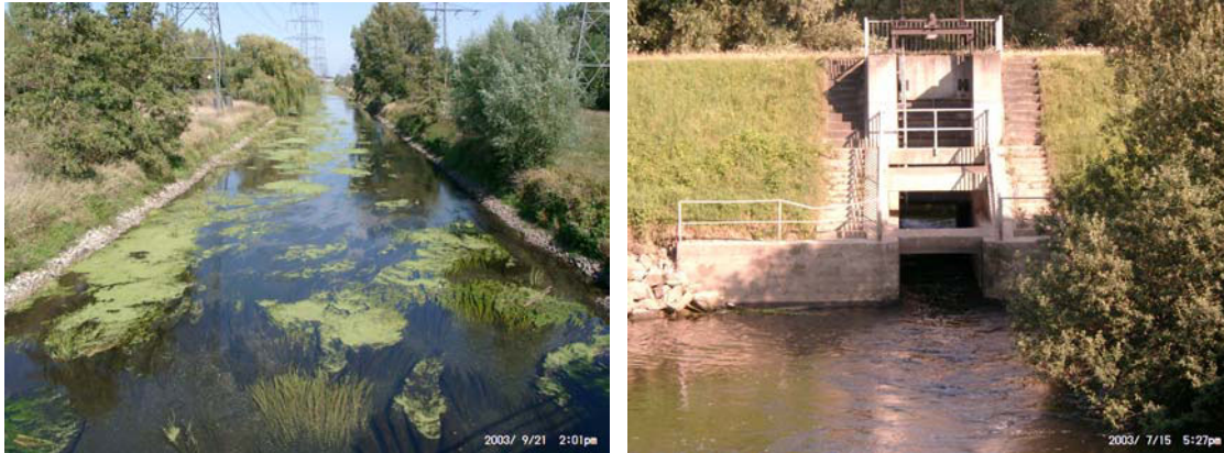
Abb. 0.1: Begradigte Alb (links) und Albdurchlass am Rheindamm (rechts).
