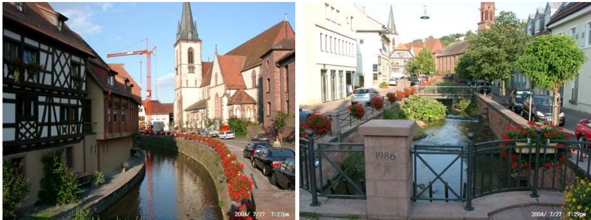
Abb. 2.14: Gewässerkosmetik ohne wirkliche Verbesserung der gewässerökologischen Merkmale. Links: Gewässer im ausgebauten Zustand. Rechts: Durch fachlich fehlverstandene „Renaturierungen“ überwuchert der zugelassene Bewuchs die eigentliche harte Verbauung des Baches. Zudem kann sich eine solche Maßnahme sehr nachhaltig negativ auf die Hochwassersicherheit auswirken.
