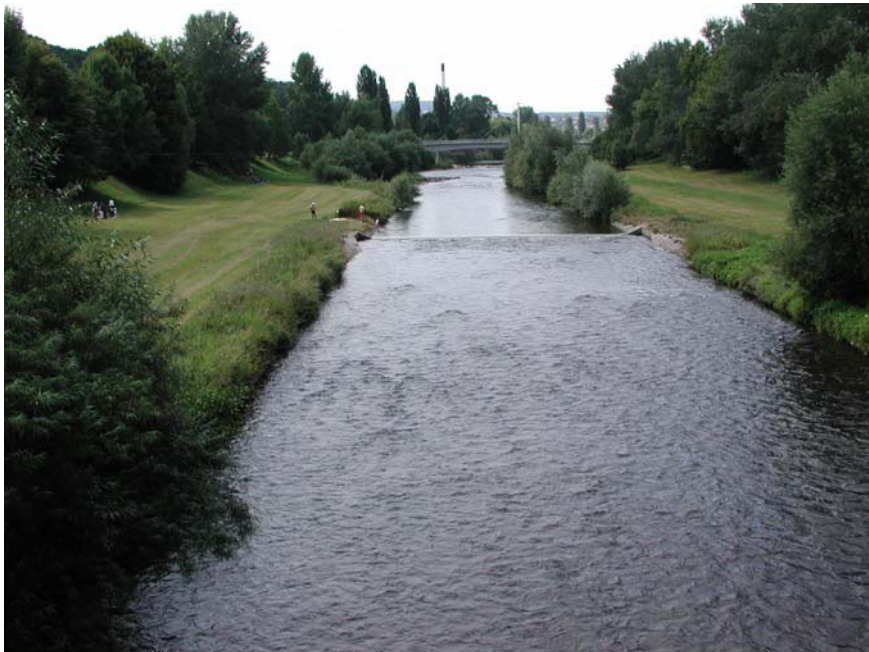
Abb. 6.8: Blick nach Oberstrom zum Bereich 6, der sich von der Pegelschwelle (Bildmitte) nach Oberwasser erstreckt. Aufnahme vom Juli 2003.
