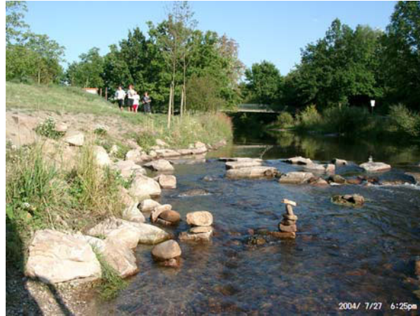
Abb. 2.15: Sohlsicherung durch den Einbau eines ökologisch durchgängigen Querriegels in aufgelöster Bauweise bestehend aus großflächigen, plattigen Steinen. (Aufnahme: Lehmann)
