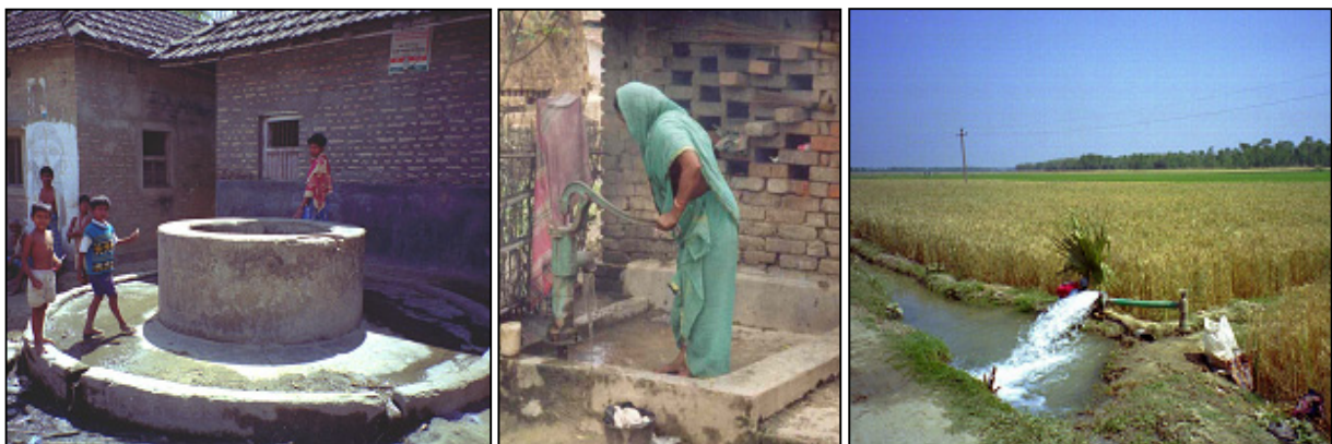
Abb. 12: Typische Grundwasser-Probenahmestellen: Traditioneller offener Schachtbrunnen (links), Bohrbrunnen mit Handpumpe als typischer Hausbrunnen (mitte), motorisierter Bewässerungsbrunnen (rechts).
