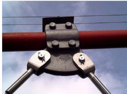
Bild 3-3: Anschlussseilklemme für Hängerseile am Tragseil einer Hängebrücke
