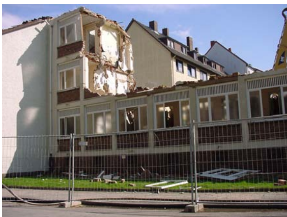
Abb. 26: Abbruch Altbau Beyersche Burg 1 in 2004
