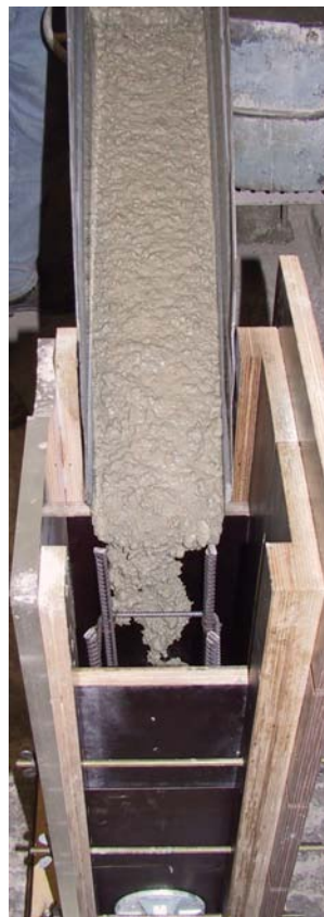
Abb. 14: Einbauverfahren für SVB im Labor
