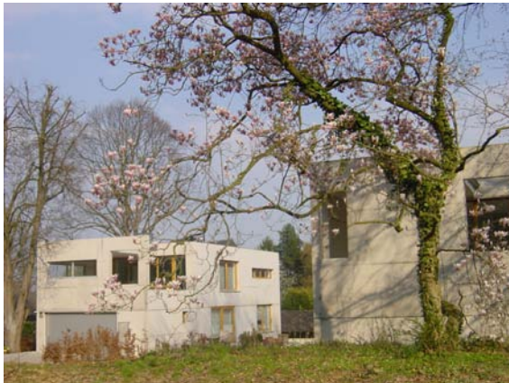
Abb. 25: Haus C + E: Kuben, Fassaden mit Loggien
