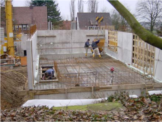
Abb. 18: Betonieren der Geschossdecke
