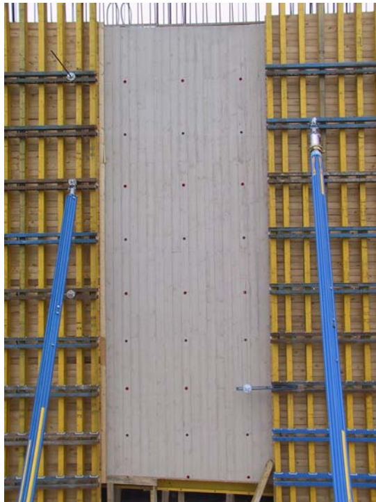
Abb.: 5: Wand in SVB mit relativ homogener Optik
