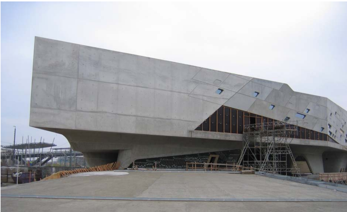
Abb. 4: Science Center Wolfsburg: Sichtbeton mit SVB
