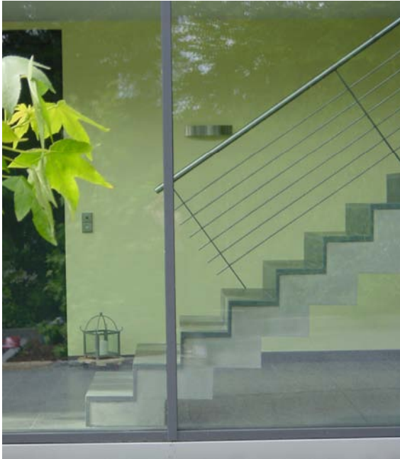
Abb. 11: Individueller Wohnbau – Sichtbeton Detail
