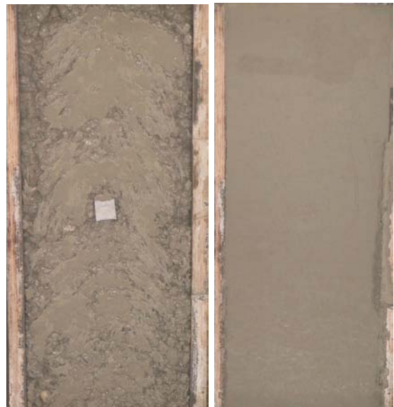
Abb. 13: Frischbeton in der Stützenschalung vor und nach dem Verdichten
