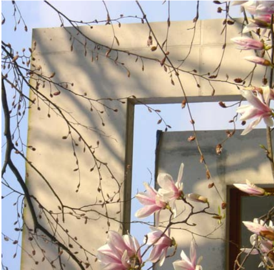
Abb. 24: Haus E: Detail Loggia
