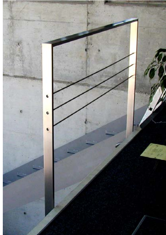
Abb.9: Sichtbeton im Industriebau in Herford – Detail
