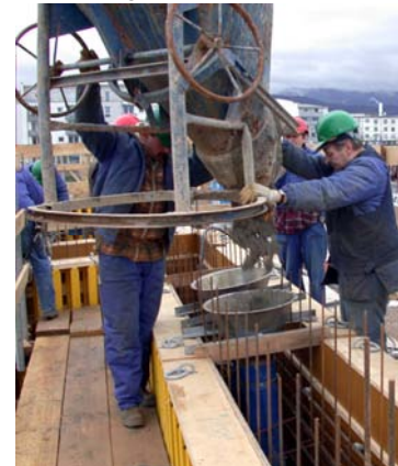
Abb. 4: Einbau von Sicht-Leichtbeton mit dem Betonkübel über Schüttrichter mit angeschlossenen Schläuchen
