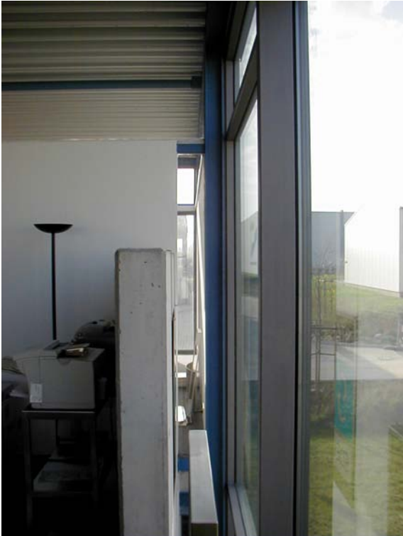
Abb. 8: Sichtbeton im Industriebau in Herford – Detail
