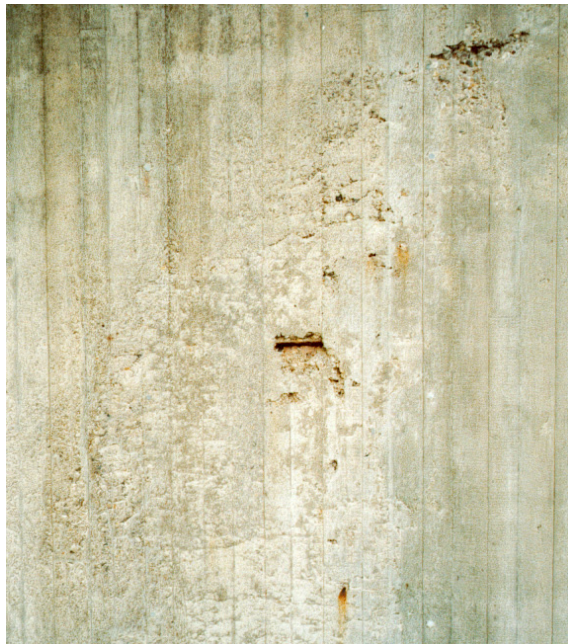
Abb. 12: Verdichtungsfehler
