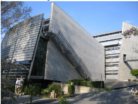
Abb. 1: Sichtbetonbauwerk jüngerer Zeit: Audimax der TU München
