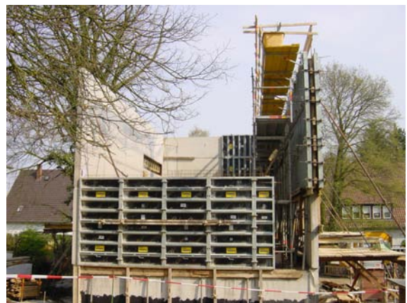
Abb. 17: Herstellung der Fassaden in Sichtbeton
