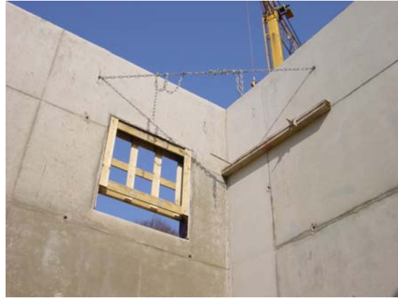
Abb. 21: Haus C: Fassadenverspannung – von innen
