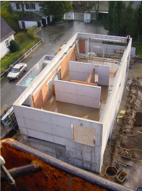
Abb. 19: Haus S: Luftbild der Sichtbetonstruktur
