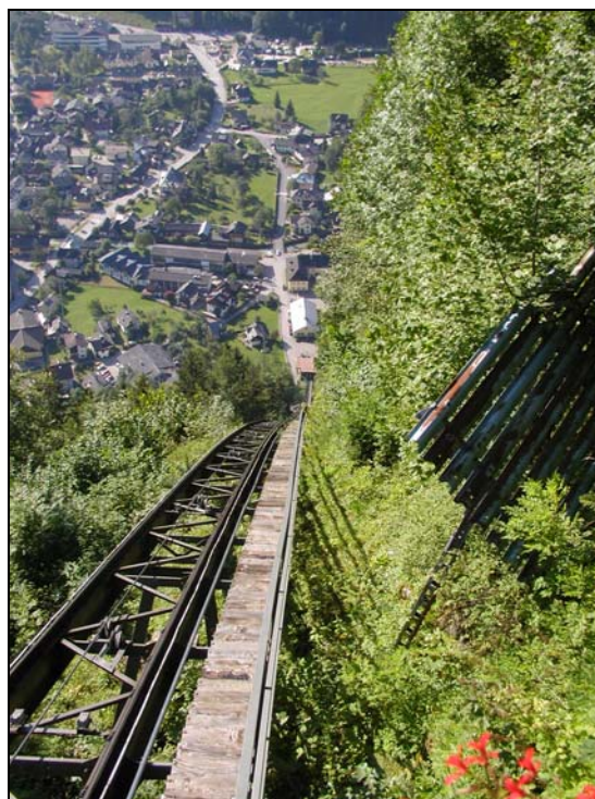
Foto 6.2-7: Blick aus der Bergstation auf die Standseilbahnstrecke nach Hallstatt-Lahn. Rechts im Bild eine Schneebrücke zum Schutz vor Lawinen (2004).
