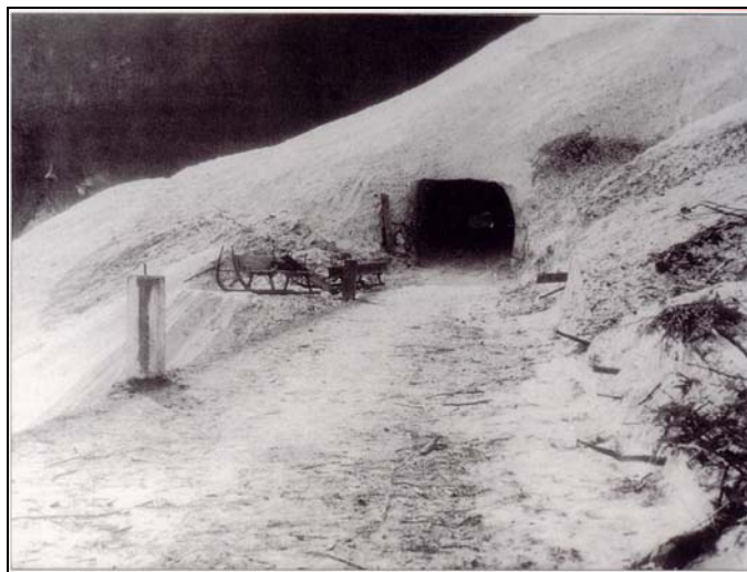
Abb. 5.4-6: Schoßlahnganglawine im Winter 1945. um den Verkehr zwischen Obertraun und Hallstatt wiederherzustellen, wurde ein 52 m langer Tunnel gegraben, der mehrere Wochen Bestand hatte (URSTÖGER, 2000).
