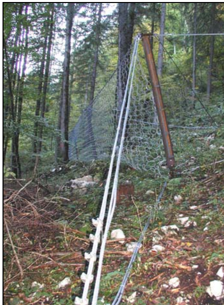
Foto 5.3-4: Modernes Stahlschlingen Steinschlagnetz am Fuss der Echernwand (2004).
