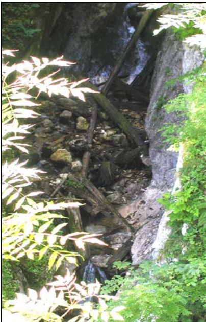
Foto 8.4-2: Murmaterial unterhalb der Falkenhaynsperre in der Mühlbachschlucht (2004).
