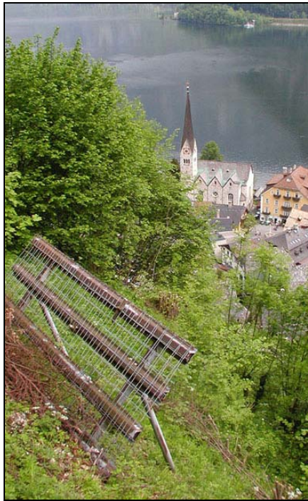
Foto 5.4-1: Schneebrücke am Hang über dem Ortskern von Hallstatt.
