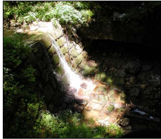
Foto 8.4-1: Falkenhaynsperre in der Mühlbachschlucht.
