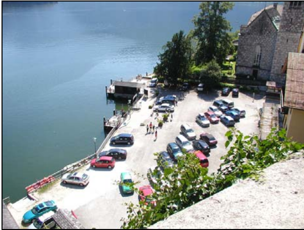
Foto 6.2-5: Parkplatzfläche unterhalb der Katholischen Kirche mit Schiffsanlegestelle von Hallstatt (2004).
