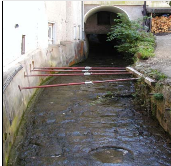
Foto 8.4-7: Abstützung des regulierten Bachbetts im Ortskern von Hallstatt (1-1,5 m Breite).
