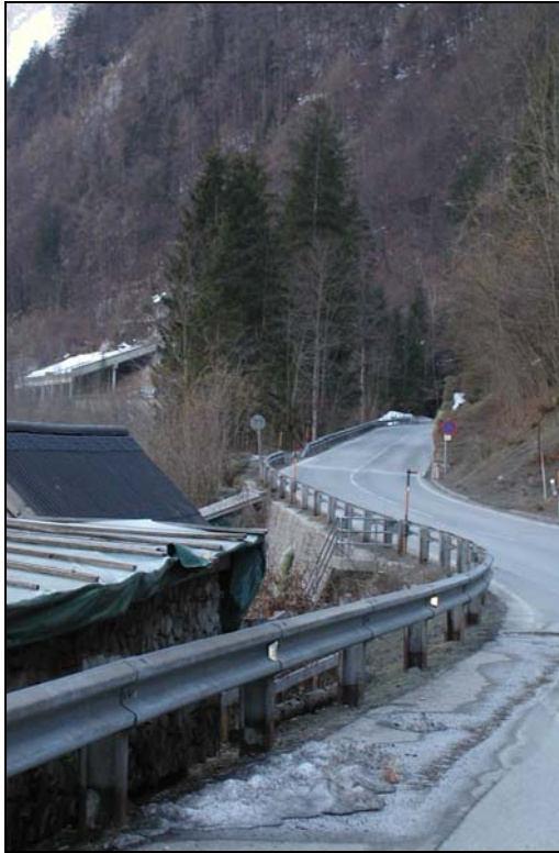
Foto 6.2-6: Landesstraße L547 ca. 2km nördlich des Hallstätter Tunnel mit Lawinengalerie im Hintergrund (2004).
