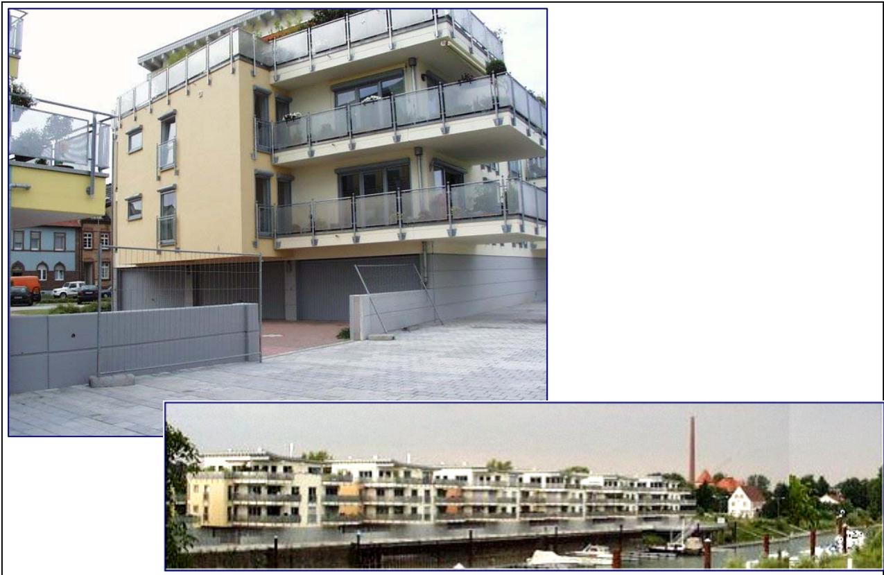
**Abbildung 4-15:** Wohngebäude in Speyer mit integriertem Hochwasserschutz („Deich“) auch für die dahinter liegende (alte) Bebauung sowie optional flutbarer Tiefgarage
