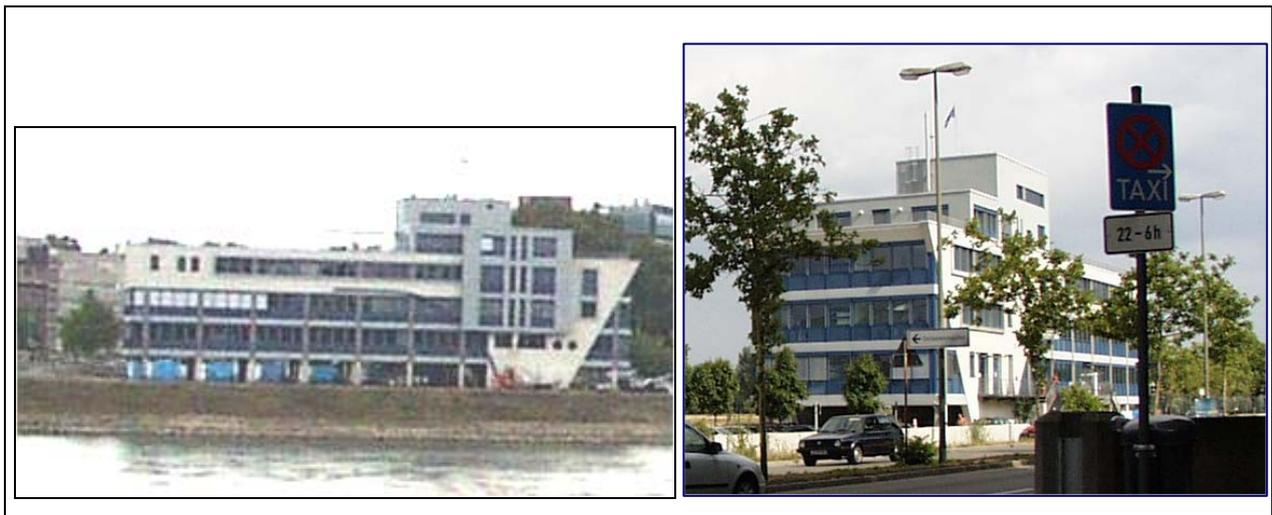
**Abbildung 4-16:** Aufständering eines Bürogebäudes in Ludwigshafen, Vorteil: Überflutungsflächen bleiben im Hochwasserfall erhalten
