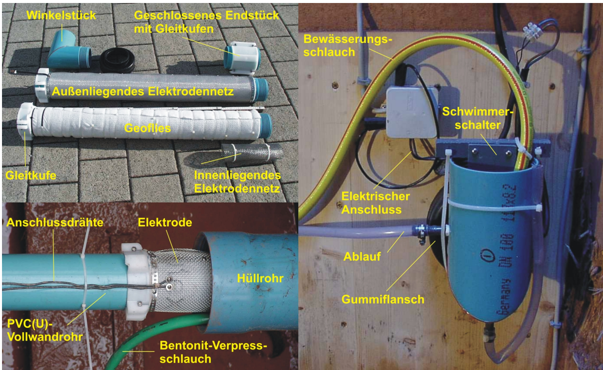
Abb. 5-23: Bauteile der Kathoden (links oben), Installation (links unten) und fertig montierte Kathode (rechts).
