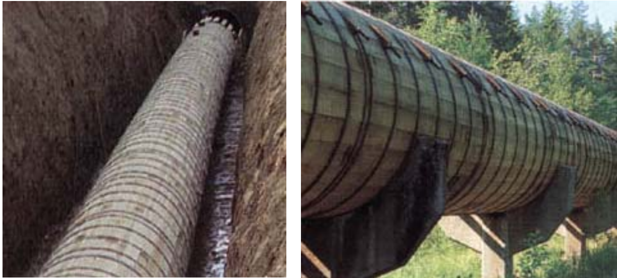
Bild 5-6 Druckrohrleitung aus Holz (a) im Graben und (b) auf Sätteln (von Boxholm Produktion AB)
