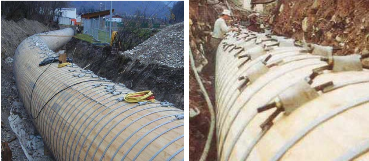
Bild 5-1 Druckrohrleitung aus Holz (von Zwick Holzbau GmbH)
