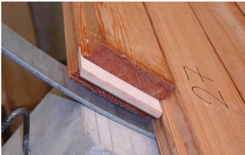
Bild 5-2 Detail Nut- und Federverbindung
