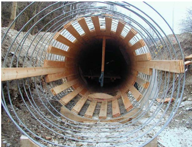
Bild 5-5 Montage einer Druckrohrleitung aus Holz (von Zwick Holzbau GmbH)
