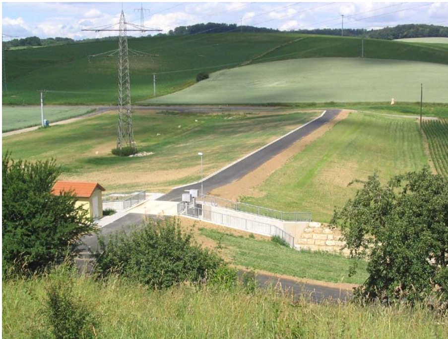
Abb. 6.11 Gesamtansicht des HRB Mönchzell nach Abschluss aller Arbeiten (Foto: HZV 2004)
