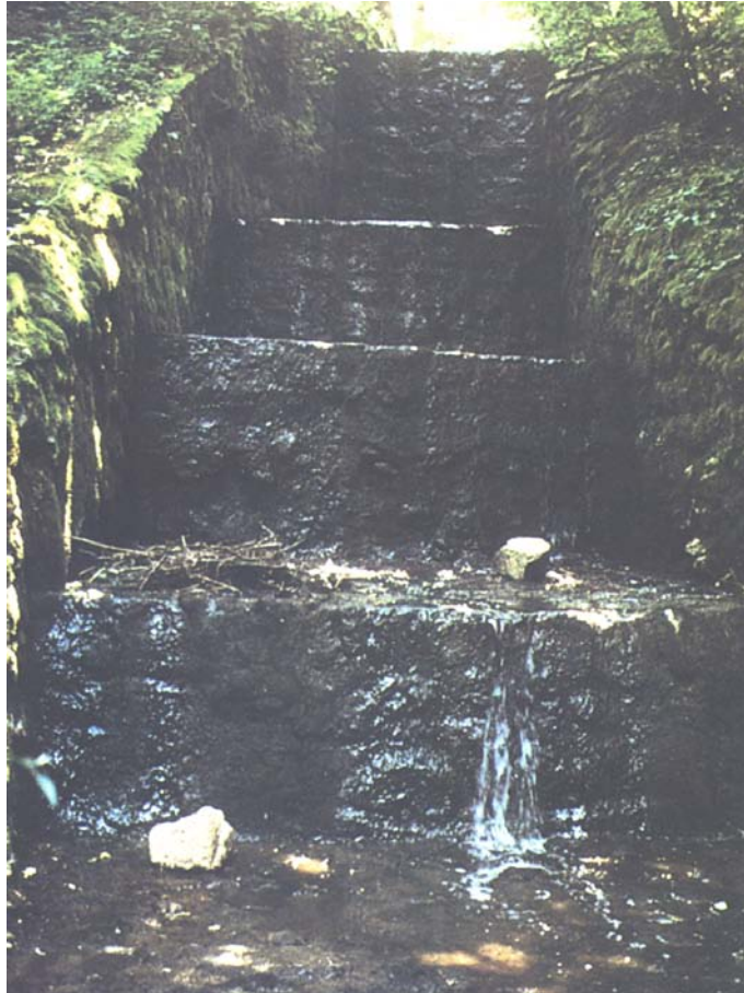
Abb. 3.13 Treppenförmige Hochwasserentlastungsanlage am Sternenweiher im Kanton Zürich (Quelle: BOSSHARD 1991)
