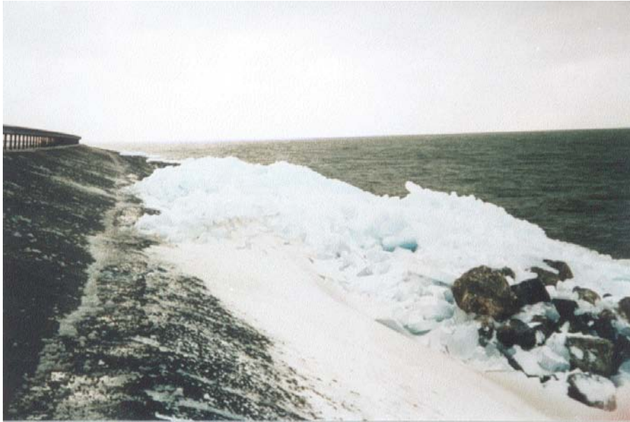
Abb. 5.4 Mastix-Schotter als Deichschutz gegen Wellenangriff (Quelle: BITUMARIN BV)
