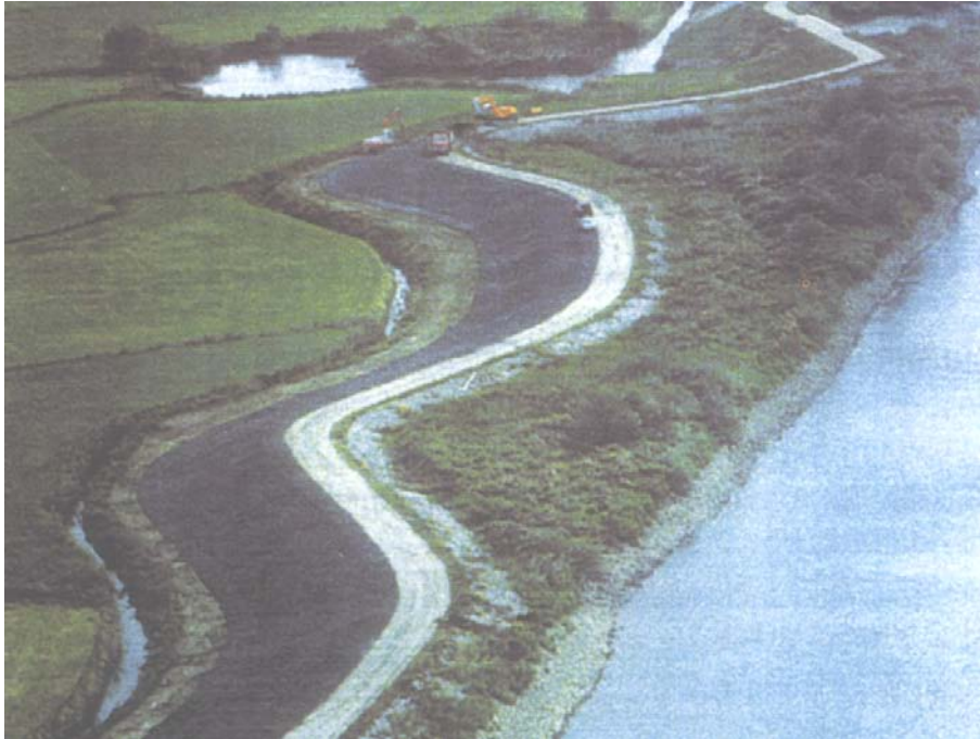
Abb. 5.2 Luftseitige Böschungssicherung mit Mastix-Schotter an einer Überströmstrecke des Überflutungsgebietes Tielrodebroek in Belgien (Quelle: SCHÖNIAN 1999)
