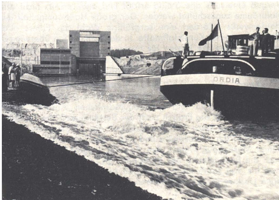
Abb. 5.1 Belastung des Deckwerks aus Mastix-Schotter mit einem Schraubenstrahl (Quelle: KUHN 1971)
