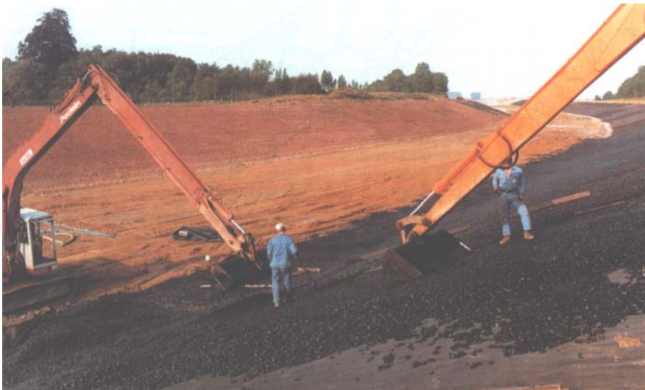
Abb. 5.5 Großflächige Anwendung von Mastix-Schotter am Canal du Centre in Belgien (Foto: Bitumar 1986)
