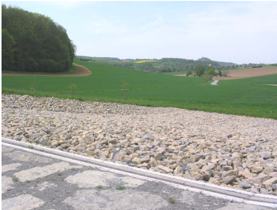
Abb. 3.6 Hochwasserentlastungsanlage mit Steinschüttung am HRB Binsenklinge-Reihen im Einzugsgebiet Elsenz/Schwarzbach (Foto: Queißer 2005)
