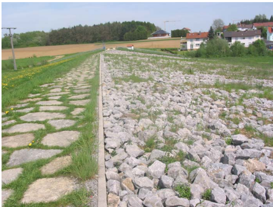
Abb. 2.8 HRB Aglasterhausen-Bockwiese im Einzugsgebiet Elsenz/Schwarzbach (Foto: Queißer, 2005)
