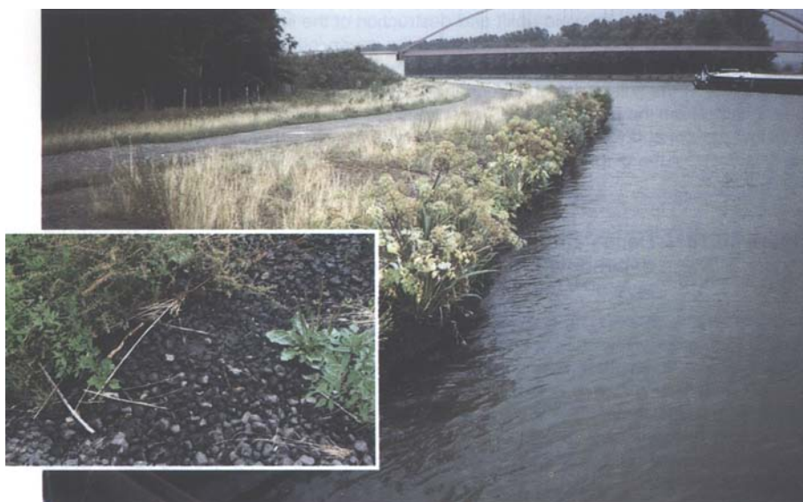
Abb. 5.3 Begrünte Ufersicherung aus Mastix-Schotter am Mittellandkanal zwei Jahre nach dem Einbau (Foto: SCHÖNIAN 1989 aus SCHÖNIAN 1999)
