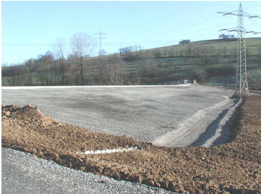
Abb. 6.5 Planum aus Mineralbeton vor dem Einbau des Deckwerkes (Foto: Queißer 2003)
