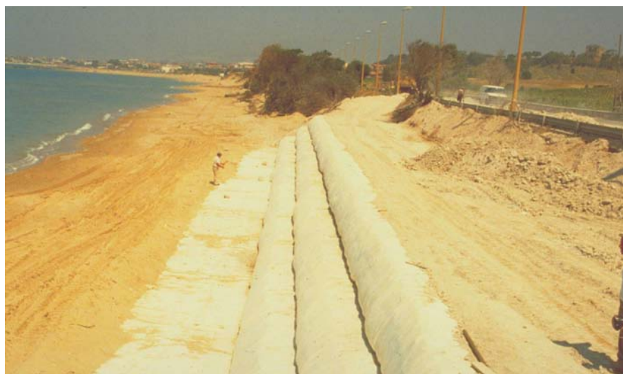
Abb. 7.3 Bau von Konstruktionen mit größerer Höhe durch Stapelung (Quelle: BIEBERSTEIN ET AL. 2004a)
