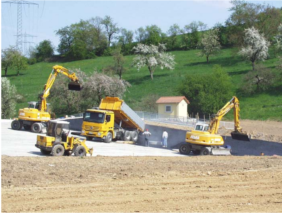
Abb. 6.8 Maschineneinsatz bei der Bauausführung (Foto: IBF 2004)
