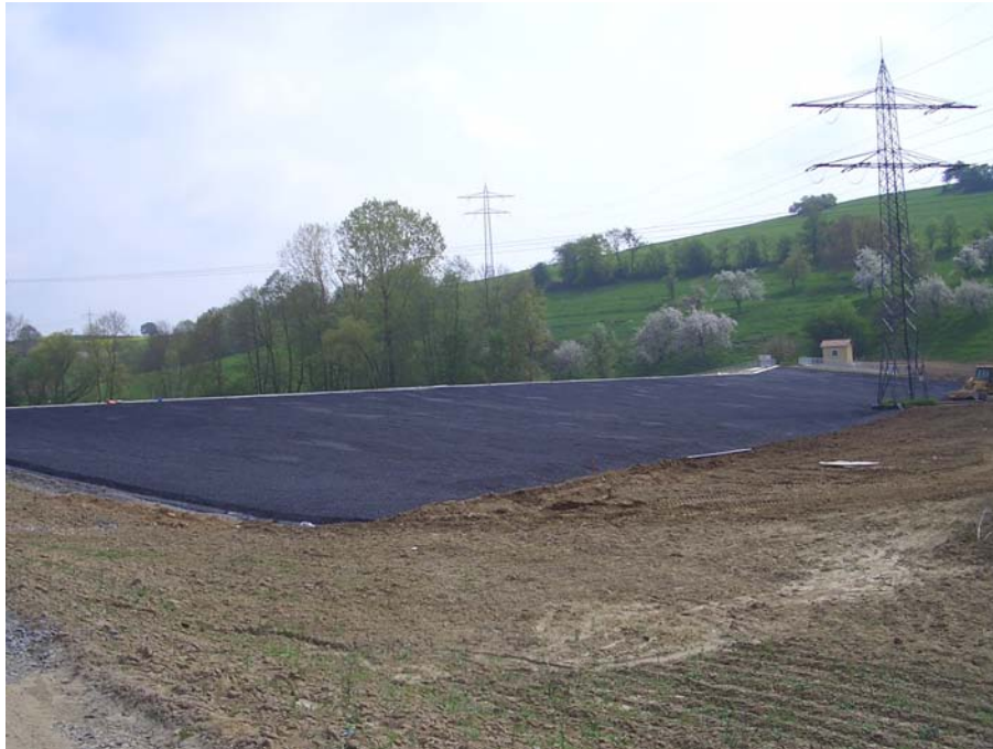
Abb. 6.10 Überströmstrecke nach der Fertigstellung des Deckwerkes (Foto: IBF 2004)
