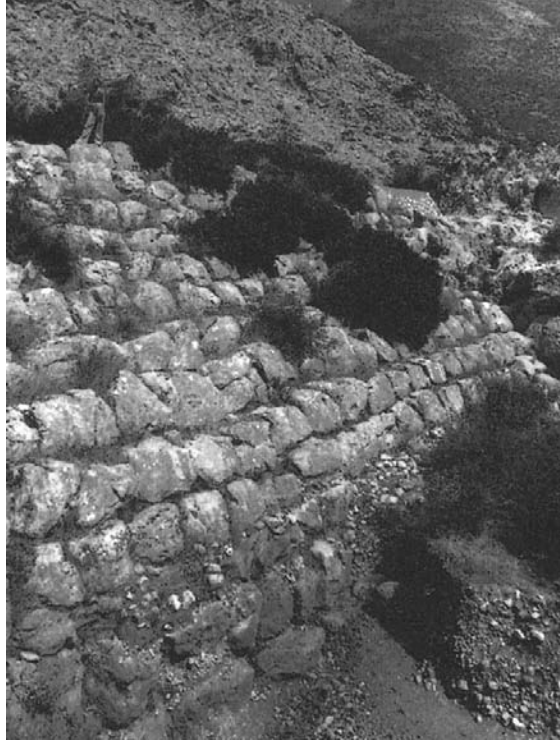
Abb. 2.4 Historische Talsperre in der Glosses-Schlucht bei Alyzeia/Griechenland (Foto: Murray)
