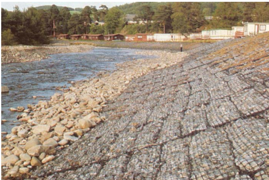
Abb. 3.9 Ufersicherung mit Gabionen aus Geogittermatratzen (Quelle: LfU 2004)
