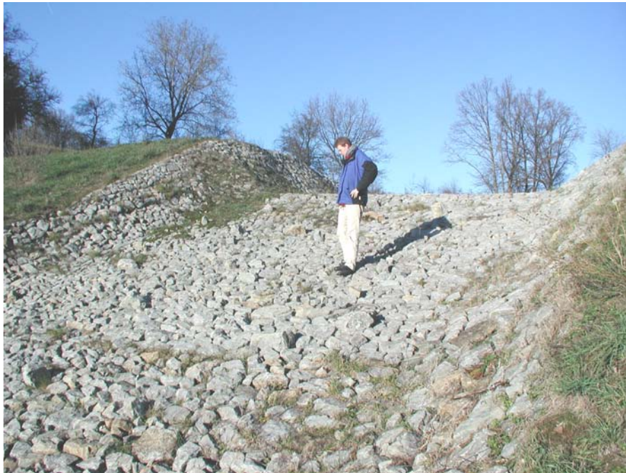
Abb. 3.3 Hochwasserentlastungsanlage mit Steinsatz am HRB Epfenbach-Wingertshecke im Einzugsgebiet Elsenz/Schwarzbach (Foto: Seidel 2003)
