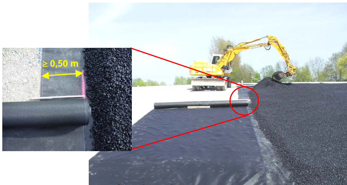
Abb. 6.6 Verlegen des Geogewebes als Filterschicht (Fotos: IBF 2004)
