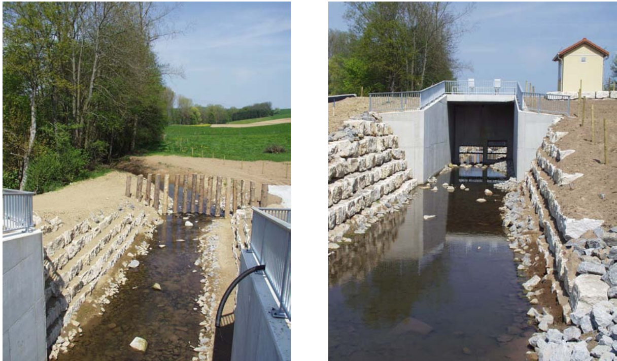
Abb. 6.3 Durchlassbauwerk mit Ein- und Auslaufbereich (Fotos: Queißer 2004)
