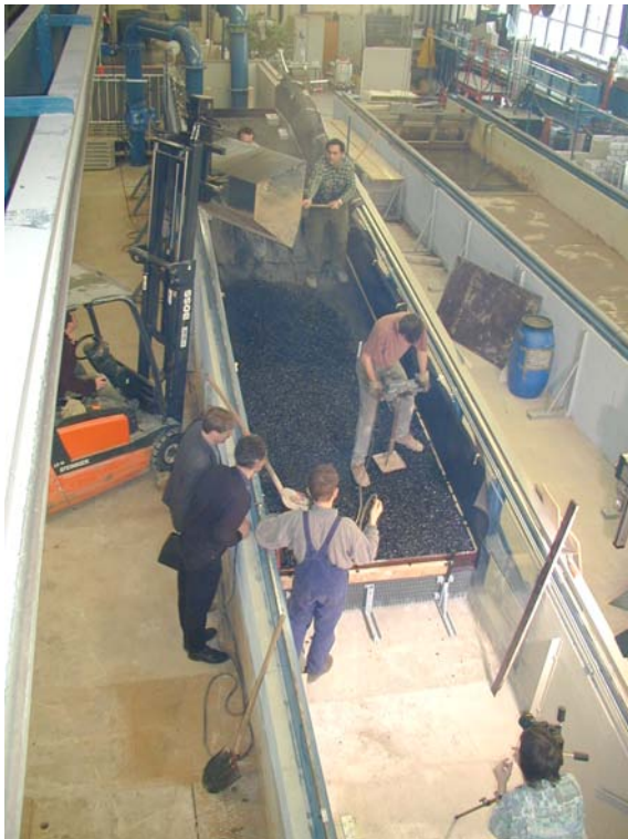
Einbau des Mastix-Schotters
