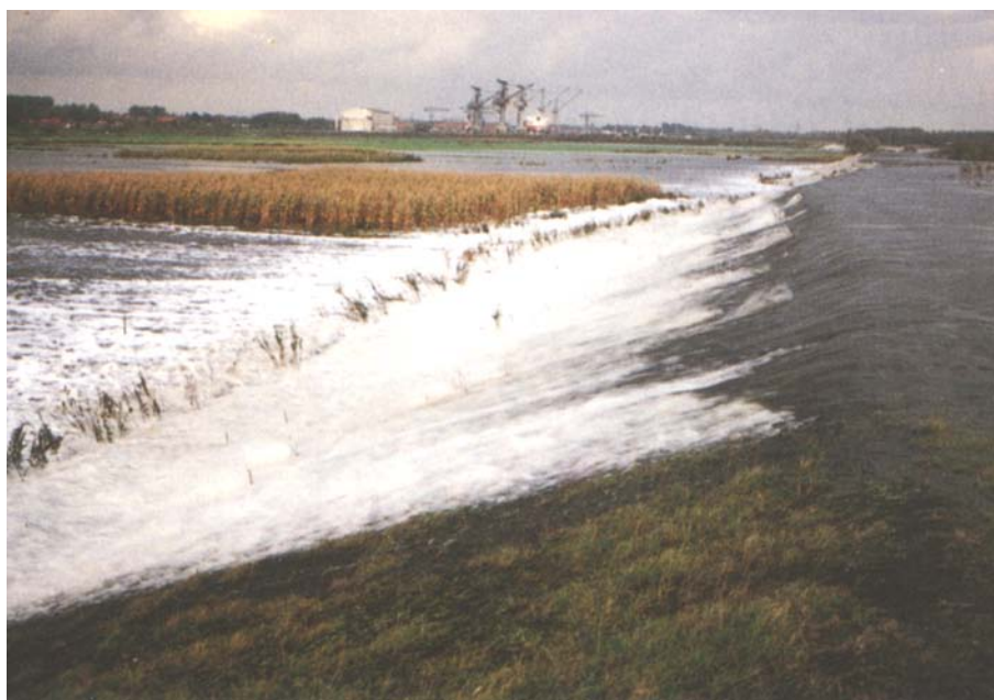
Abb. 2.10 Überlaufstrecke einer Notentlastung an der Schelde (Niederlande/Belgien) (Quelle: Toepassing van asfalt bij binnenwateren, Civieltechnisch Centrum Uitvoering Research en Regelgeving (CUR), 1995, Fig. 52, S. 61)
