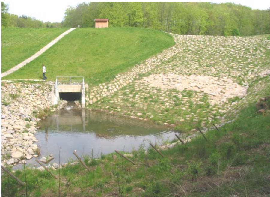
Abb. 3.8 Hochwasserentlastungsanlage mit Steinpflaster am HRB Waldwimmersbach / Mannbach im Einzugsgebiet Elsenz/Schwarzbach (Foto: Queißer 2005)
