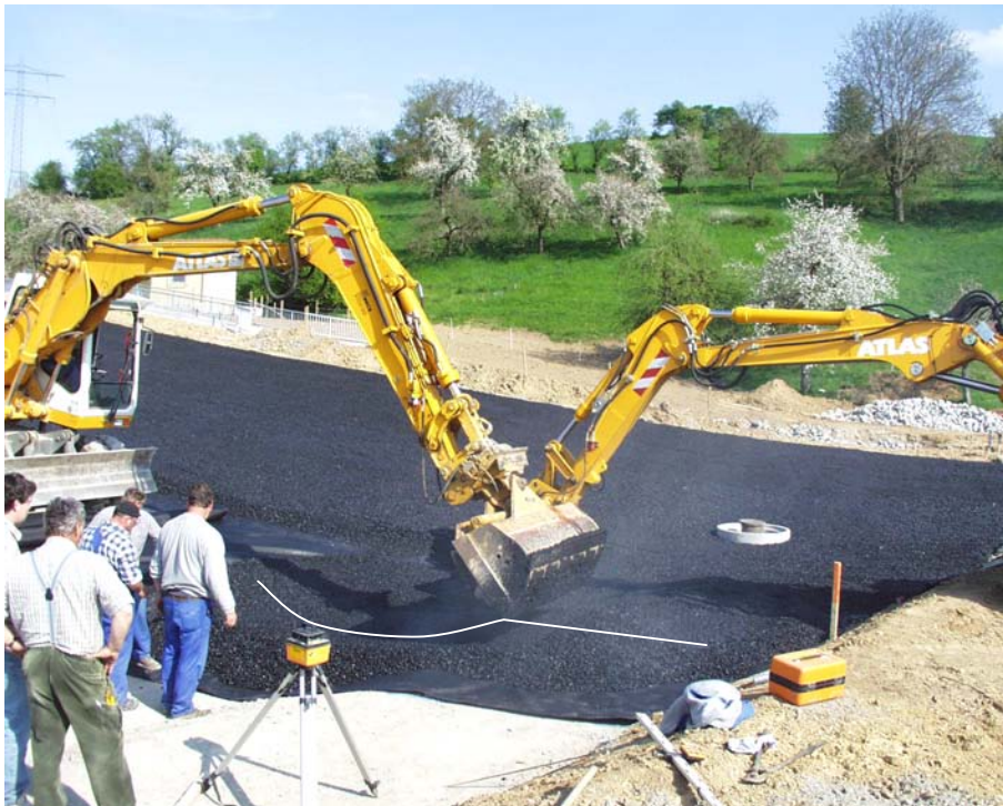
Abb. 6.9 Ausformung des Kolkbereiches am Böschungsfuß mit der Baggerschaufel (Foto: IBF 2004)
