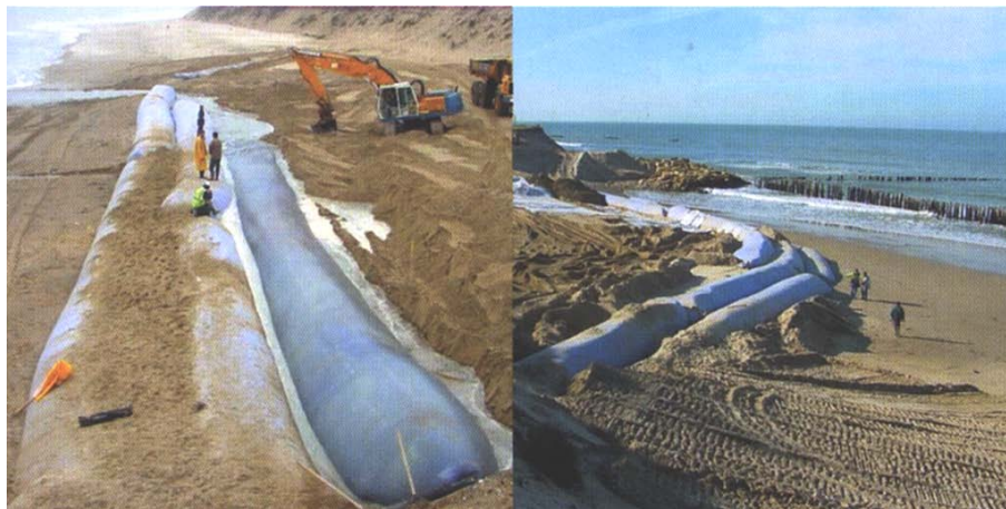
Abb. 7.2 Geotubes im Küstenschutz (Quelle: Polyfelt Geosynthetics, Report 1.2005)
