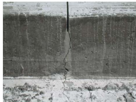
Abb. 2.2: Herstellung einer Scheinfuge (links) und eine durchgerissene Querscheinfuge (rechts)
