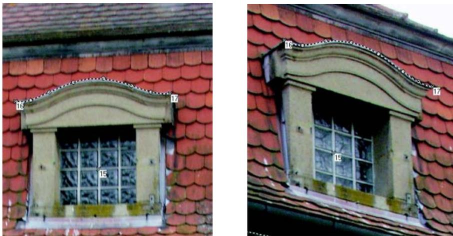
Abbildung 5.7: Die Abbildung zeigt ein Beispiel für Interpolation von Bildpunktbeobachtungen durch einen Spline. Der Spline ist gestrichelt eingezeichnet. Die gemessenen Stützpunkte sind als kleine schwarze Kreise und die Endpunkte des Splines mit Quadraten markiert. Foto und Bearbeitung von S. Wursthorn
