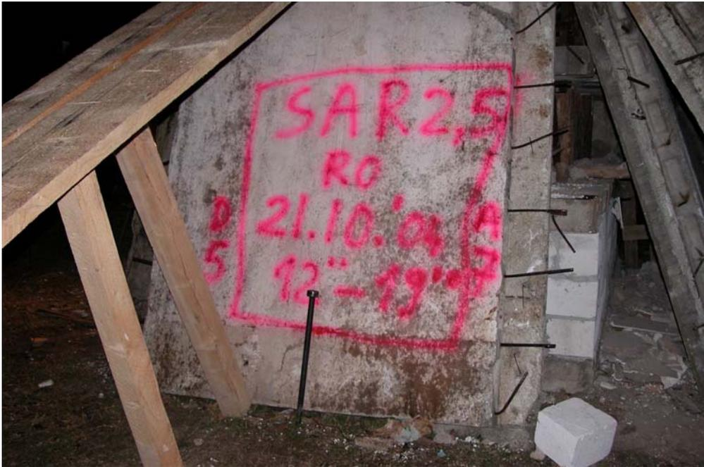
Abbildung 3.2: Mit Sprühdosen aufgebrachte Angaben zu Schäden nach Einsturz eines Gebäudes. Bild von der Arbeitsgruppe Disastermanagement-Tool des SFB 461, Bukarest 2004
