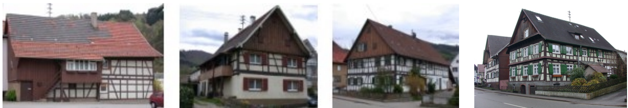
Abb. 60: Gernsbach-Hilpertsau und -Obertsrot: Eindachhäuser mit rückwärtigem, teils verschaltem Stallteil und großen, zweistöckigen Wohnbereichen, geringer Anteil landwirtschaftlich genutzter Gebäudefläche
