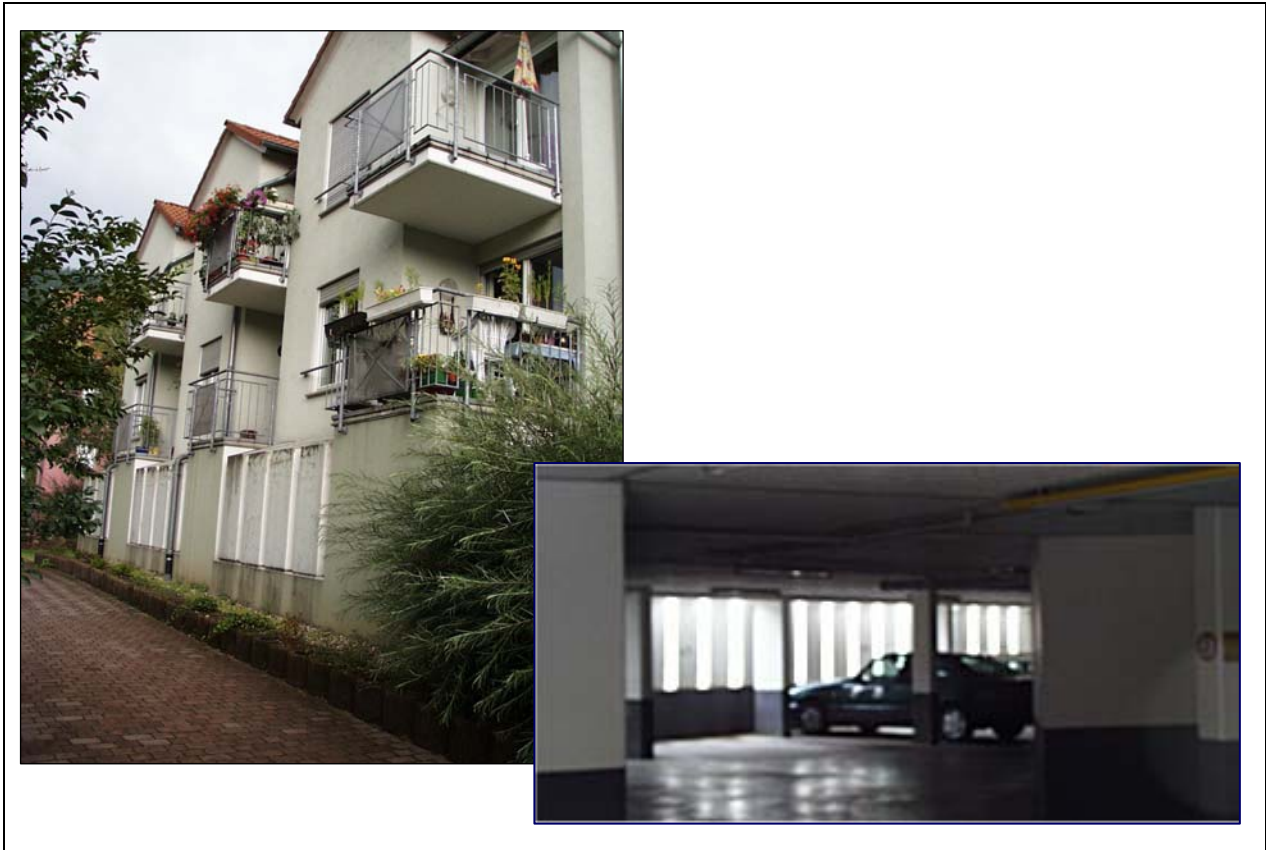
Abbildung 4-14: Wohngebäude mit im Hochwasserfall flutbarer Tiefgarage in Neckargemünd
