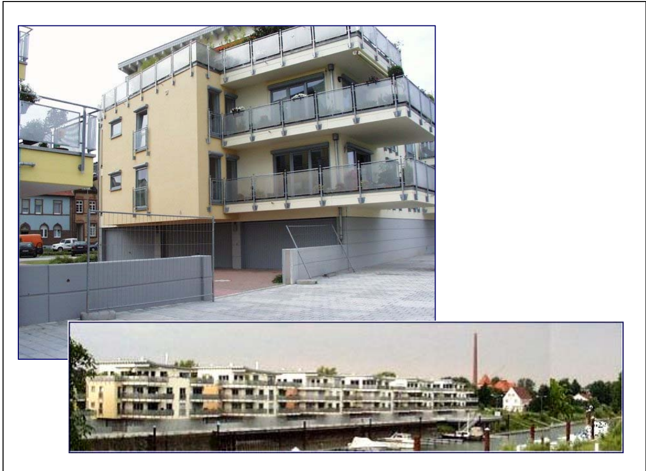
Abbildung 4-15: Wohngebäude in Speyer mit integriertem Hochwasserschutz („Deich“) auch für die dahinter liegende (alte) Bebauung sowie optional flutbarer Tiefgarage
