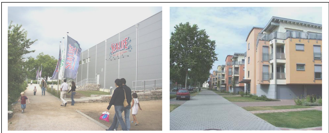
Abbildung 9-5: Aquarium und landseitige Ansicht der Bebauung des alten Landeshafens Speyer
