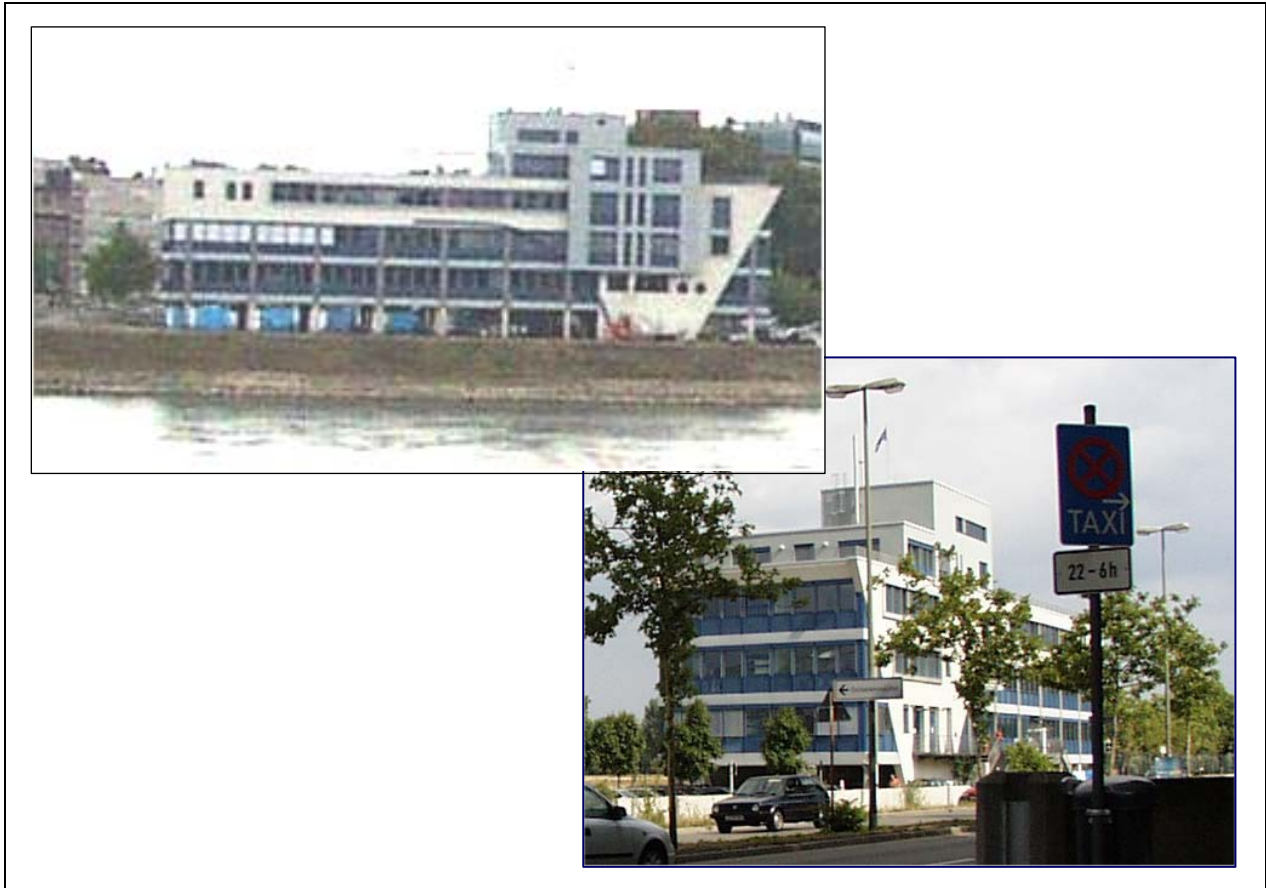
Abbildung 4-16: Aufständering eines Bürogebäudes in Ludwigshafen, Vorteil: Überflutungsflächen bleiben im Hochwasserfall erhalten
