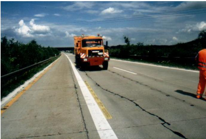
Foto 2.3: Durchgehender Längsriss im rechten Fahrstreifen
