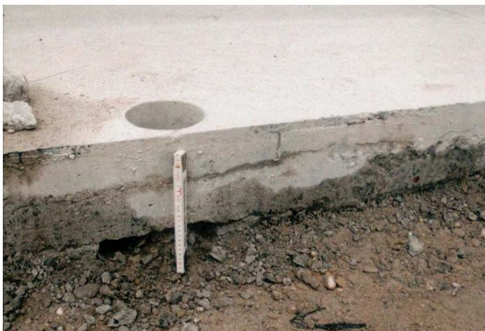
Foto 2.2: In Plattenmitte horizontal verlaufender Riss
