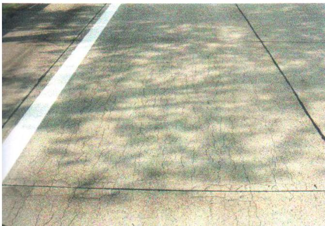
Foto 2.1: Oberflächenlängsrisse (Aufnahme der Baustoff- und Bodenprüfstelle Karlsruhe-Durlach)
