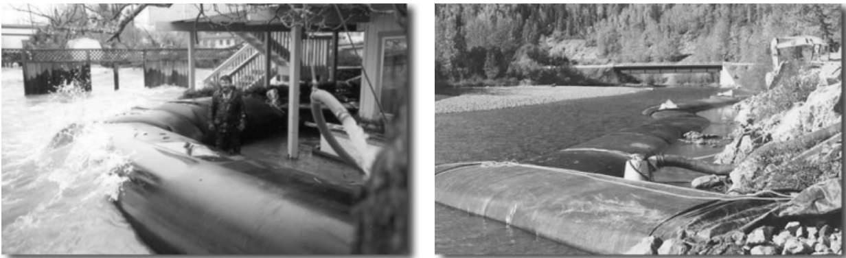
Abbildung 2.20: Anwendungsbeispiele für Schlauchwehre zum temporären Einsatz
