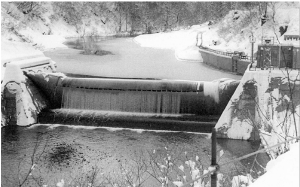
Abbildung 2.4: Luftgefülltes Schlauchwehr am Kurotani Dam, Japan (Schlauchhöhe 6,00 m, Wehrfeldbreite 34,50 m, Inbetriebnahme 1984)
