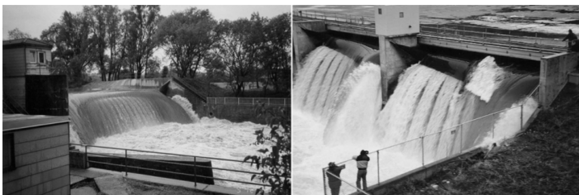
Abbildung 3.2: Wasserkraftanlage Ebenhofen/Wertach (D) und Broadwater Dam, Missouri River (USA) bei Hochwasser
