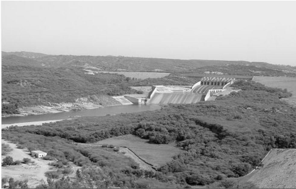
Abbildung A1.18: Mangla Dam, Ansicht vom Unterwasser
