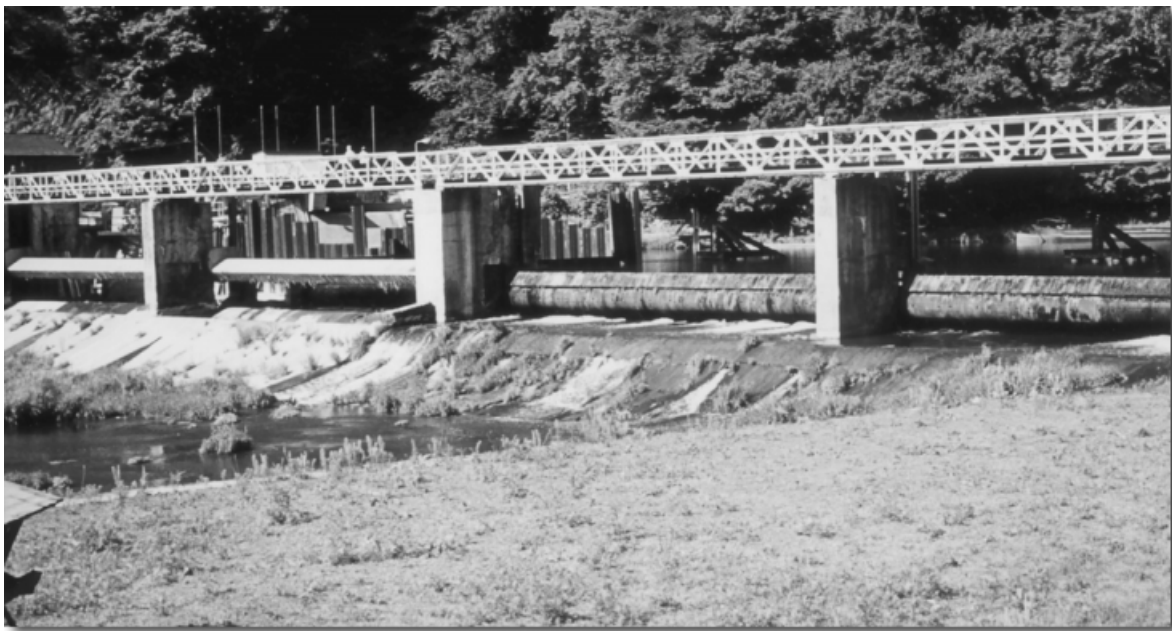
Abbildung A1.6: Blick vom Unterwasser auf die Wehranlage Hollerich mit dem im Bau befindlichen Schlauchwehr vor dem rechten Wehrfeld.
