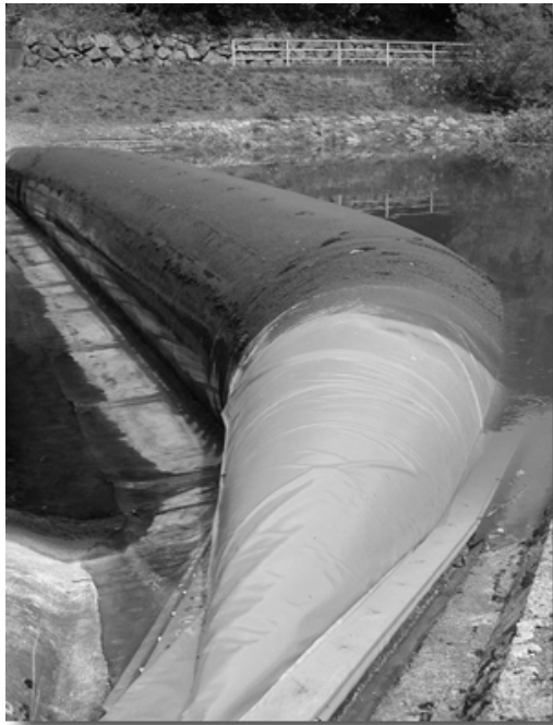
Abbildung A1.3: Ölsperre Hochfelden/Glatt in Betrieb [BAUDIREKTION ZÜRICH 2003], Querschnitt aus CHERVET 1984
