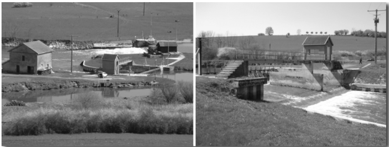
Abbildung A1.14: Staustufe Villers-devant-Mouzon und ehemaliger Standort des Schlauchwehrs
