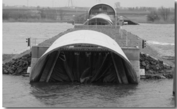
Sturmflutwehr Ramspol, Niederlande (3 x 75,00 m x 8,35 m)
