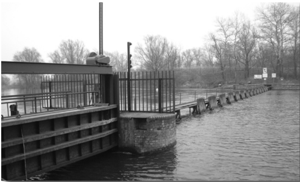
Abbildung 8.8: Staustufe Bahnitz an der Unteren Havel – Ansicht vom Oberwasser auf das Hubschütz und das Nadelwehr
