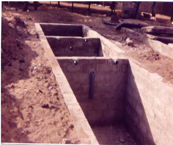
Foto 10: Bau einer septischen Grube
