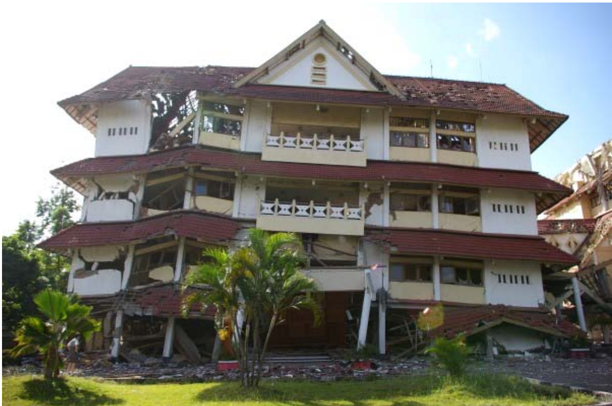
Bild 4-5 Gebäudeansicht mit kollabiertem Erdgeschoss
