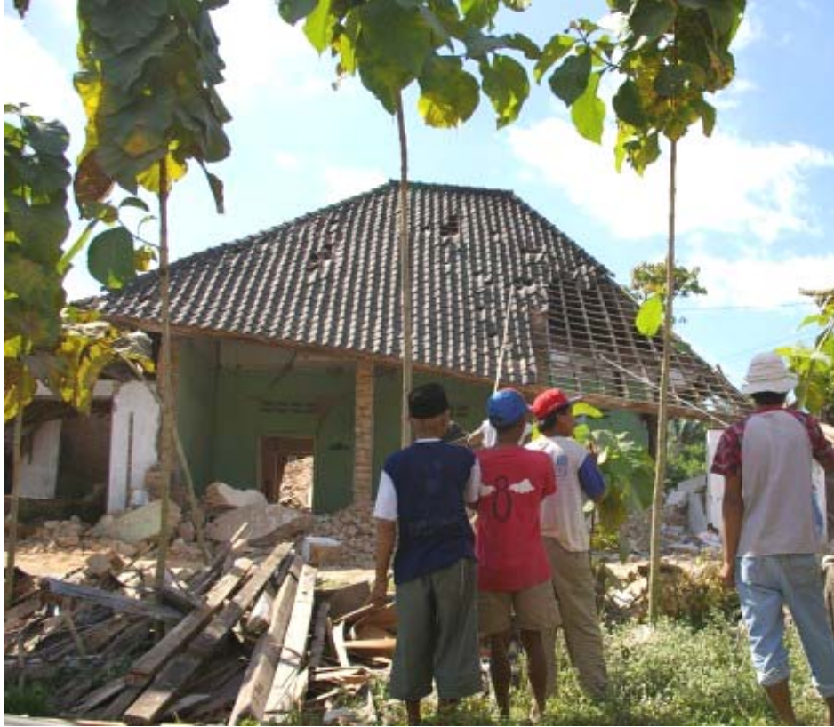
Bild 4-13 ungünstige Massenverteilung aufgrund der schweren Dacheindeckung
