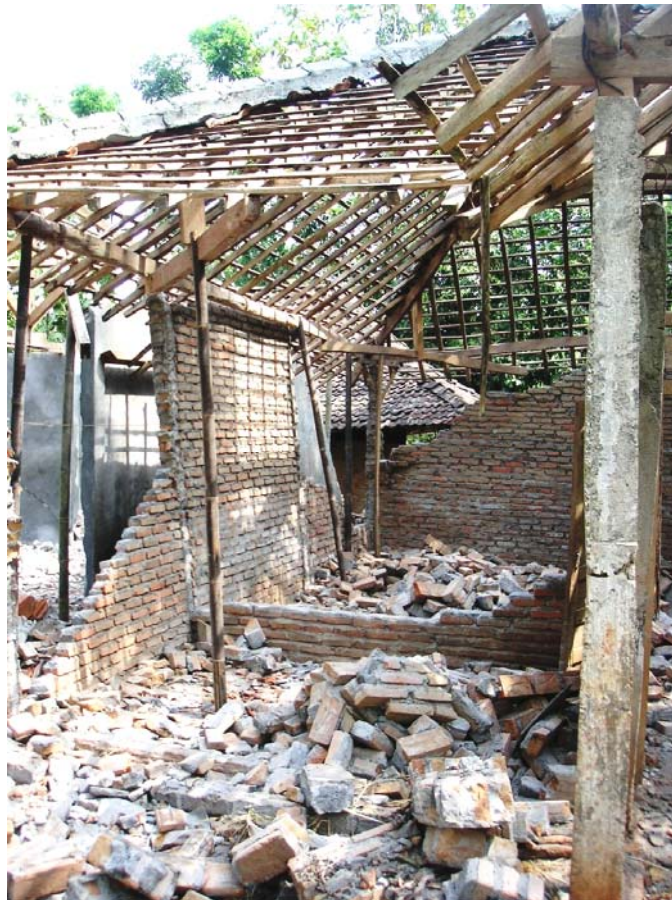
Bild 4-10 kollabierte Mauerwerkswandscheiben
