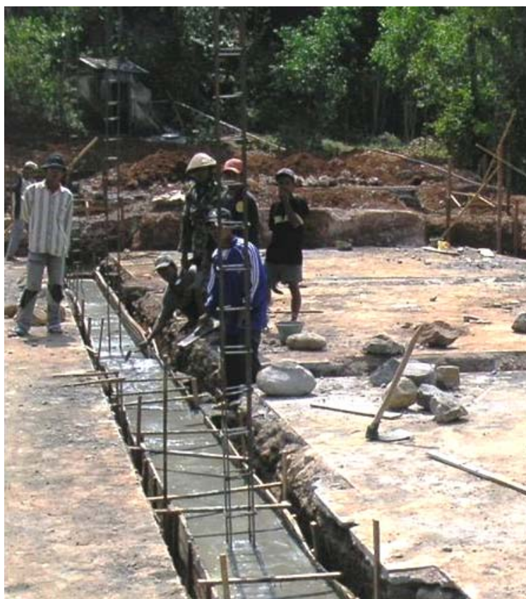
Bild 7-4 Wiederaufbau: Fundamente und Bewehrungsführung
