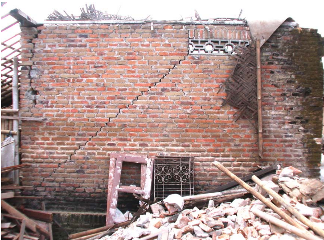
Bild 5-12 a) Versagen der Längswand infolge Biegebruch und b) Schubrisse in der Querwand
