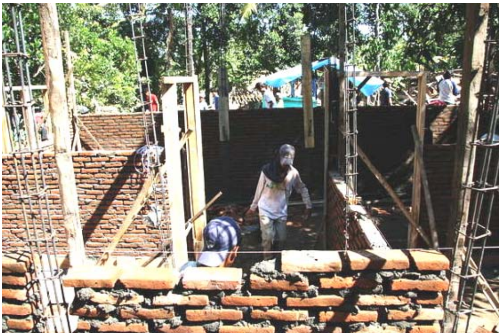
Bild 5-1 Wiederaufbau zerstörter Gebäude ohne Verbesserung der Erdbebensicherheit
