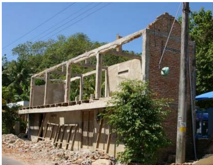
Bild 4-12 ungünstige Bauwerksgeometrien (Steifigkeitssprünge)
