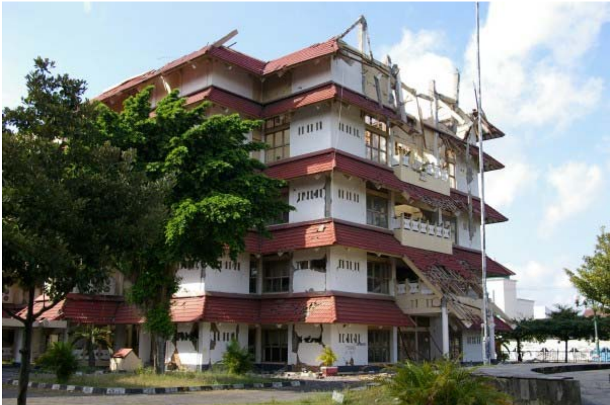
Bild 4-8 Ansicht mit schwer beschädigtem Gebäudeteil
