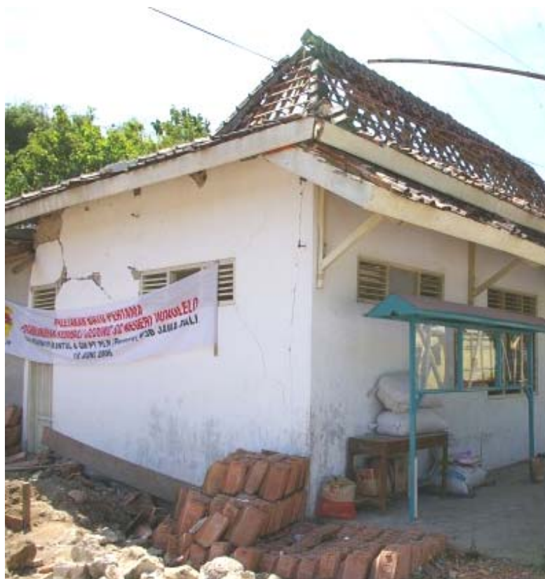
Bild 4-2 nicht-ingenieurmäßig errichtete Bauwerke in Indonesien: Beispiele für typische Mischkonstruktionen
