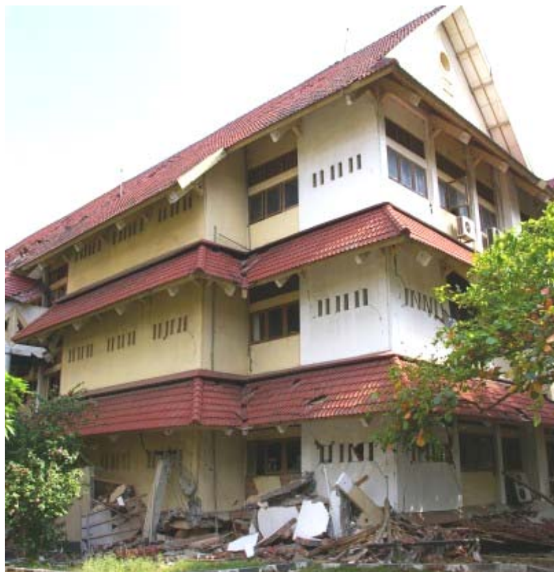
Bild 4-1 Beispiele für typische ingenieurmäßig errichtete Bauwerke in Indonesien
