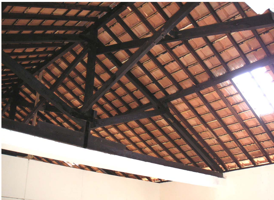
Bild 7-6 Wiederaufbau: Anschluss und Aussteifung der Dachkonstruktion
