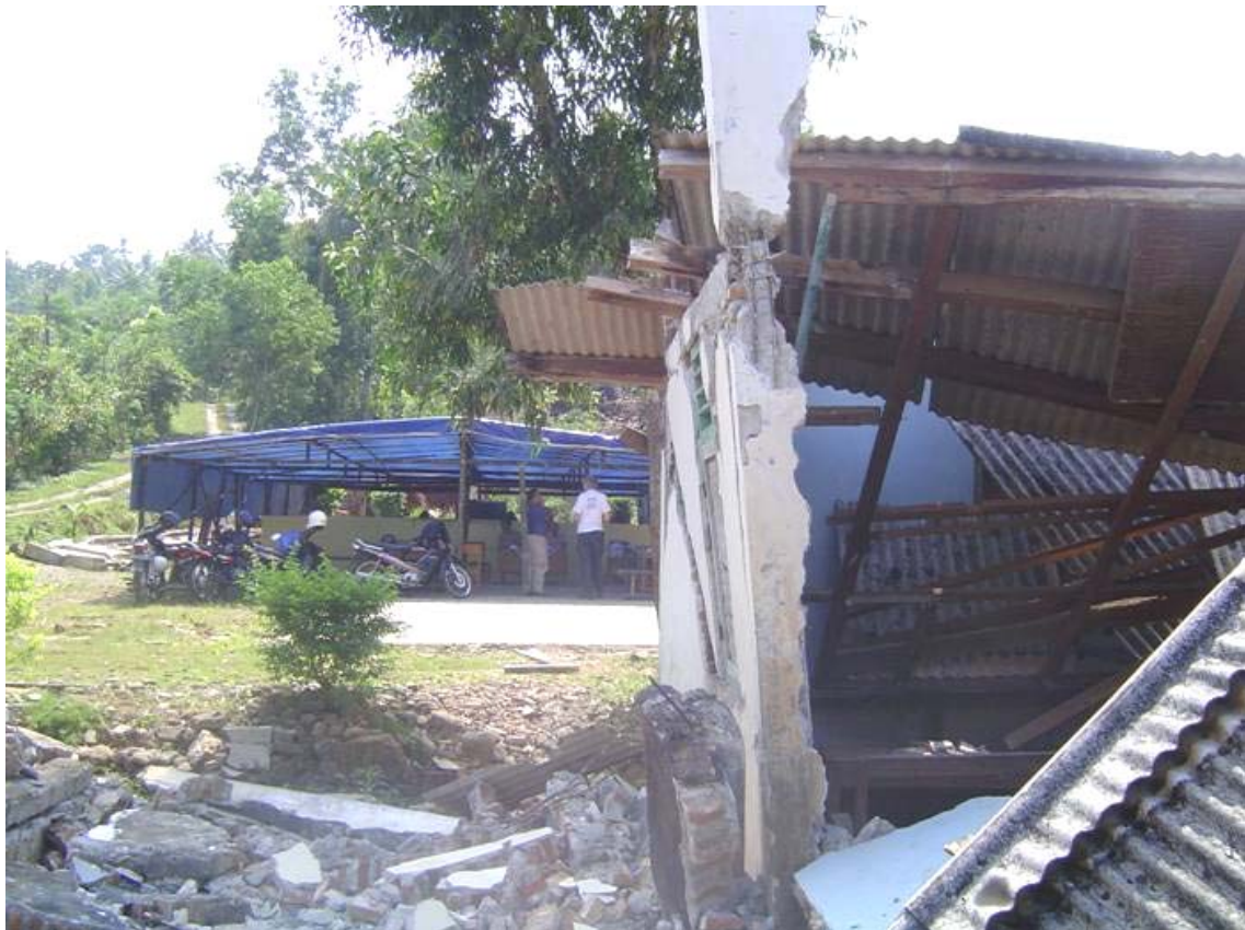
Bild 7-3 Abriss des Schulgebäudes und Notunterkunft
