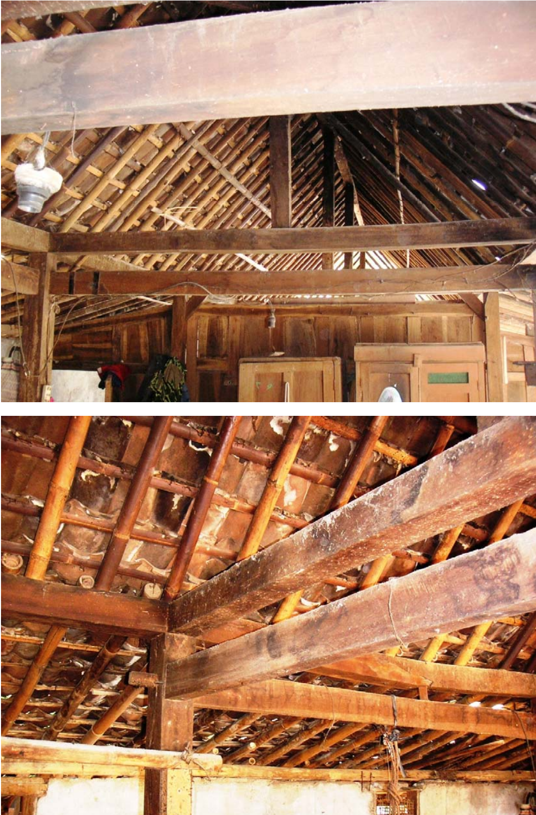
Bild 4-3 nicht-ingenieurmäßig errichtete Bauwerke in Indonesien: Beispiele für die traditionelle Holzbauweise
