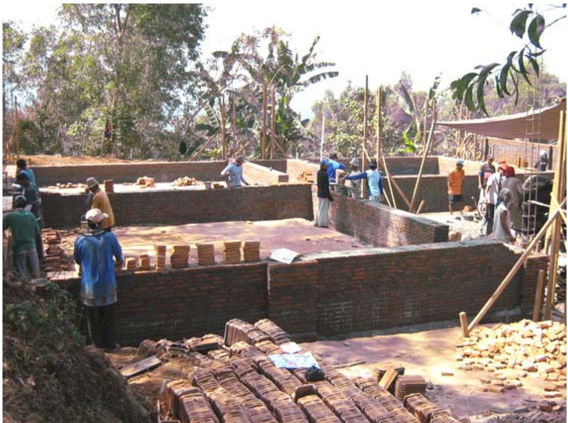
Bild 7-5 Wiederaufbau: Mauerwerk und aussteifende Zwischenwände
