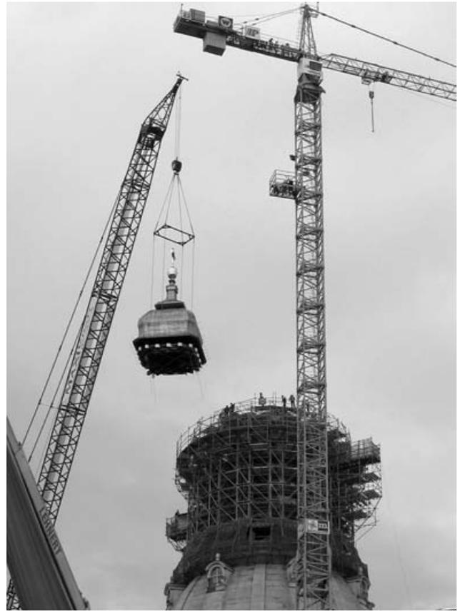
Abb. 9 Der wiedererstandenen Frauenkirche wird die Haube aufgesetzt
