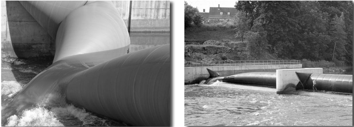
**Abbildung 2.15:** Einknicken bei luftgefüllten Schlauchwehren
