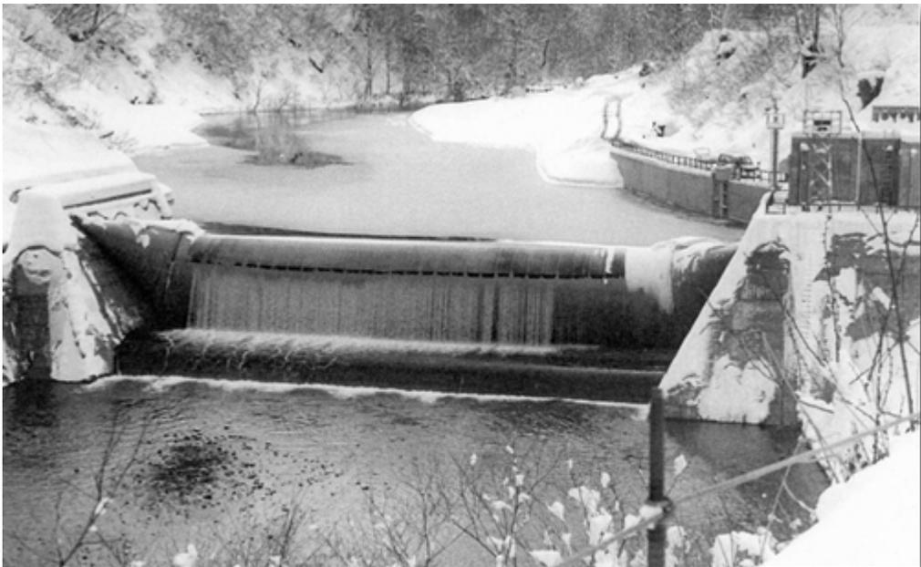
**Abbildung 2.4:** Luftgefülltes Schlauchwehr am Kurotani Dam, Japan (Schlauchhöhe 6,00 m, Wehrfeldbreite 34,50 m, Inbetriebnahme 1984)
