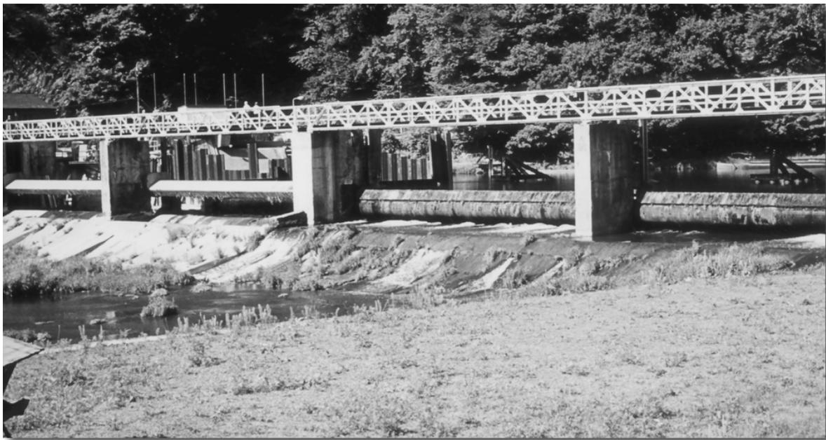
**Abbildung A1.6:** Blick vom Unterwasser auf die Wehranlage Hollerich mit dem im Bau befindlichen Schlauchwehr vor dem rechten Wehrfeld.
