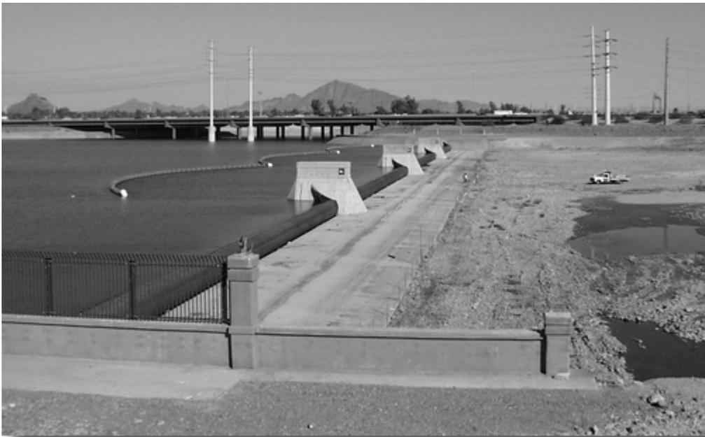
**Abbildung 2.5:** Luftgefülltes Schlauchwehr am Tempe Town Lake, USA (Schlauchhöhe 4,90 m, 4 Wehrfelder à 16,75 m, Inbetriebnahme 1989)
