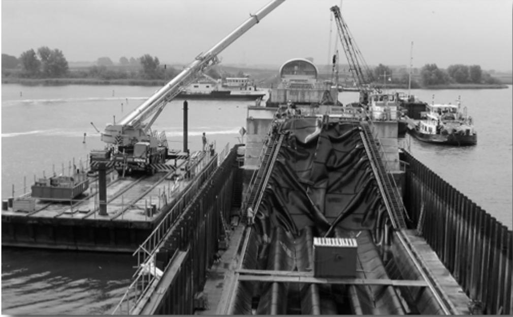
**Abbildung 2.3:** Wasser- und luftgefülltes Schlauchwehr in Ramspol/Overijssel, Niederlande (Schlauchhöhe 8,35 m, 3 Wehrfelder à 75,00 m, Inbetriebnahme 2001)
