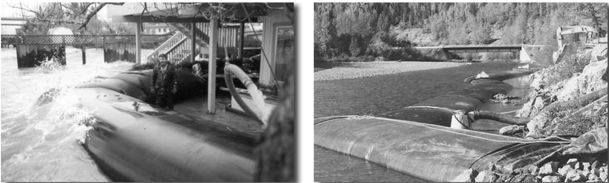
**Abbildung 2.20:** Anwendungsbeispiele für Schlauchwehre zum temporären Einsatz
