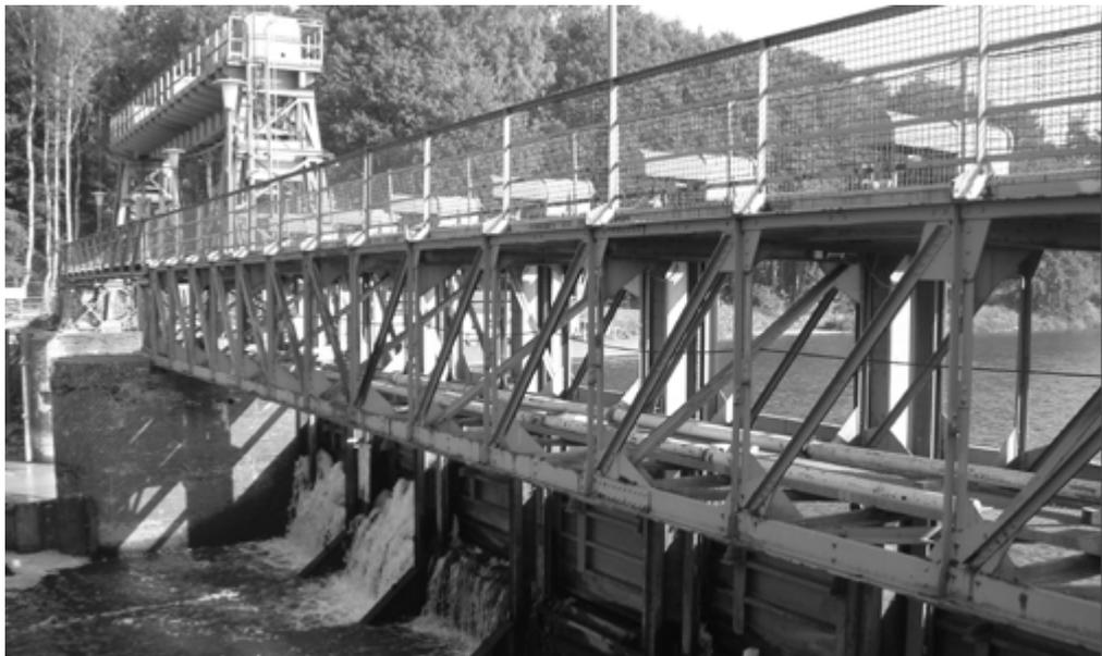
**Abbildung 8.1:** Staustufe Marklendorf an der Aller, Ansicht vom Unterwasser auf den Wehrsteg und die Hakendoppelschütze
