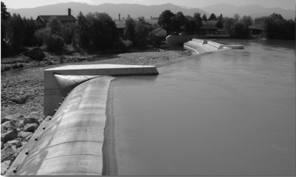
**Abbildung 2.8:** Wassergefülltes Schlauchwehr in Lechbruck, Deutschland (Schlauchhöhe 3,15 m, 3 Wehrfelder à 24,80 m und 1 Wehrfeld à 45,80 m, Inbetriebnahme 2001)
