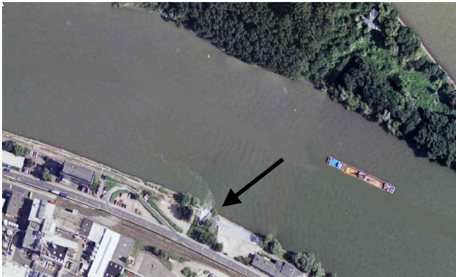
Bild 1: Bestehende seitliche Einleitung des Kraftwerksauslasses in den Mombacher Stromarm, Insel Rettbergsaue, Rhein-km 502,3 (Quelle: LVermGeo, CD-Nr.31)
