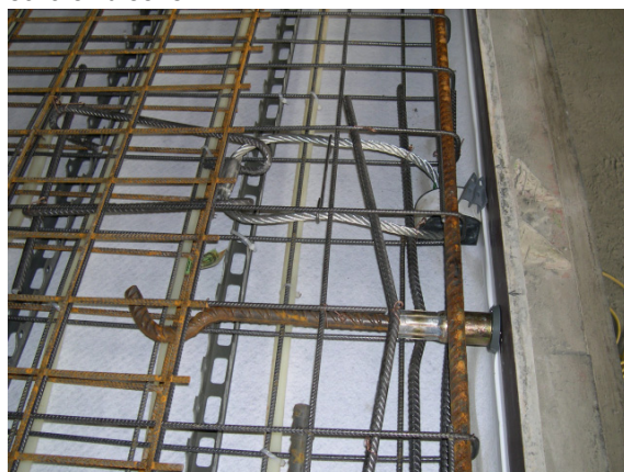
Abb. 5: Transport- und Montageanker
