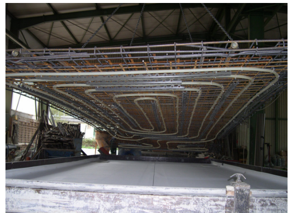
Abb. 8: Einlegen der vorkonfektionierten Bewehrung (mit Absorber und Abstandhalter) in die Stahlschalung auf die bereits eingelegte Dachfolie
