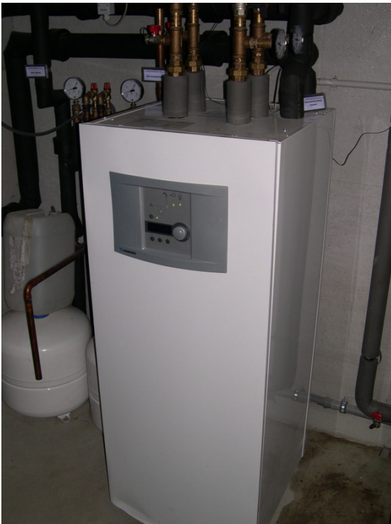
Abb. 17: Sole-Wasser-Wärmepumpe
