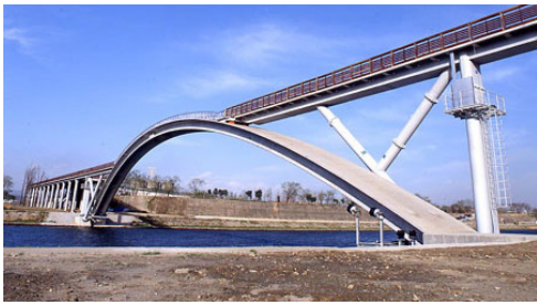
Abb. 9: Seonyu-Fußgängerbrücke in Seoul (Foto: Lafarge)
