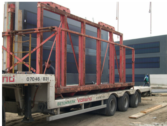
Abb. 4: iRoof-Oberschalen in Transportbox bzw. beim Entladen
