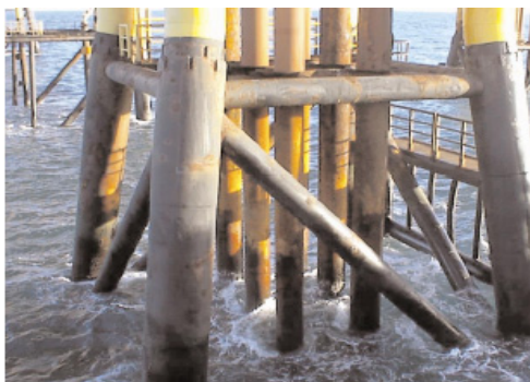
Abb. 10: Offshore-Bauwerk mit Verstärkung der Spritzwasserzone aus ultrahochfestem Beton (Foto: Densit)
