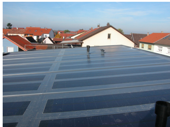
Abb. 1: iRoof-Dachfläche, BV Oberhausen
