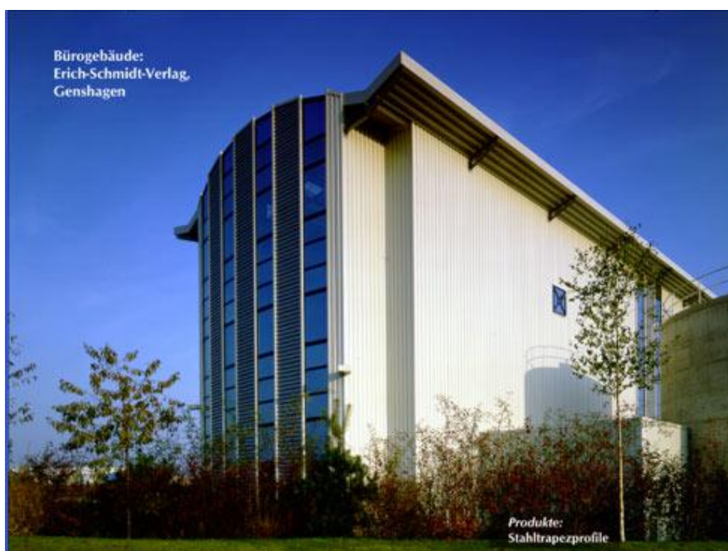
Bild 1.3: Bürogebäude des Erich-Schmidt-Verlags in Genshagen, Fassadenkonstruktion mit Stahltrapezprofilen
