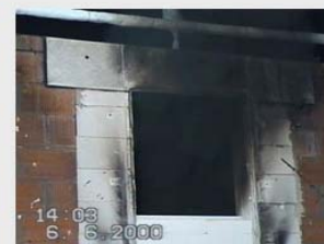
10 min 42 s (nach Zündung) an der Fensteröffnung
