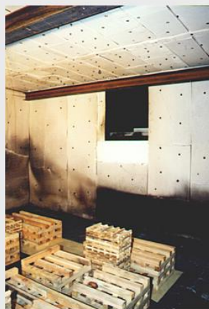
Brandraum mit Stahlträger 1, 2 und Fensteröffnung
