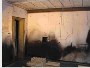
Brandraum mit Stahlträger 3 und Brandraumtür
