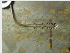
Temperaturmeßstelle am Stahlträger
