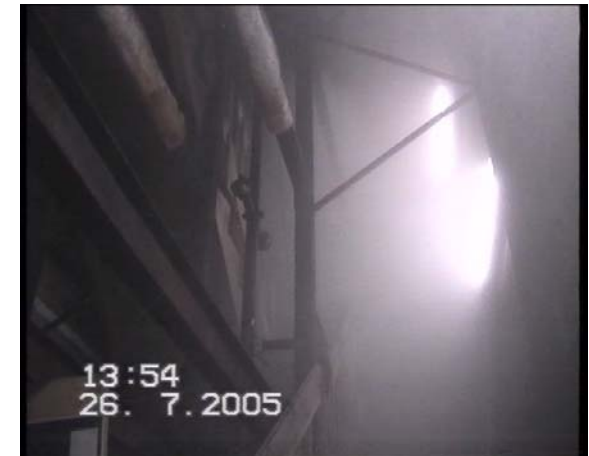
Sprühkopf (4 Düs.) im Treppenraum 135 bar
