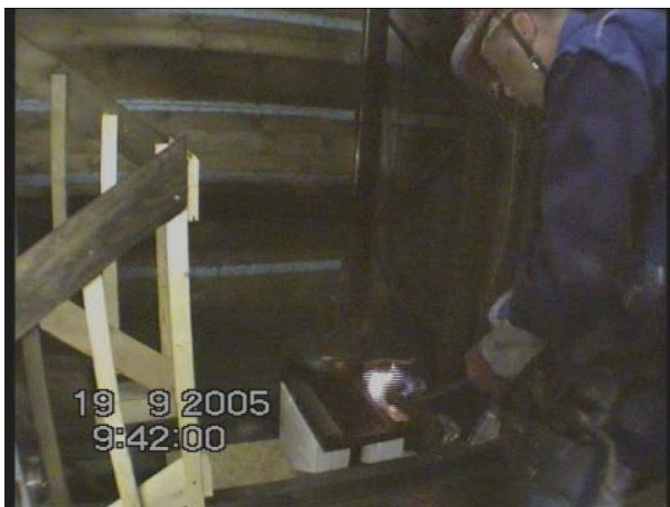
Vorheizen der Bratpfanne mit Pflanzenöl mittels Dachdeckerbrenner
