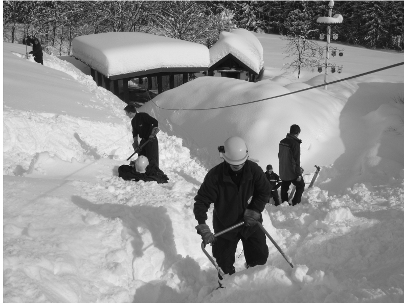
Abbildung 2: Die Schneelasten müssen auf den Dächern per Hand beseitigt werden (Foto: THW-Archiv).
