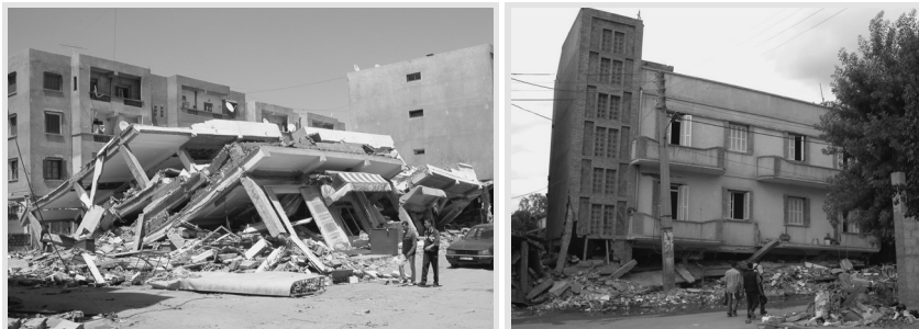
Abbildung 3: Schadenbildgruppen und Beispiel zweier Schadenbilder.
