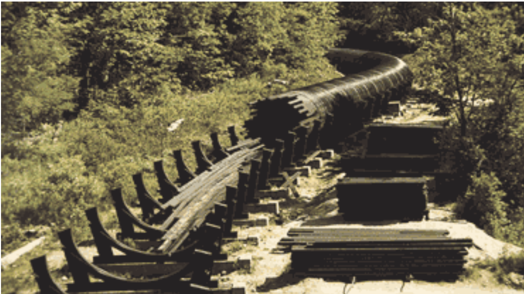
Bild 6-6 aufgelagerte Druckrohrleitung aus Holz (von Boxholm Produktion AB, Canbar Inc.)
