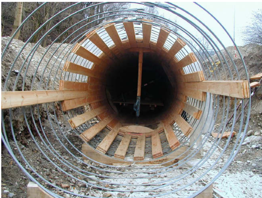
Bild 6-1 Verlegung einer Druckrohrleitung aus Holz (von Zwick Holzbau GmbH)
