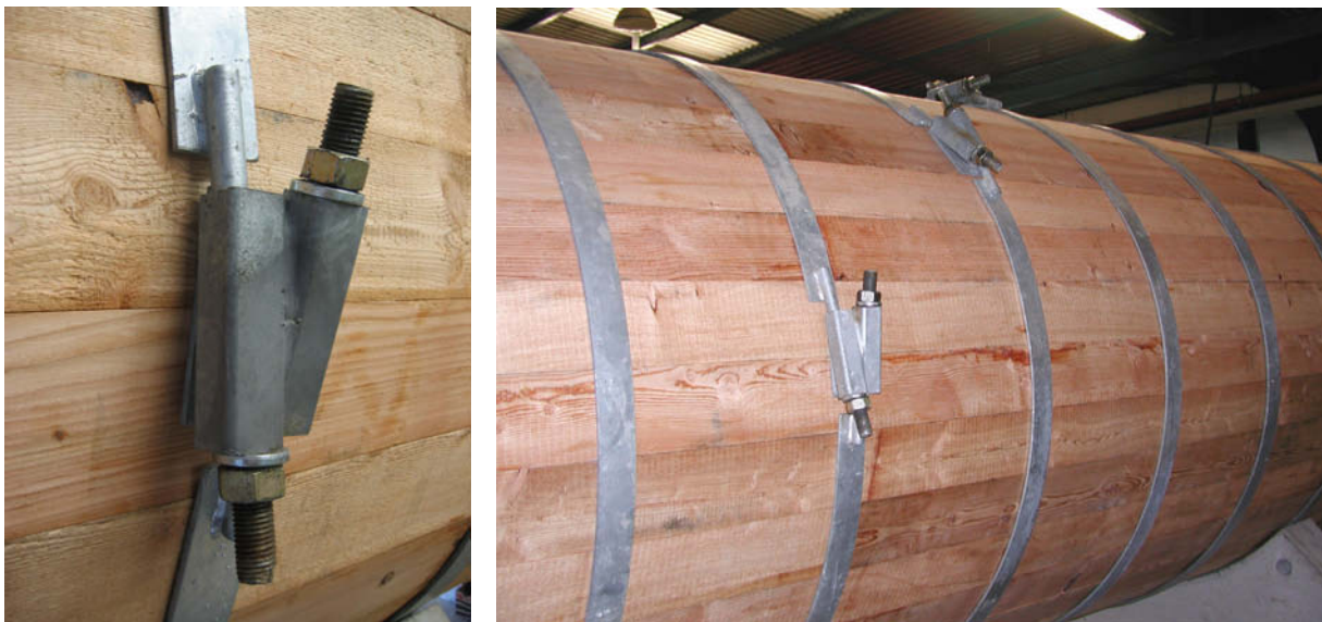
Bild 6-4 Anordnung der Spannringe
