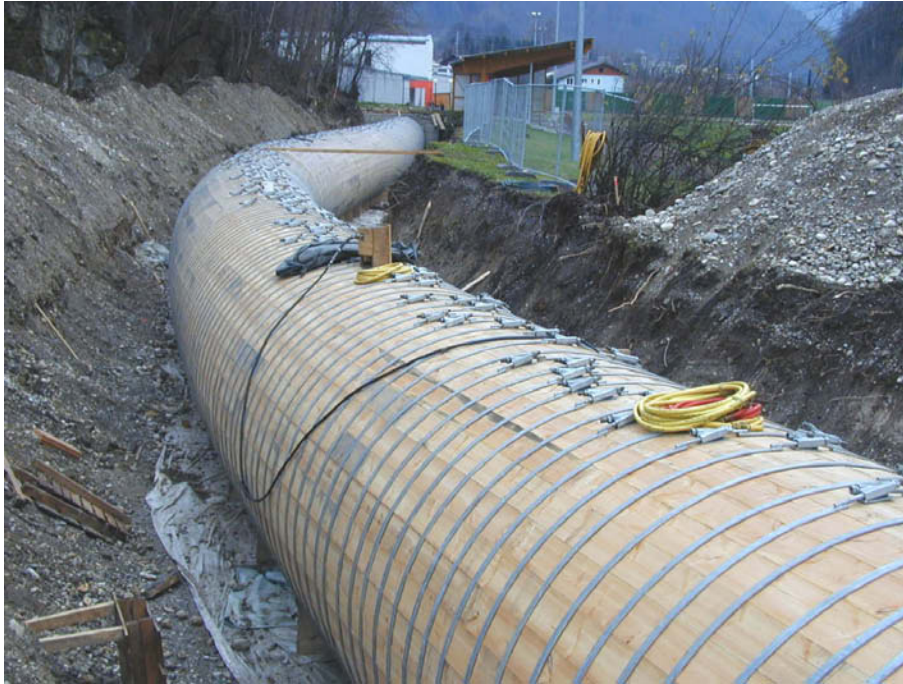
Bild 6-5 Krümmung einer Druckrohrleitung aus Holz (von Zwick Holzbau GmbH)
