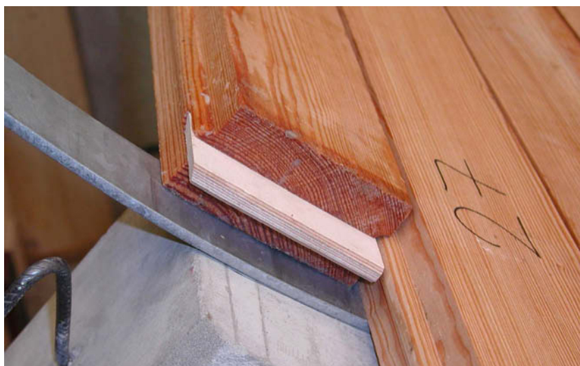
Bild 6-3 Detail Nut- und Federverbindung
