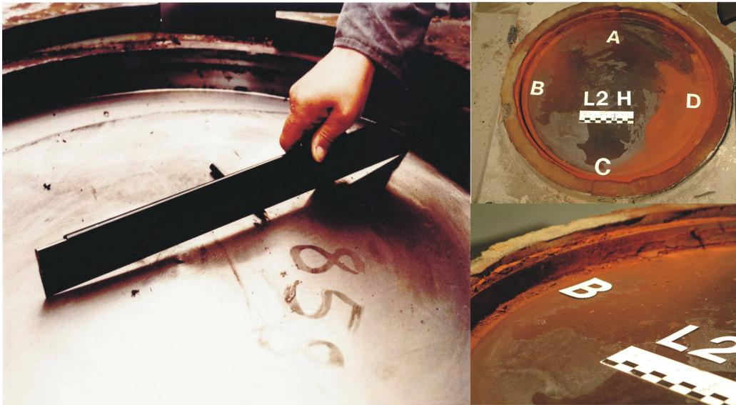
Abbildung 2.6: Plastisch verformter Topfboden nach dem Lagerwechsel [55]; Korrosion durch Feuchtigkeitseintritt [70]
