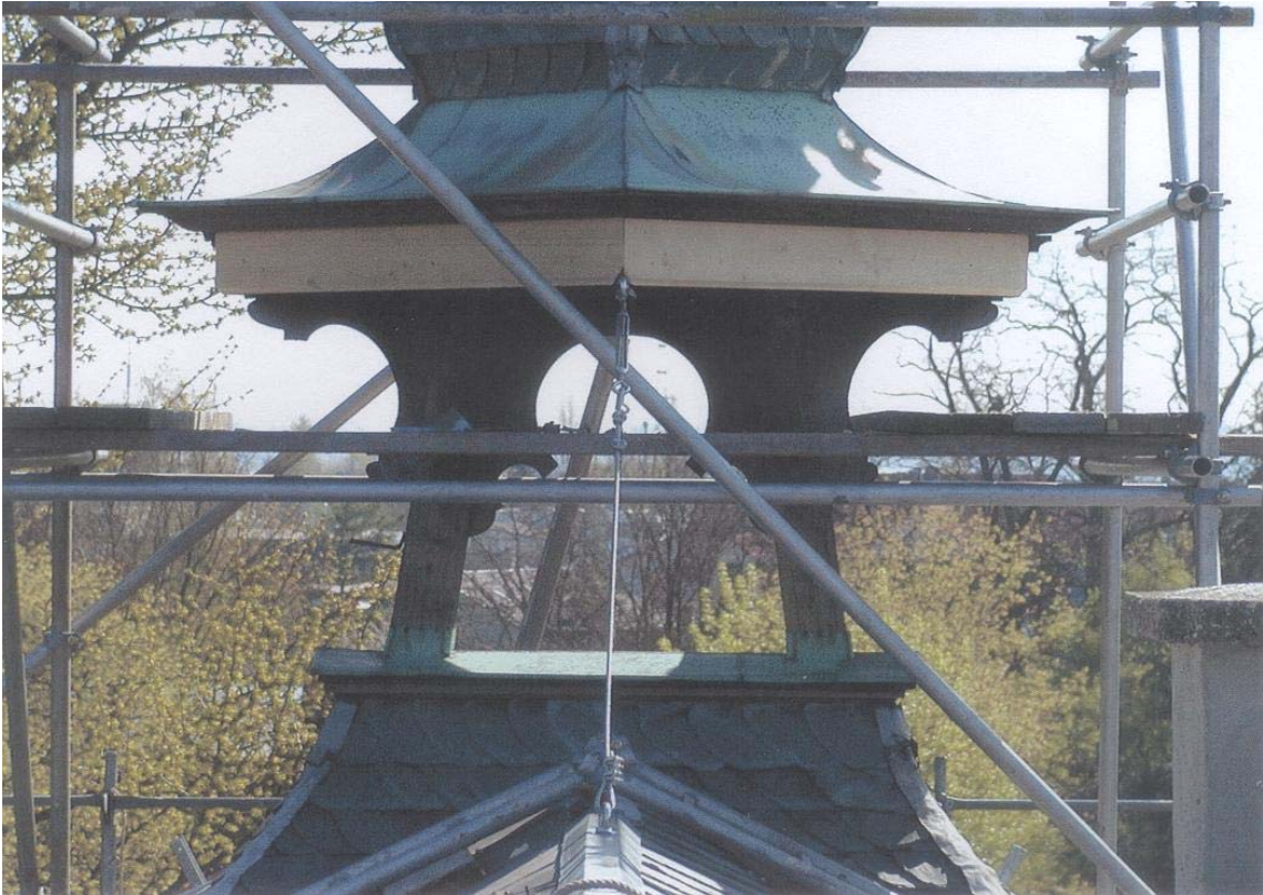
232: Villa Amann, erneuerte Verspannungsseile am Glockentürmchen aus Stahl. Aufnahme während der Restaurierung 2001.
