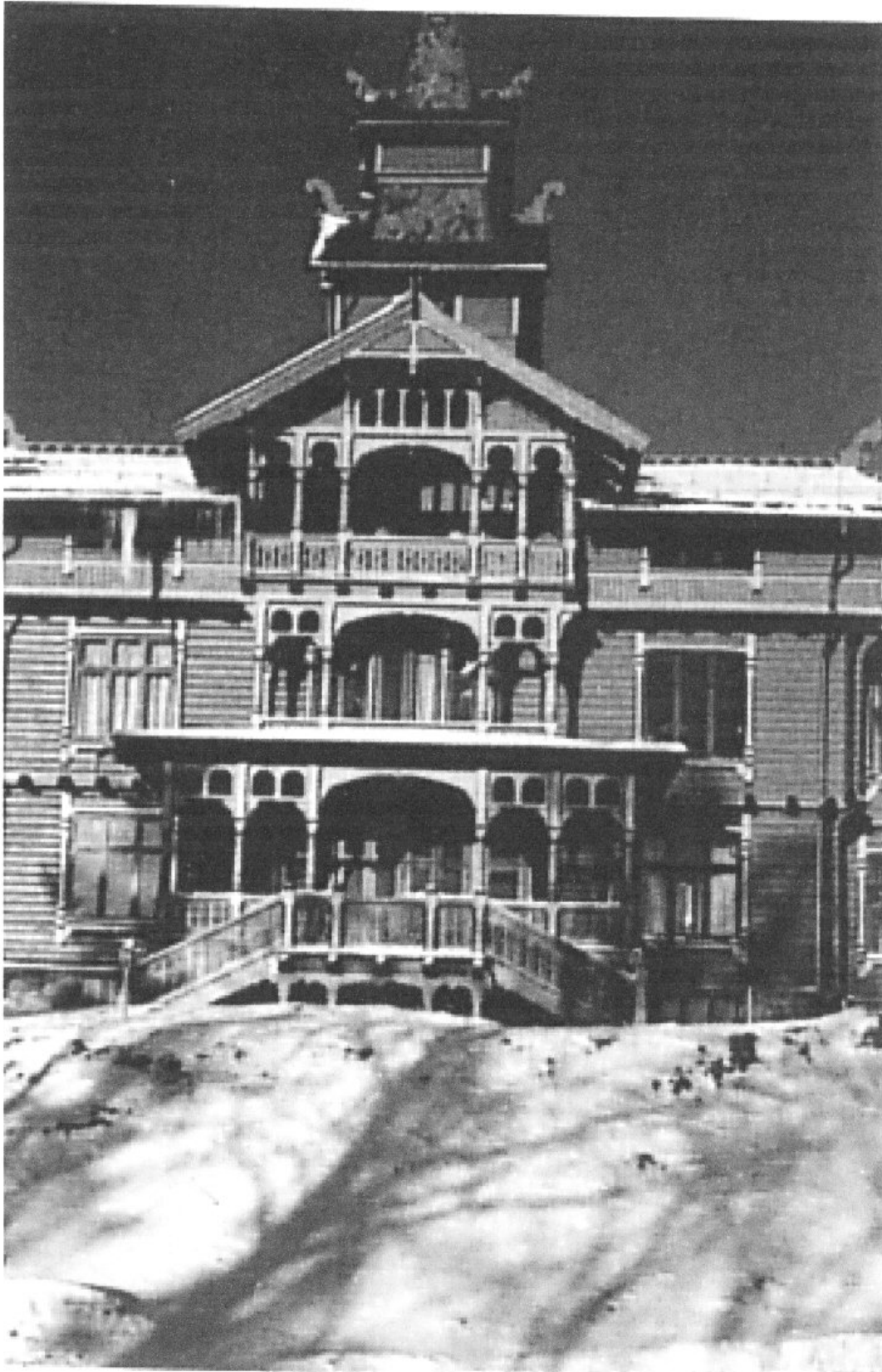
308: Holmenkollen bei Oslo, Sanatorium (heute Holmenkollen Park Hotel), erbaut 1892-1896 von B. Lange, Haupteingang.
