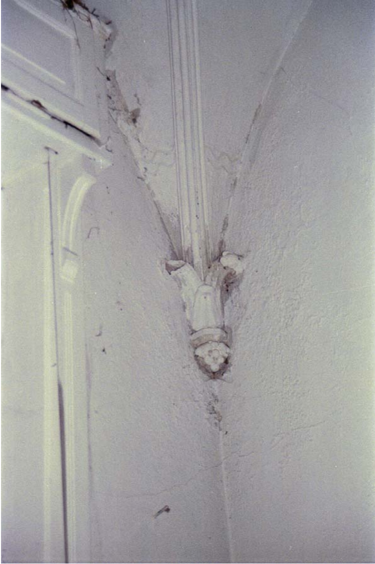
129: Villa Amann, Gästebad (R27), Detail einer Blattkonsole des Stuckgewölbes.
