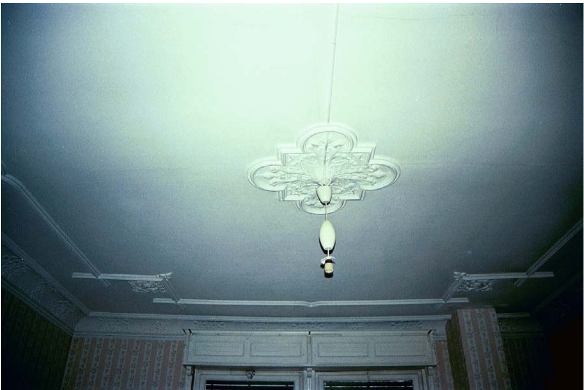
138: Villa Amann, Erstes Gästezimmer (R28), Plafond.
