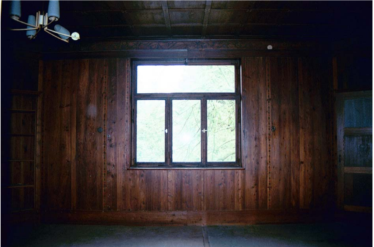
153: Villa Amann, Neues Gästezimmer (R33), Blick nach Nordosten.
