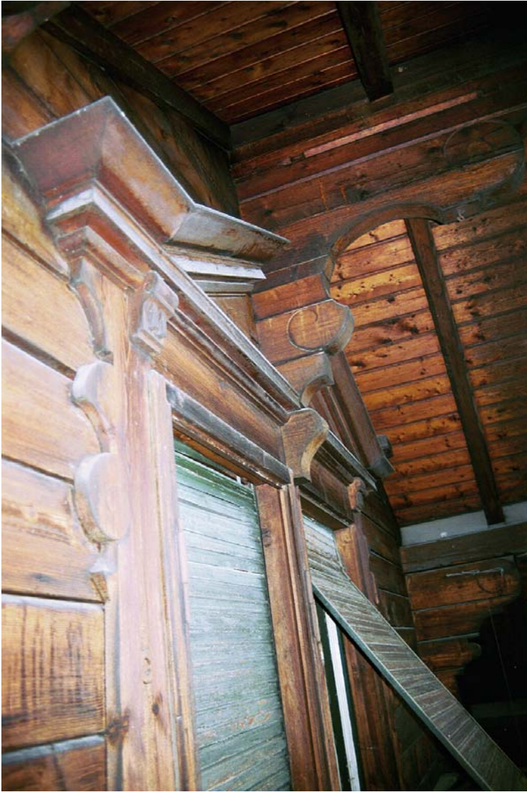
38: Villa Amann, Detail der Zwillingsfenster (links Fenstertür) des Dachgeschosses.
