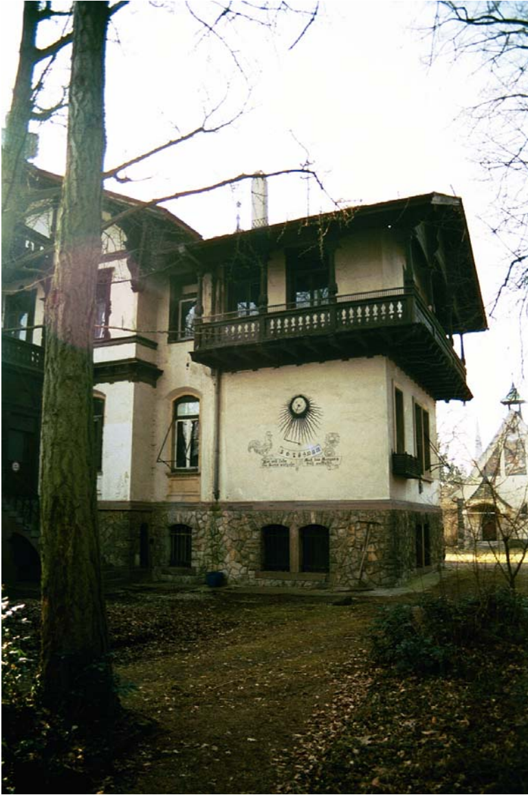
44: Villa Amann, Blick von Osten auf den Küchentrakt und den anschließenden östlichen Giebelrisalit. Die Nahtstelle dazwischen bildet eine zweigeschossige Rücklage, die bis zur Erhöhung des Küchentraktes durch eine dritte Abtreppung des östlichen Dachwalmes geschickt kaschiert war.
