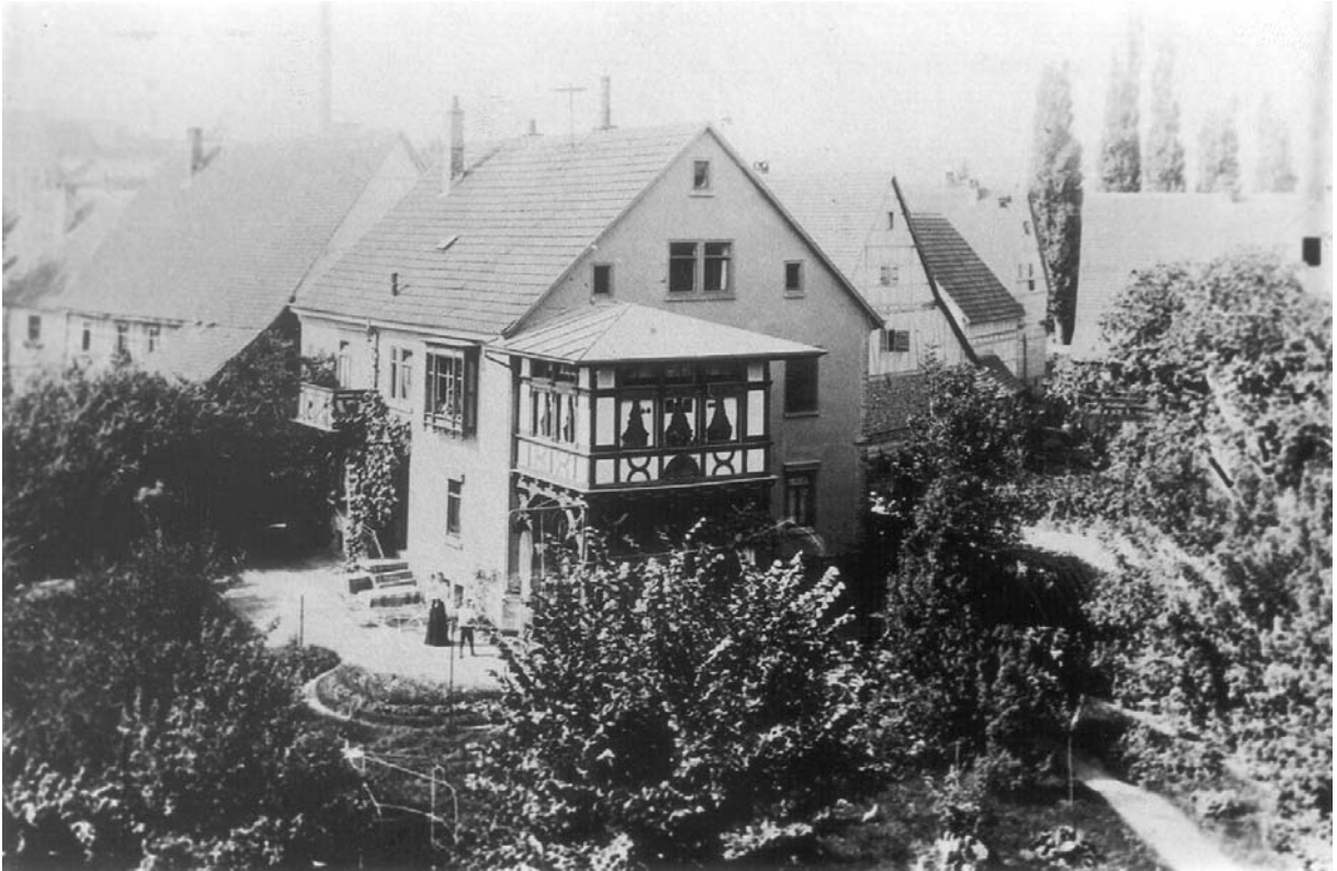
15: Bönningheim, Poststr. 6, erstes Wohnhaus von Alfred Amann um 1904. Das 1890 von Steinhauermeister und Bauunternehmer Christian Etzel zum Zweck des Verkaufs erbaute zweistöckige Gebäude wurde von Alfred Amann erworben und durch die große Veranda, den Fenstererker und einen Balkon zum Garten hin "malerisch" umgestaltet .
