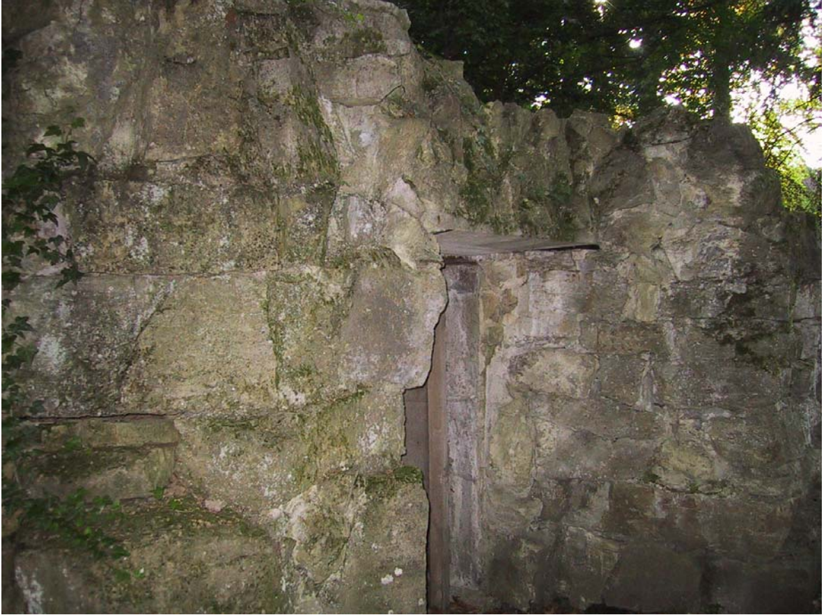
217: Villenanwesen Amann, Eingang zum Eiskeller im Ruinenbau des sog. Märchenwaldes.
