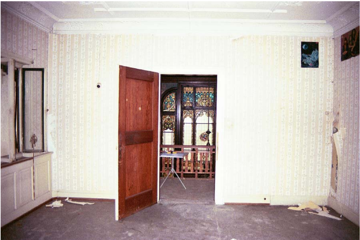
136: Villa Amann, Erstes Gästezimmer (R28) mit Blick auf das Panoramafenster in der Halle.
