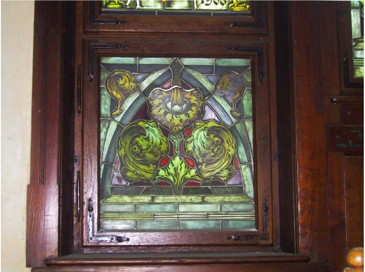
98: Villa Amann, Unterfenster des linken Fensterteils am Panoramafenster der Treppenhalle.
