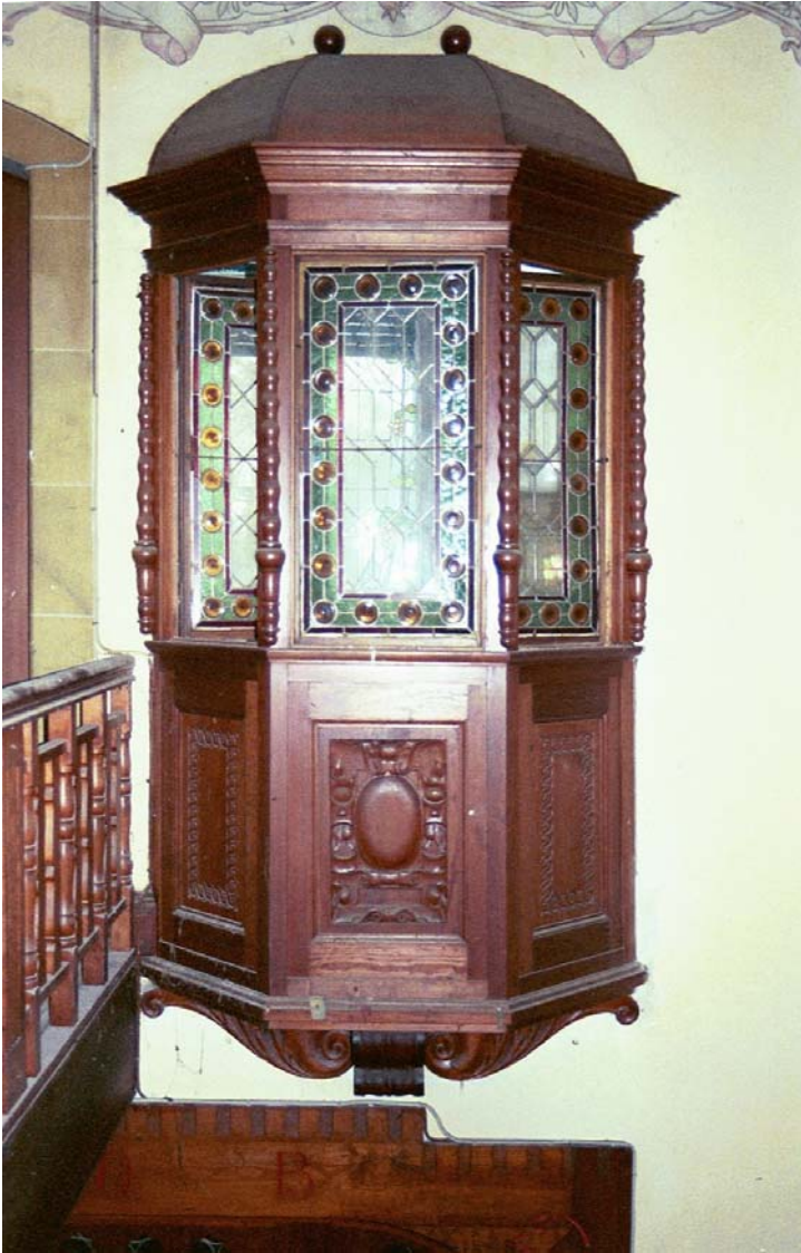
128: Villa Amann, Detail des Erkers an der Westwand der Halle.
