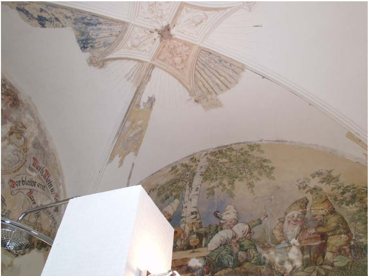
130: Villa Amann, Gästebad (R27), freigelegte Sondagen an der Decke und Wandgemälde.
