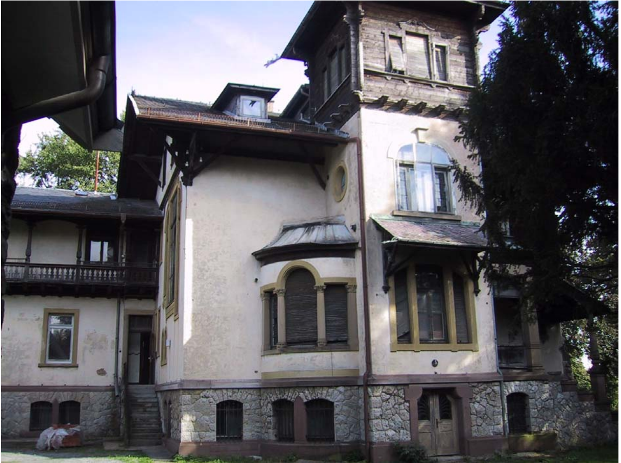
53: Villa Amann, Blick auf Sockel-, Erd- und Obergeschoß der westlichen Turmfassade.
