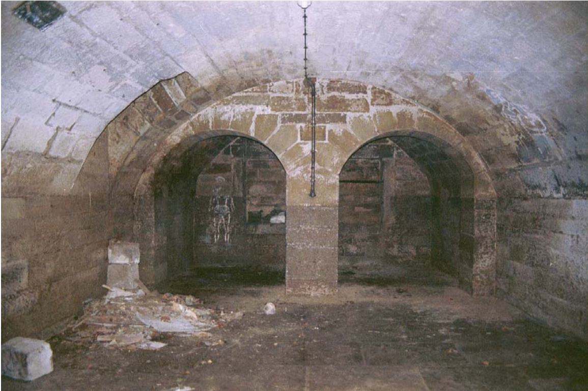
73: Villa Amann, Gewölbekeller nach Süden, unter dem Sockelgeschoß (R10+R11) gelegen.
