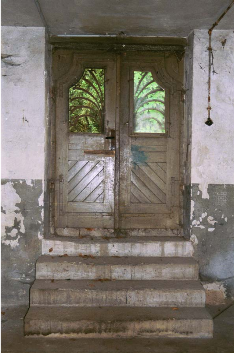
68: Villa Amann, Vorraum im Sockelgeschoß (R1), Blick vom Haupteingang zu den Räumen des Untergeschosses.
