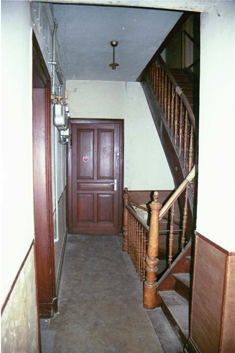
157: Villa Amann, oberer Nebenflur mit Treppe ins Dach- bzw. Erdgeschoß (R34).
