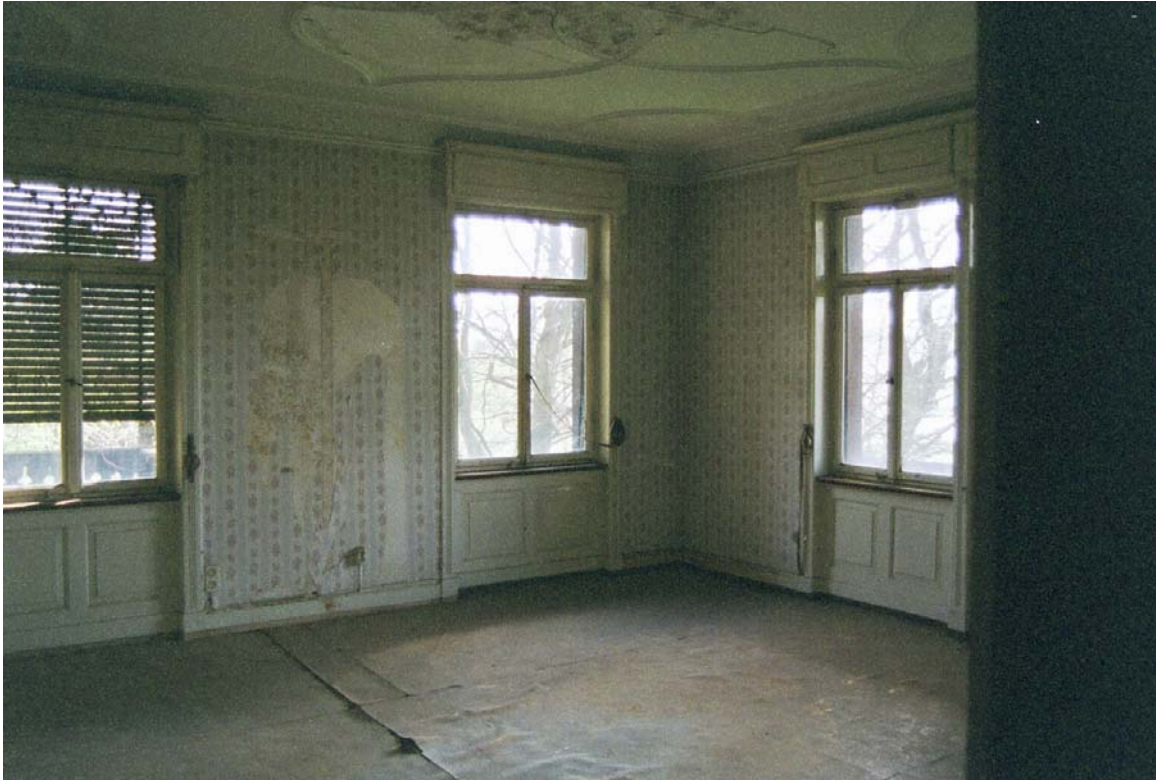
143: Villa Amann, Schlafzimmer (R30), Blick nach Südosten.
