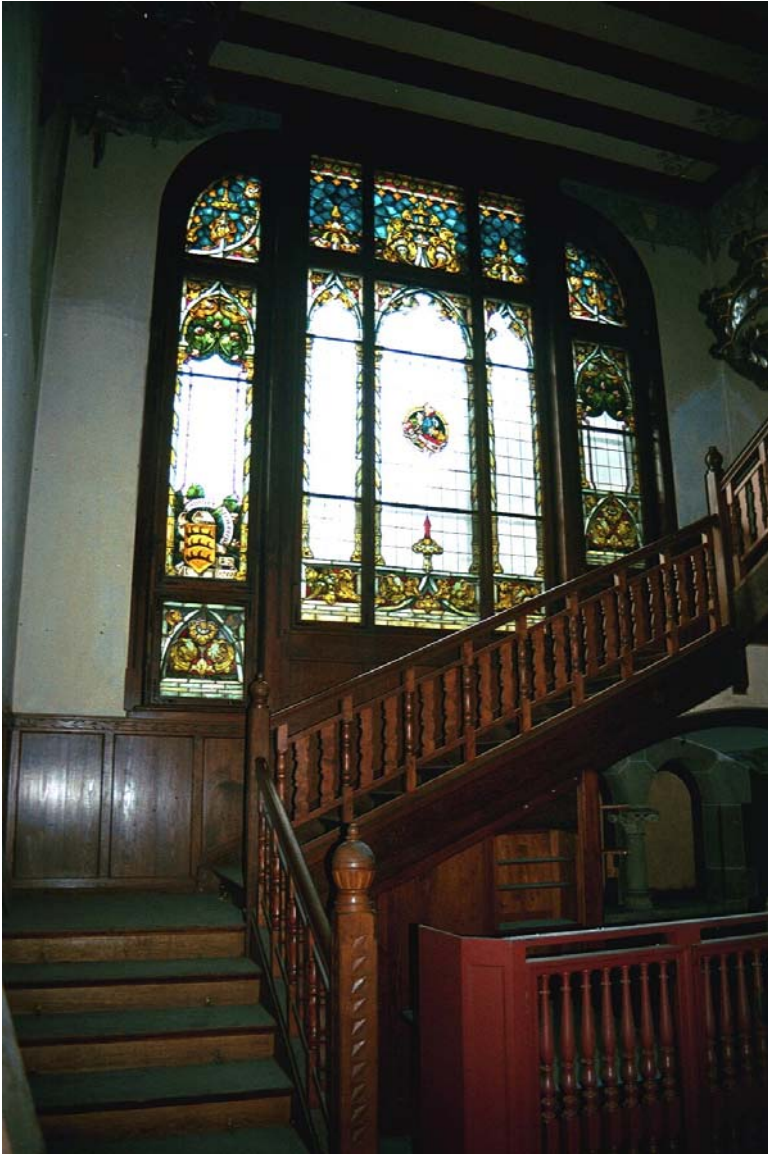
96: Villa Amann, Panoramafenster im Treppenhaus der Halle (R17b).
