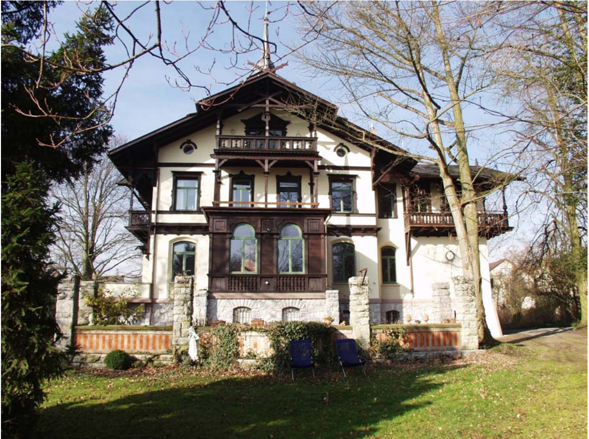
207: Villa Amann, östliche Giebelfront mit angefügter zweigeteilter Pergola im Sockelgeschoßbereich nach der Sanierung (Bedachung und Füllungen aus Holz bereits entfernt).
