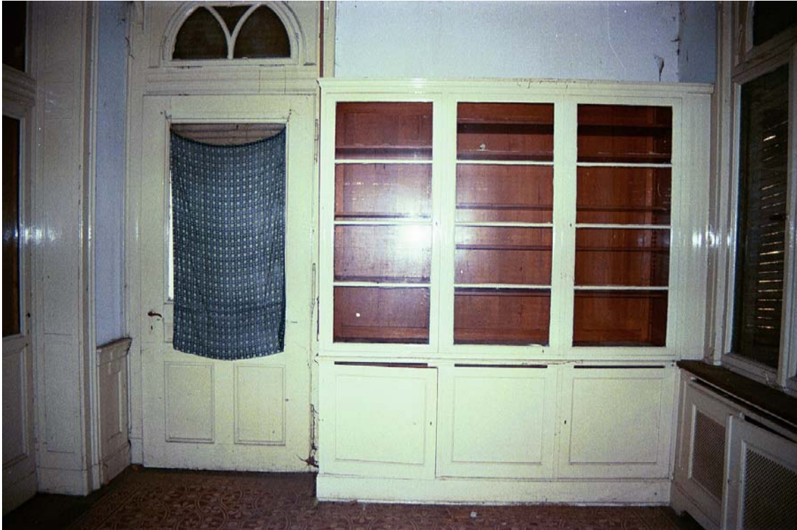
116: Villa Amann, Wintergarten (R21), Blick auf die Nordwand mit nachträglich eingebautem
