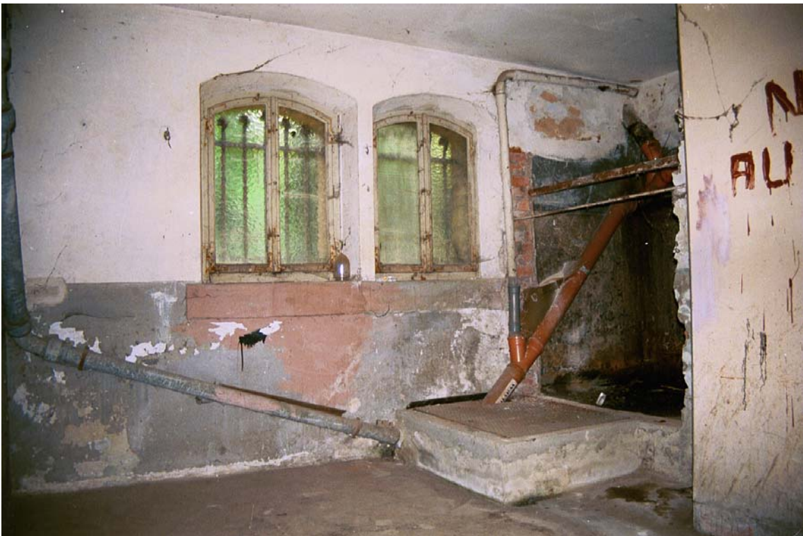
74: Villa Amann, Waschküche im Sockelgeschoß (R14), Blick auf den Standort des ehemaligen Kupferkessels zum Waschen, davor der Abflußschacht.
