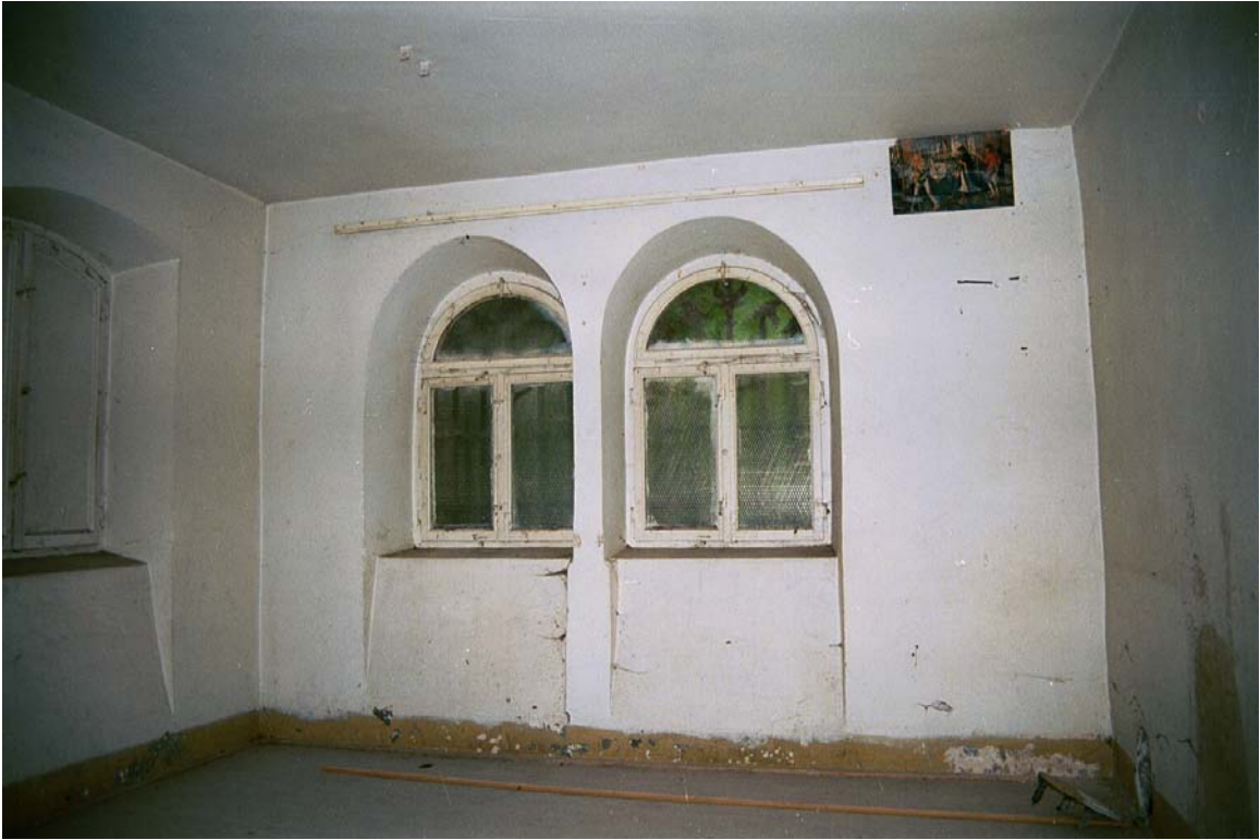
71: Villa Amann, Gärtnerzimmer im Sockelgeschoß (R12), Befensterung nach Süden.
