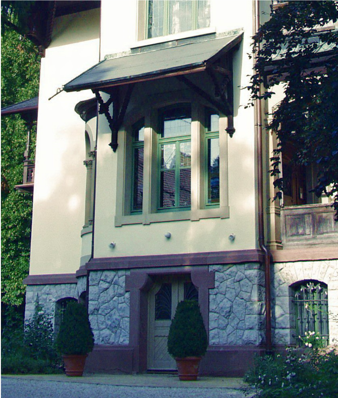
54: Villa Amann, Detail des Vordaches und Erdgeschoßfensters an der Westfront des Turmes.
