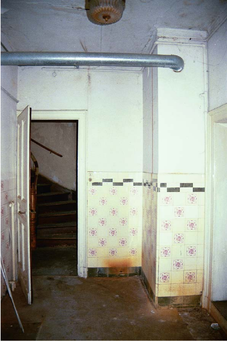
150: Villa Amann, Privater Baderaum (R32), Blick auf die Ausgangstür zum Nebenflur (R34) mit Treppenhaus ins Dachgeschoß.
