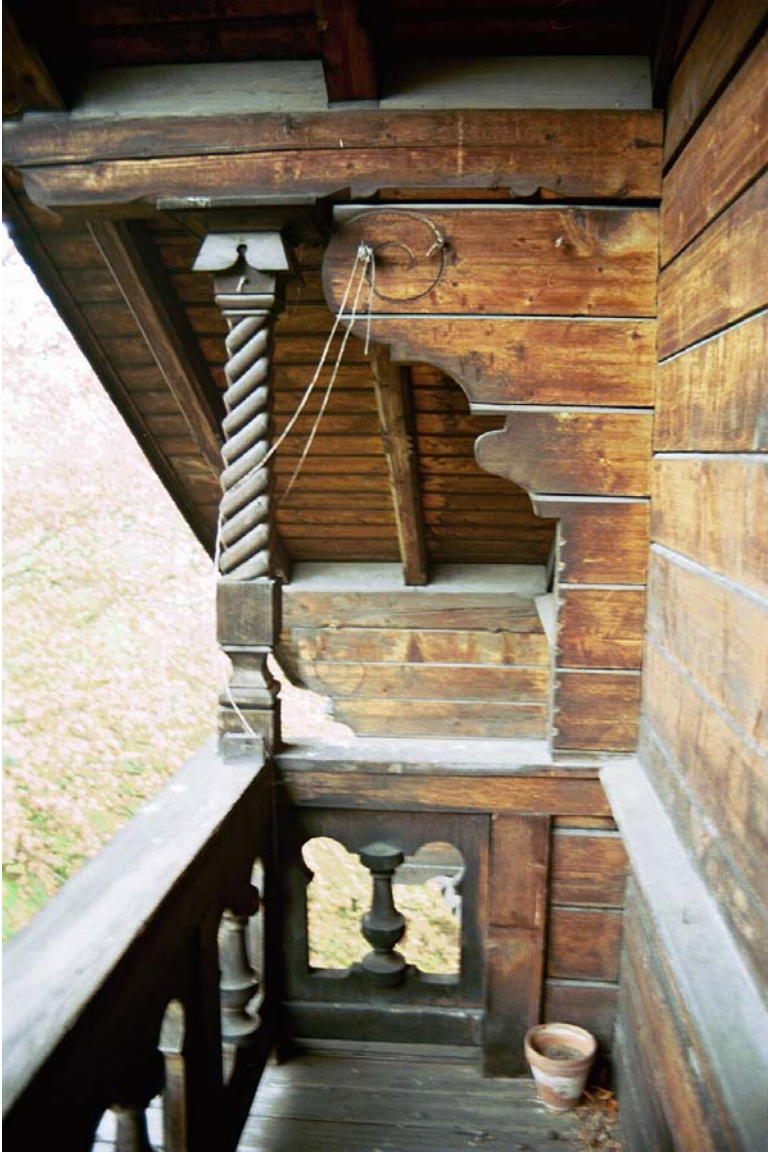
37: Villa Amann, Blick auf die Südwestecke der Dachgeschoßblockwand vom Balkon aus.
