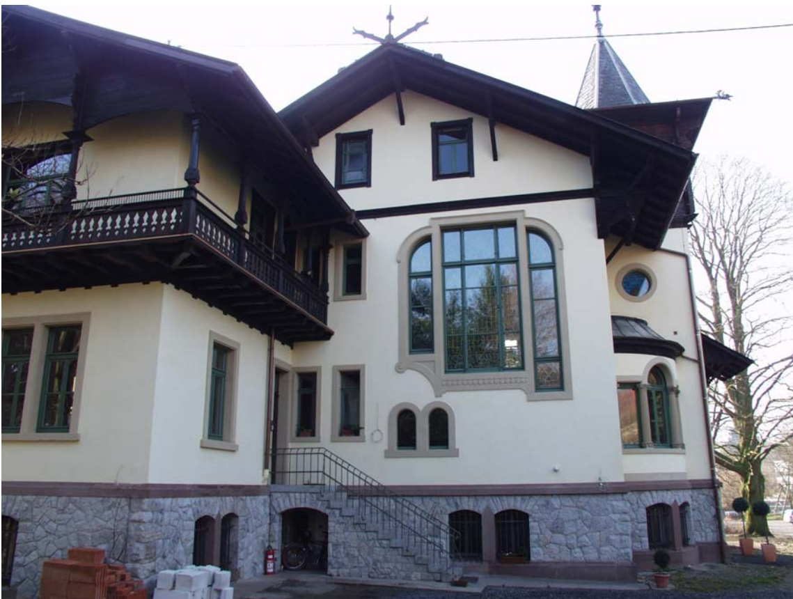
233: Villa Amann, Nordseite mit rekonstruierter Originalfassung der Farbgebung auf Putzflächen und Fensterrahmung. Aufnahme nach der Restaurierung, 2002.
