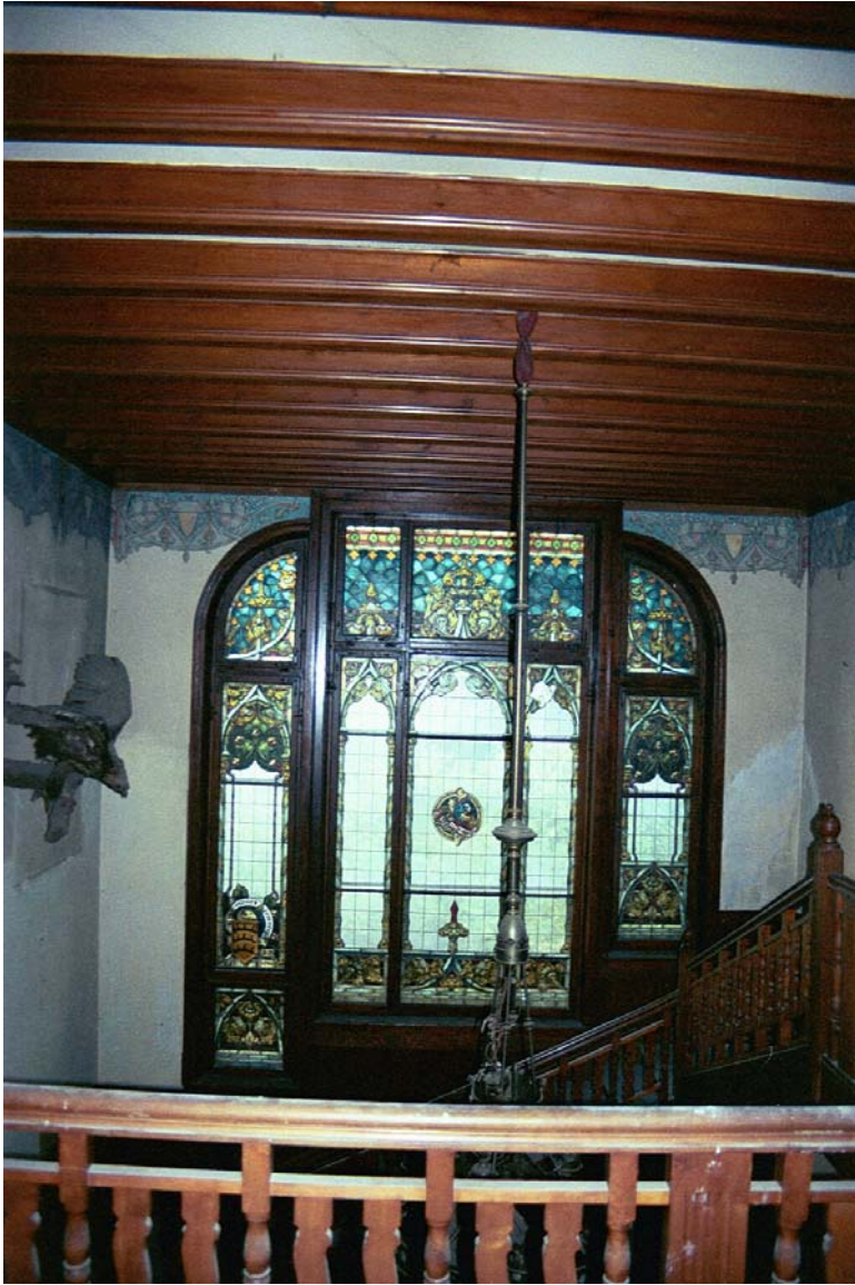
91: Villa Amann, Blick auf Decke und Panoramafenster in der Treppenhalle (R17b).
