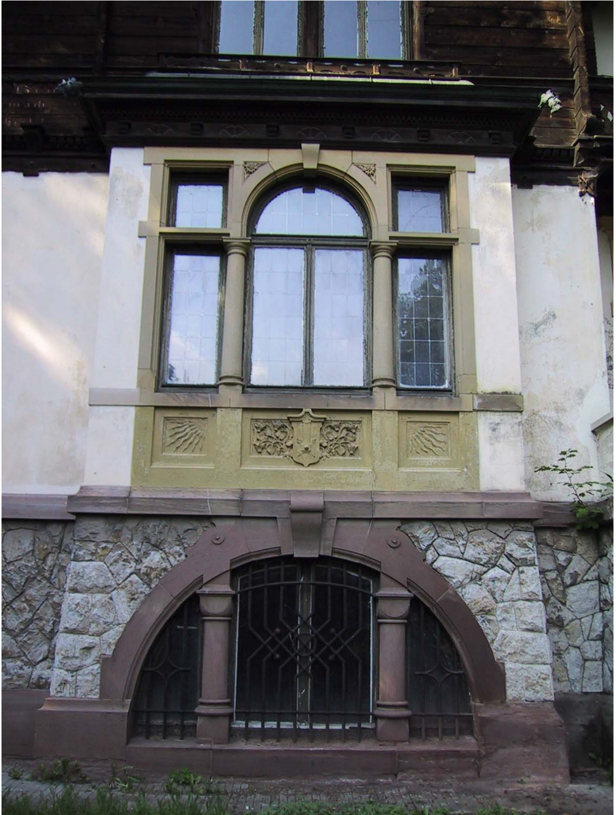
41: Villa Amann, Südfassade, Vorbau-Befensterung des Erdgeschosses.
