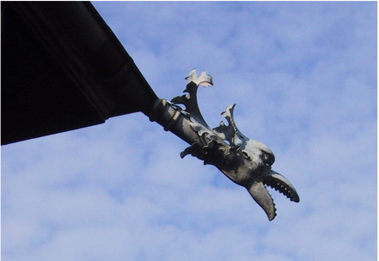
56: Villa Amann, blecherner Wasserspeier in Form eines Drachens am Turm.
