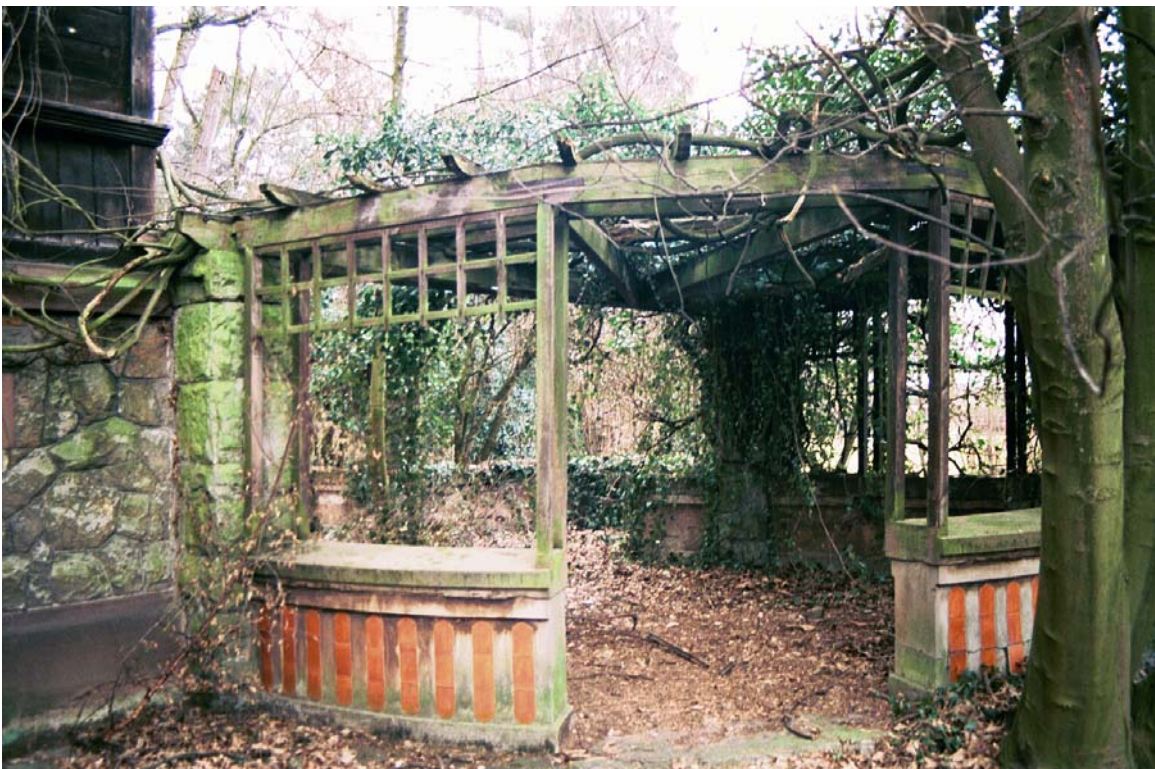
208: Villa Amann, südlicher Pergolabereich der Ostseite vor der Sanierung.
