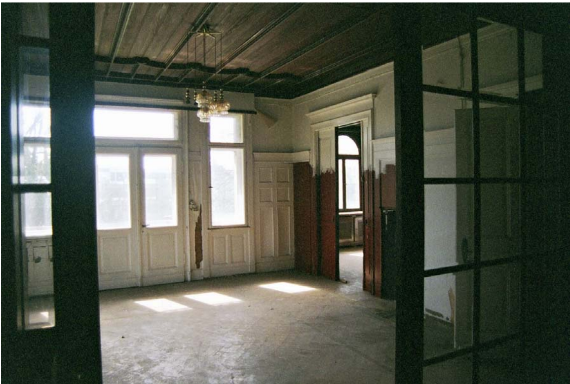
109: Villa Amann, Wohnzimmer (R19), Blick durch die geöffnete Schiebetüre des Speisezimmers (R20) auf die halboffene Türe zum Salon (R18).
