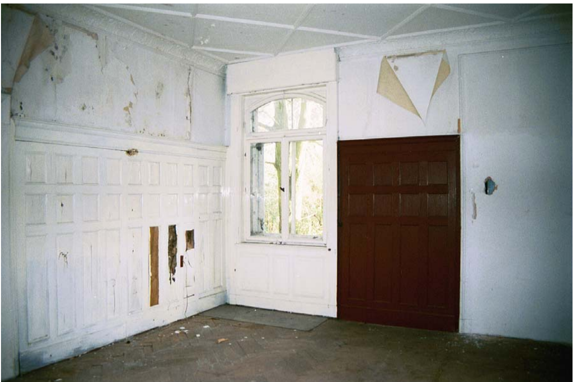
113: Villa Amann, Speisezimmer (R20) nach Nordosten. Rechts geschlossene Türe zu R21.
