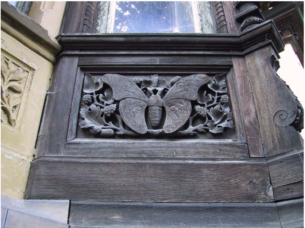
40: Villa Amann, Südseite, Detail der Brüstung vom Fenstererker am EG des Giebelrisaliten.
