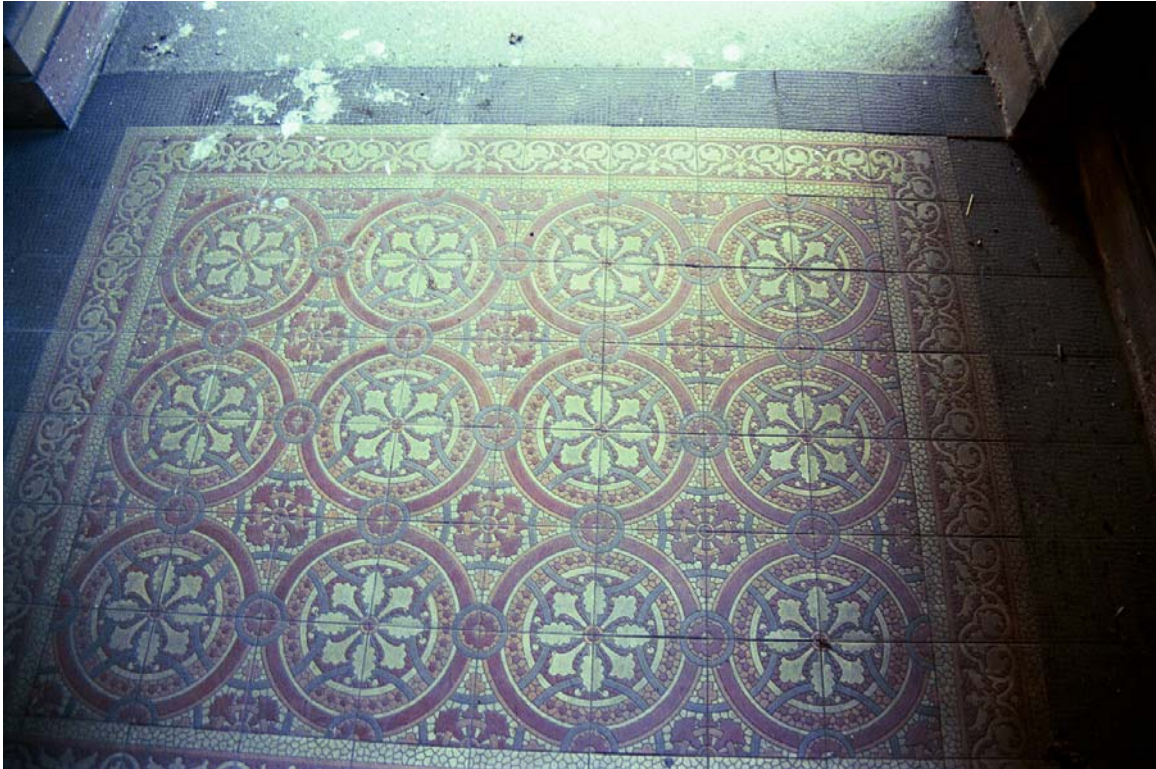
65: Villa Amann, Terrakottaboden im Vorbereich des Haupteinganges.
