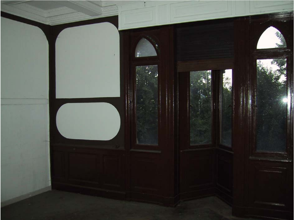
106: Villa Amann, Salon (R18), dreiteiliges Fensterelement mit "Spion". Links ist die nachträglich eingezogene Trennwand sichtbar.
