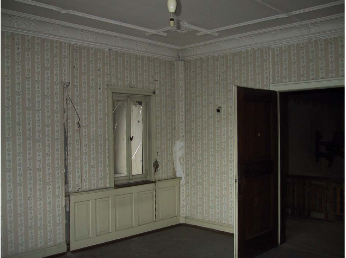
137: Villa Amann, Blick in die Nordwestecke des Ersten Gästezimmers (R28). Fenster und Raumteiler, noch zu erkennen am Brüstungsverlauf, wurden um 1910 eingefügt.
