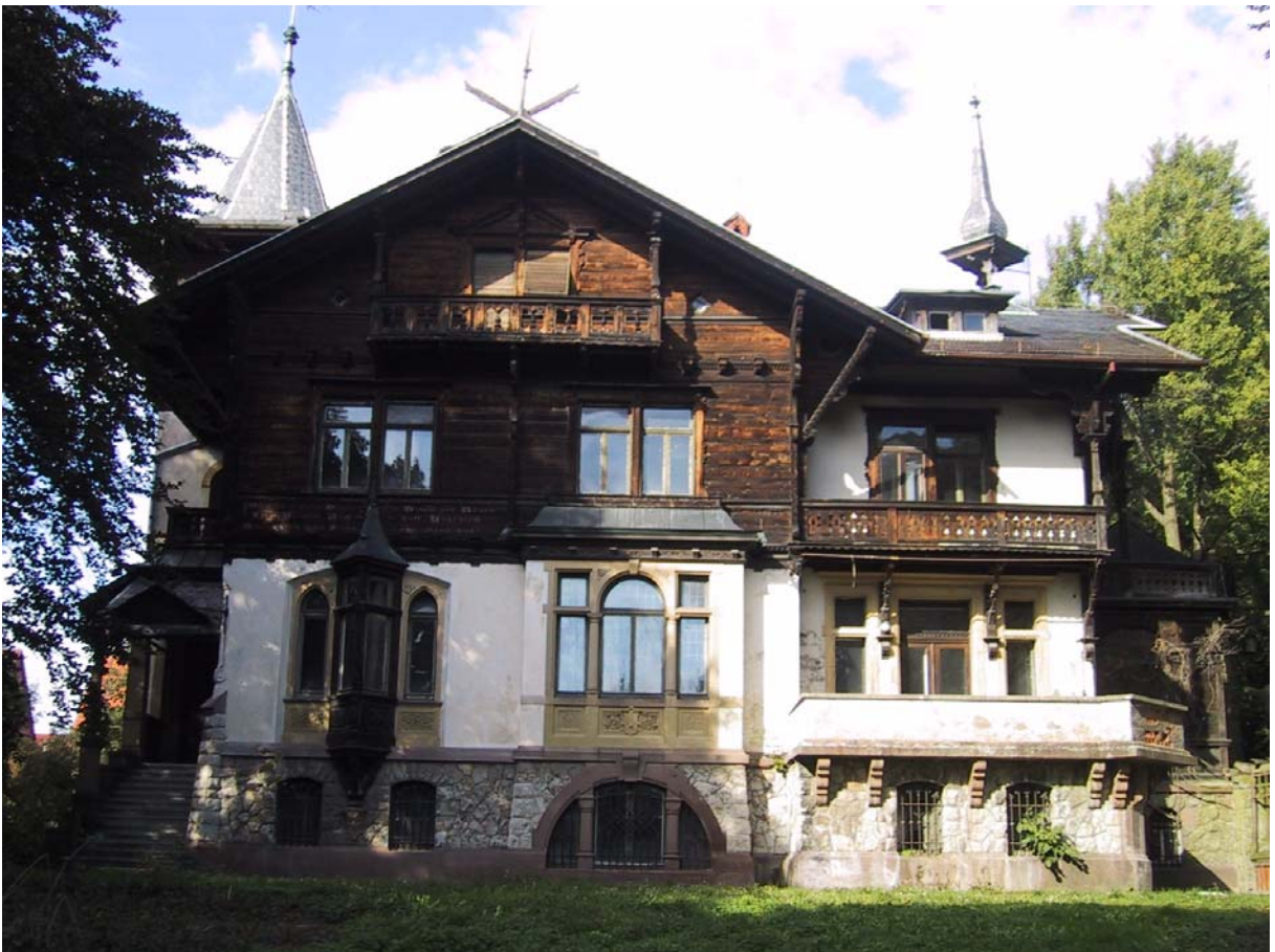
35: Villa Amann, Südfassade.
