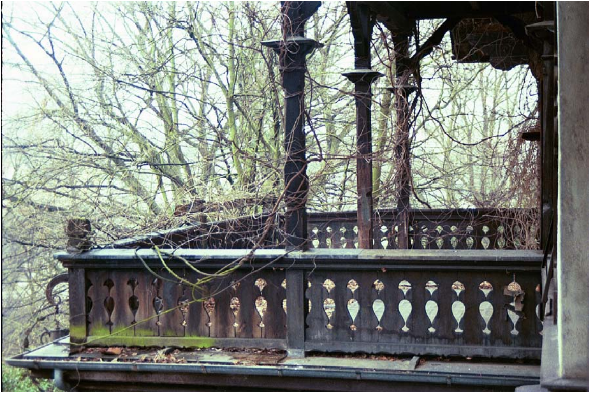
51: Villa Amann, Ostseite, Balkon am Obergeschoß mit Holzbrüstung.
