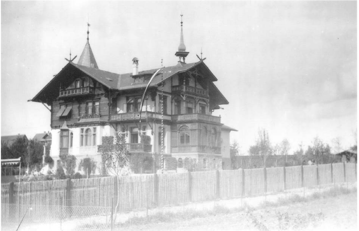
29: Villa Amann von Südwest im Jahre ihrer Fertigstellung 1900. Im Vordergrund der wohl nur als Provisorium gedachte Holzzaun.
