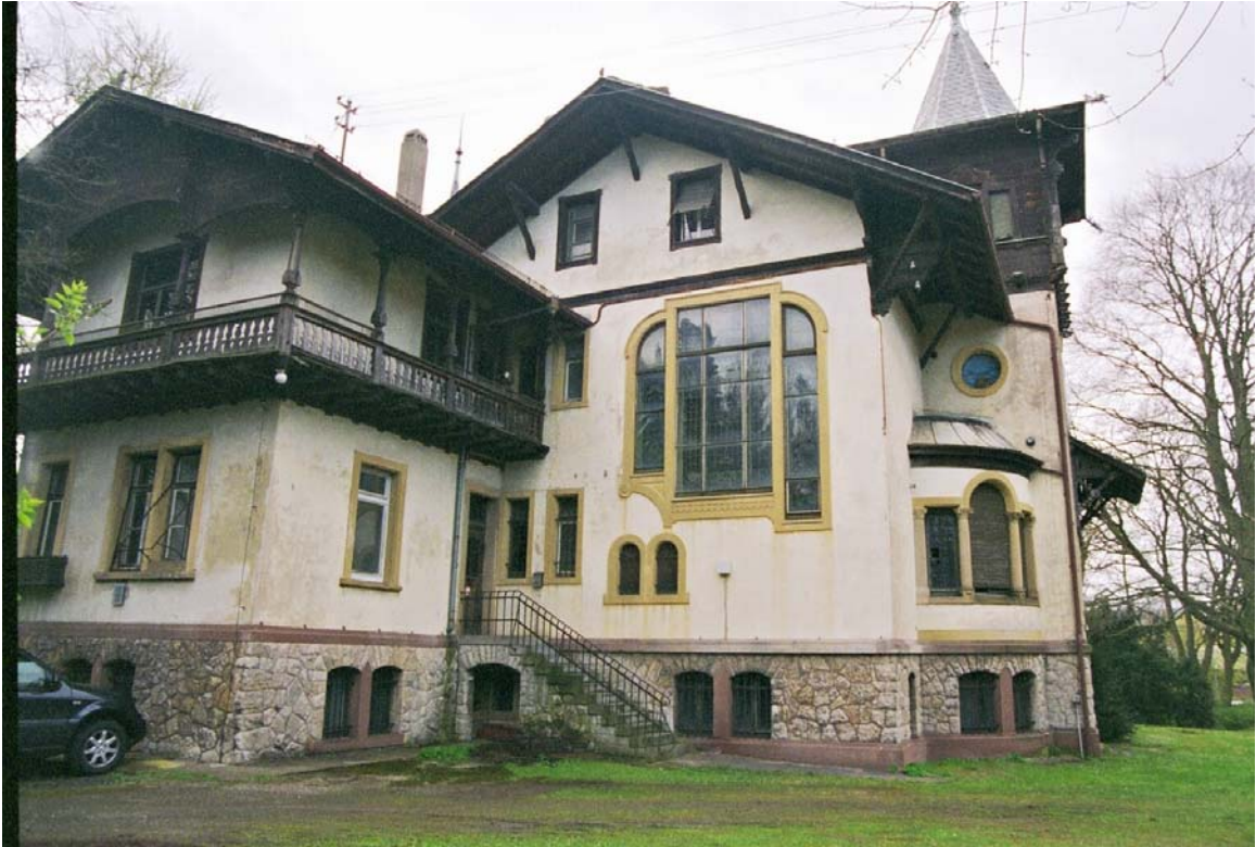
49: Villa Amann, Nordseite, bestehend aus der Rückfront des südlichen Giebelrisalits und dem ursprünglich eingeschossigen, um 1910 um ein Stockwerk erhöhten Küchentrakt.
