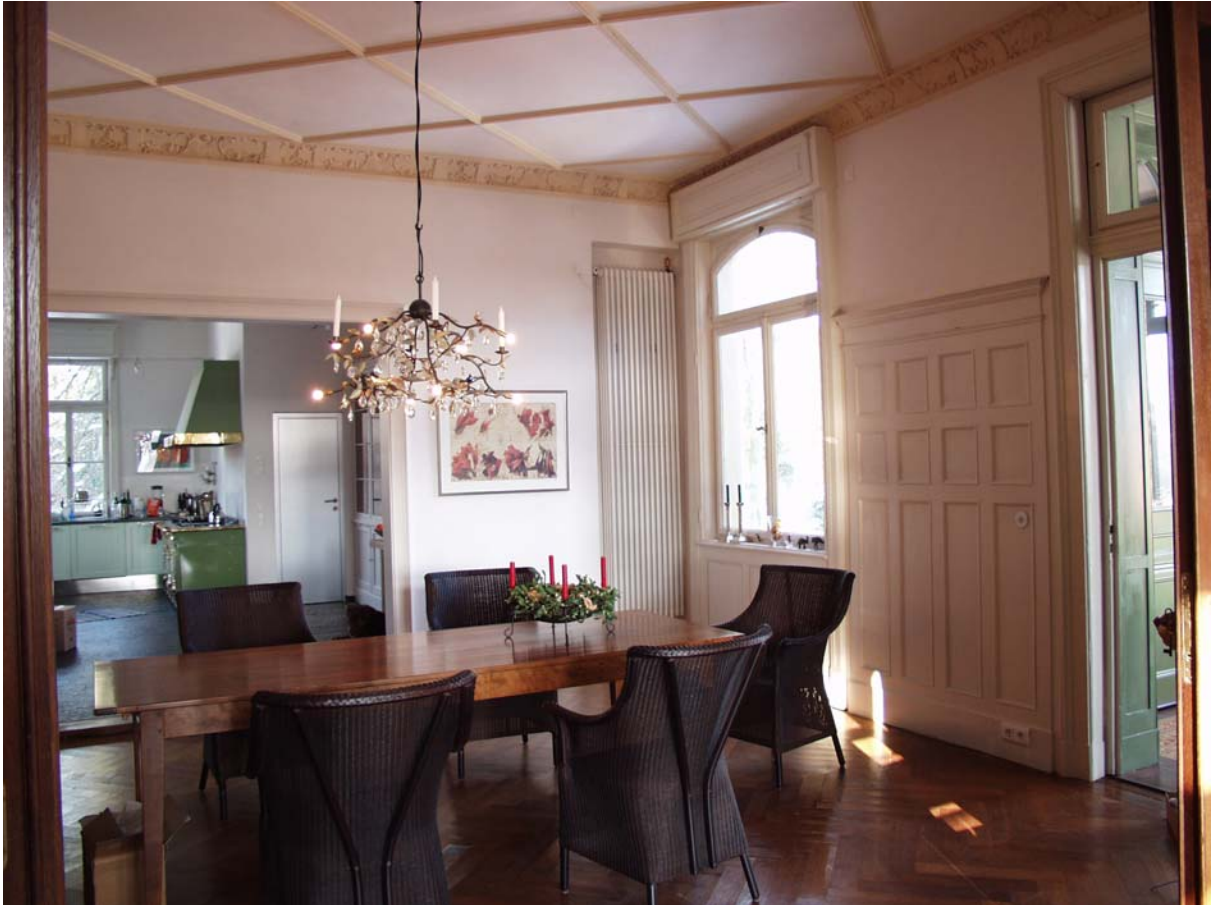
236: Villa Amann, Speisezimmer (R20) mit neu geschaffenem Wanddurchbruch zur Anrichte (R22), die mit dem Küchenraum (R23) durch Herausnehmen der Trennwand zusammengezogen wurde. Aufnahme nach der Restaurierung, 2002.
