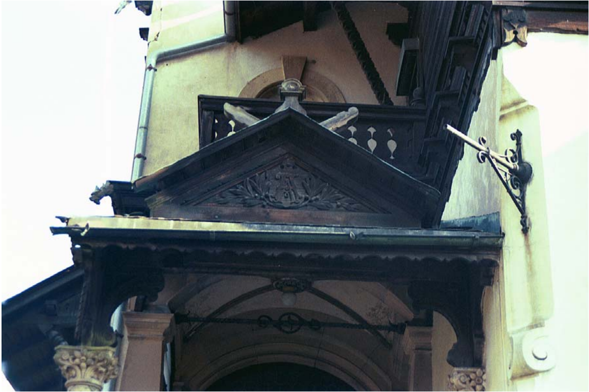
60: Villa Amann, Blick von Süden auf den Giebel des Vordaches am Haupteingang.
