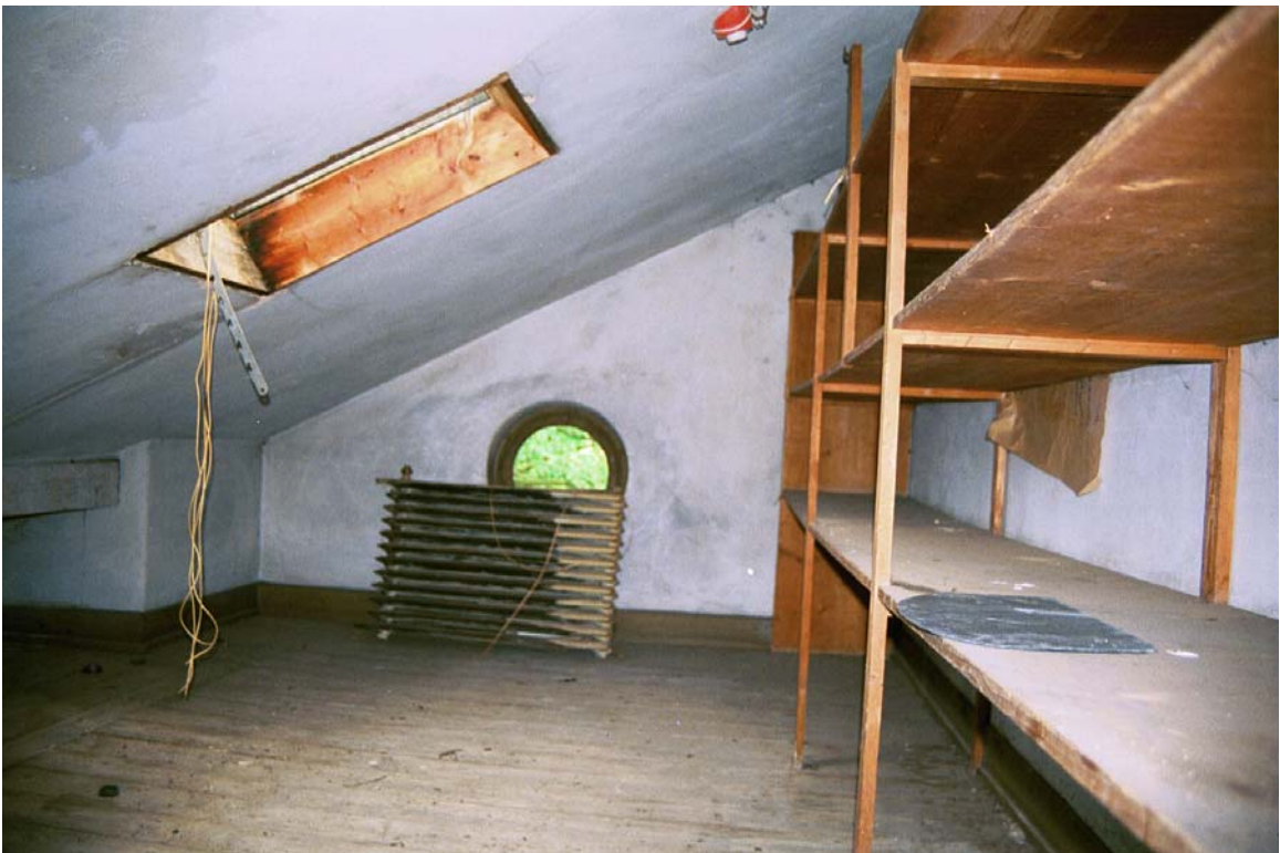
171: Villa Amann, nordöstliche Dachkammer (R39). Konzeption und Rundfenster entsprechen dem südöstlichen Gegenstück (R46).
