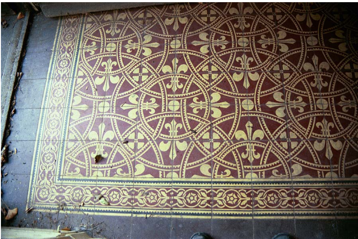
117: Villa Amann, Terrakottafliessenboden des Wintergartens (R21).
