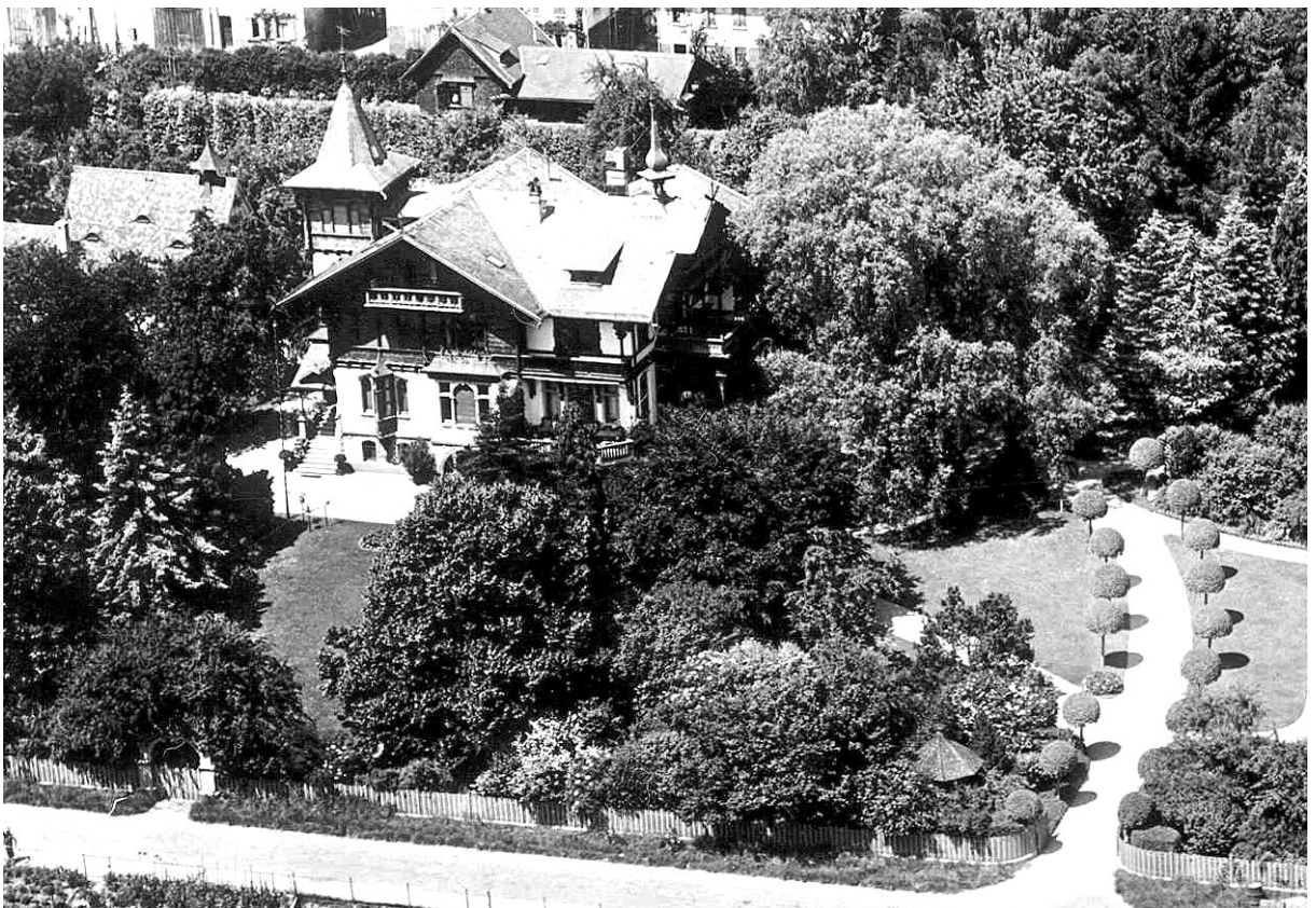
30: Villa Amann von Süden, Foto um 1935. Unten links an der Kirchheimer Straße ist die ursprüngliche Zugangspforte von 1900 zu sehen, rechts die 1907 neu geschaffene Einfahrt.
