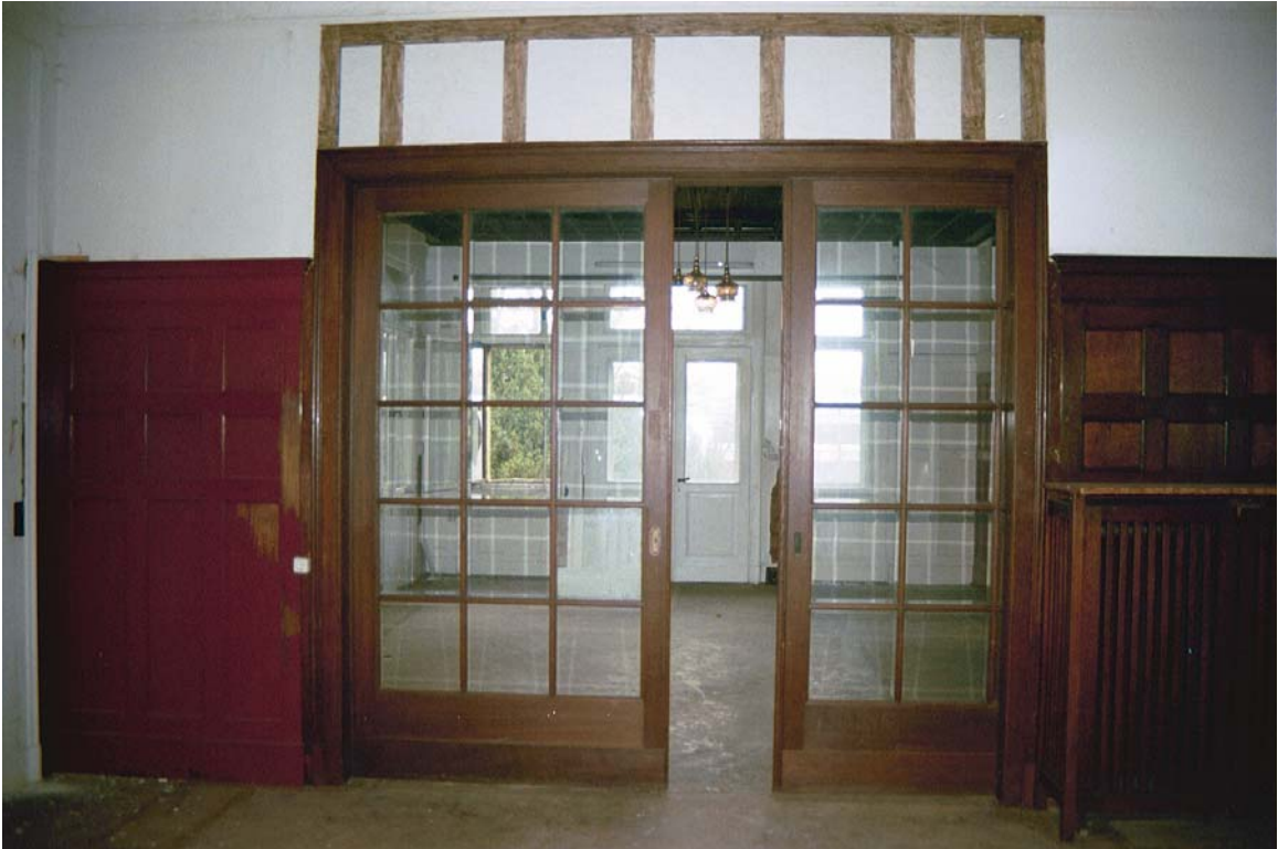
112: Villa Amann, Speisezimmer (R20), Blick auf die Schiebetüre zum Wohnzimmer (R19). Links ein Stück originaler Wand- und Heizungsverkleidung.
