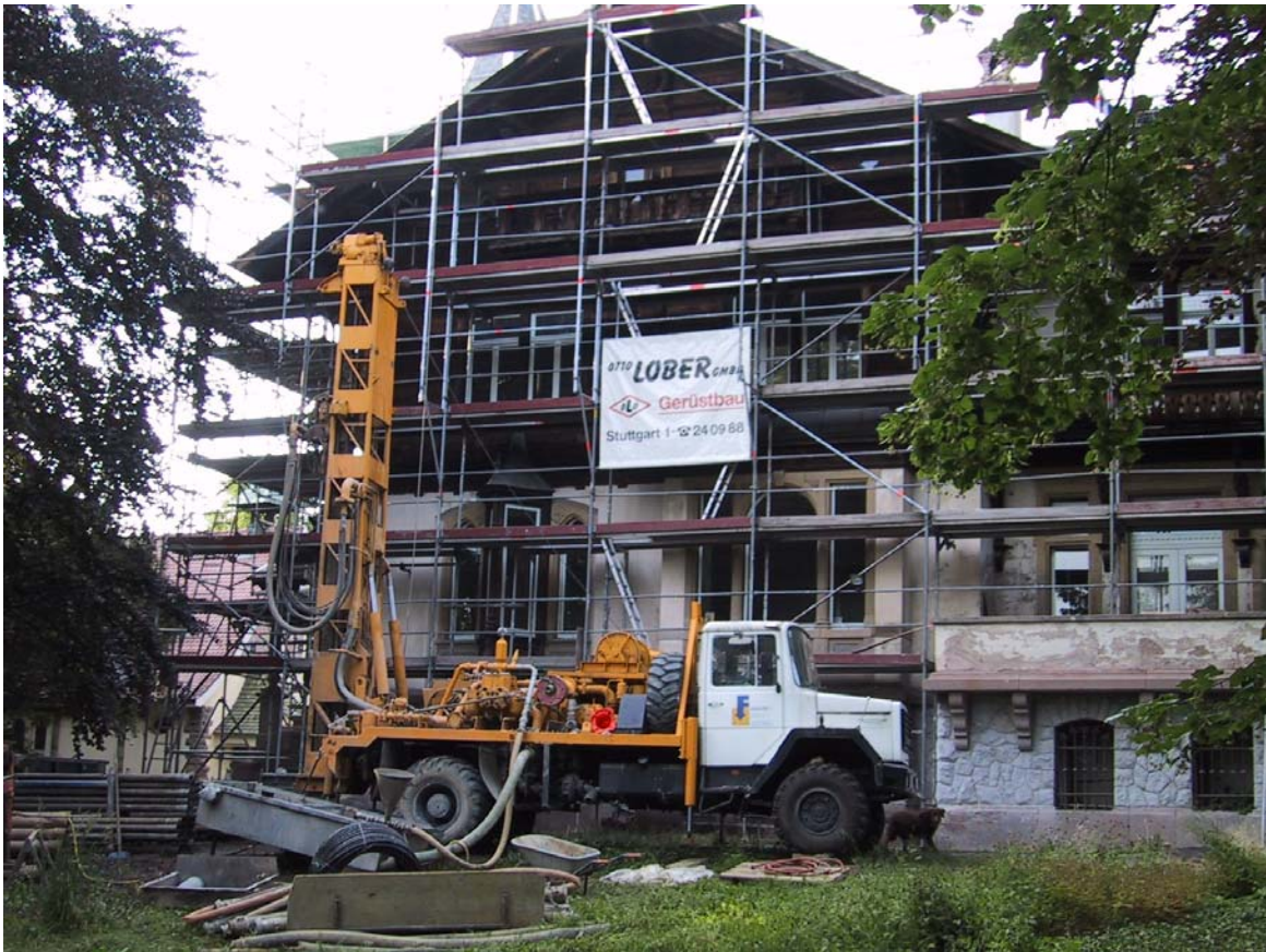
234: Villa Amann, Bohrung für die Erdwärme-Sonden der neuen Heizungsanlage 2001.
