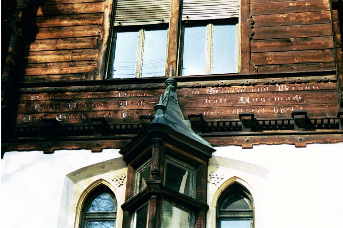
39: Villa Amann, Hausinschrift an der linken Obergeschoßseite des südl. Giebelrisaliten.
