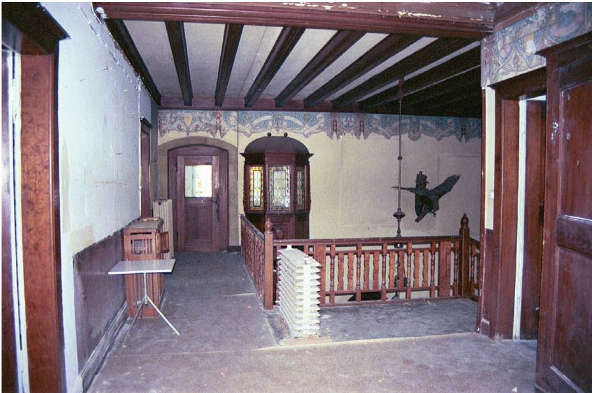
124: Villa Amann, Blick vom Flurbereich in die Hallengalerie nach Westen.
