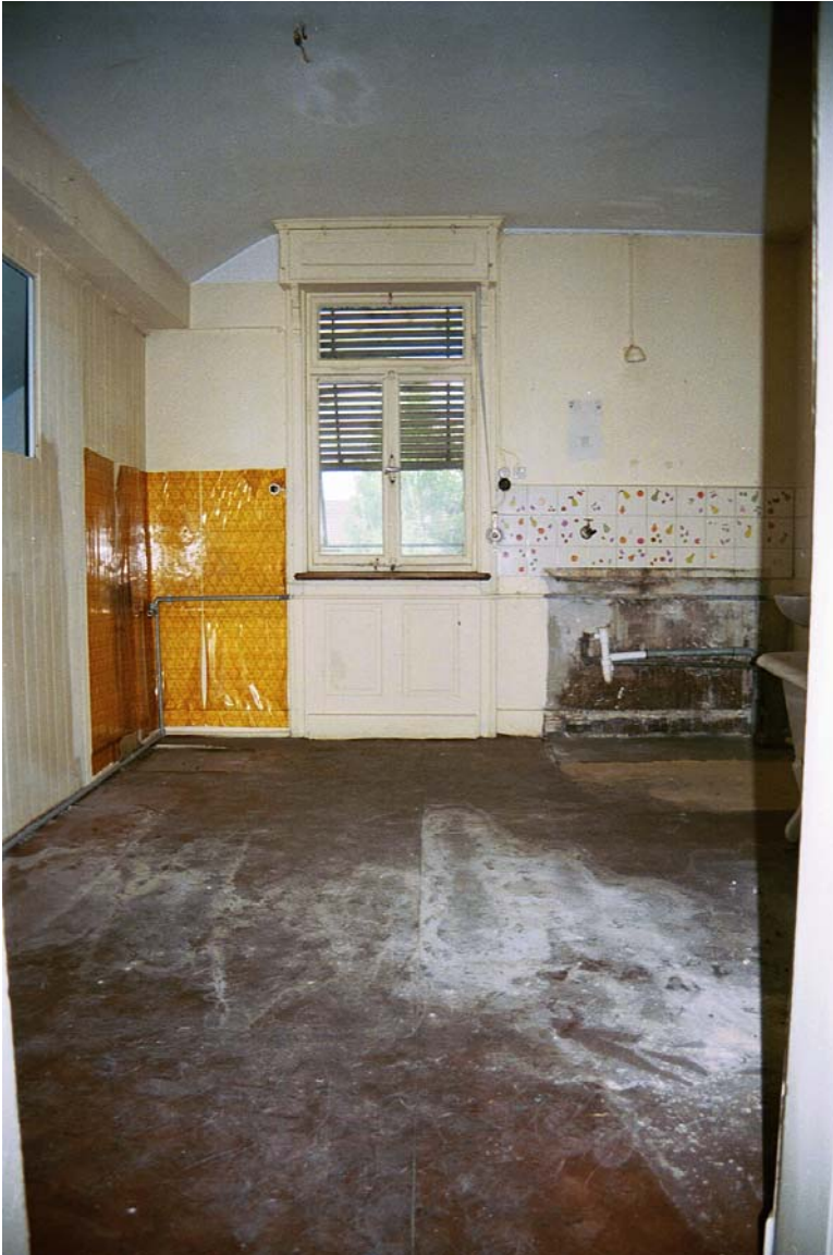
167: Villa Amann, ehemaliges Zimmer für männliches Dienstpersonal im Dachgeschoß (R42). Nach 1945 durch eine Trennwand (links) geteilt und im vorderen Raumbereich in eine Küche eingerichtet.
