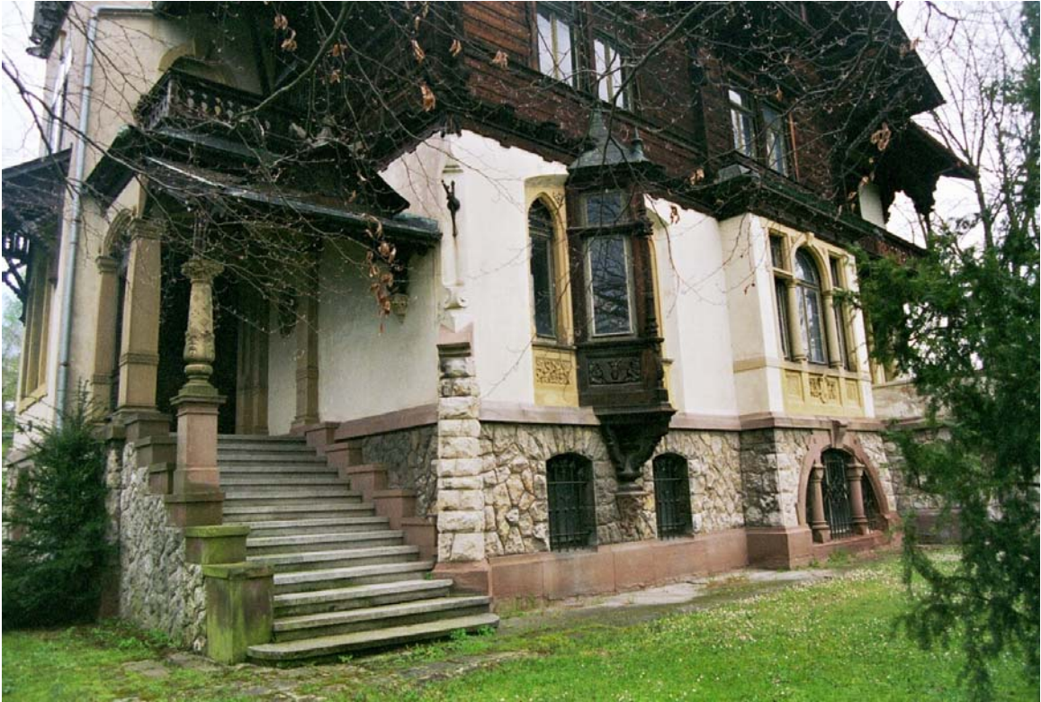
32: Villa Amann, Blick auf Sockel- und Erdgeschoß des südlichen Giebelrisaliten. Gut zu erkennen ist das polygonale Bossenmauerwerk des Sockelgeschosses.
