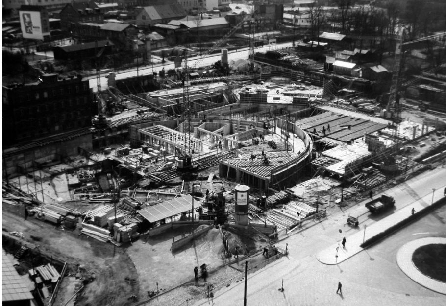
Abb. 41 Deutlich zu erkennen in dieser Baustufe: der Rohbau des BeethovensaaIs, der die Grundlage für den Bau der weiteren Säle darstellt, Büro Gutbrod, 1955.
