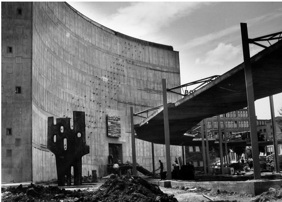
Abb. 115 Untersicht der Pergola aus gestockten- und schalungsrauen, mehrfach gefalteten Betondecken. Erkennbar sind auch die speziellen Stahl- Dreigurtträger an denen die Betonkonstruktion hängt. Die farbigen Keramik- und weißen Marmorstreifen, wurden bereits im Rohbau in die Schalung eingelegt, Blasius Spreng, 1956.
