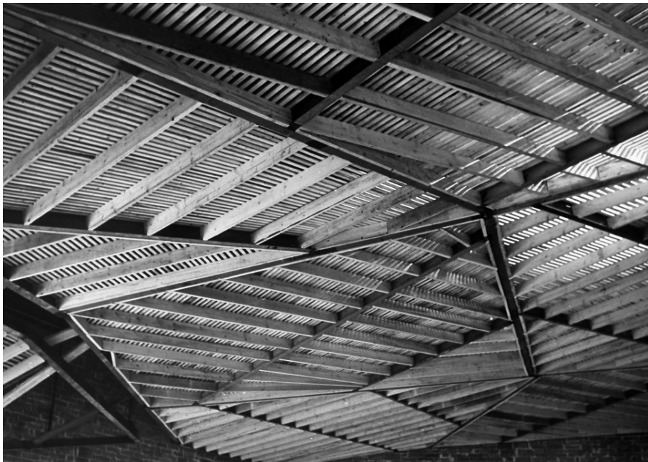
Abb. 78 Unterkonstruktion der abgehängten Saaldecke, Mozartsaal, 1955.
