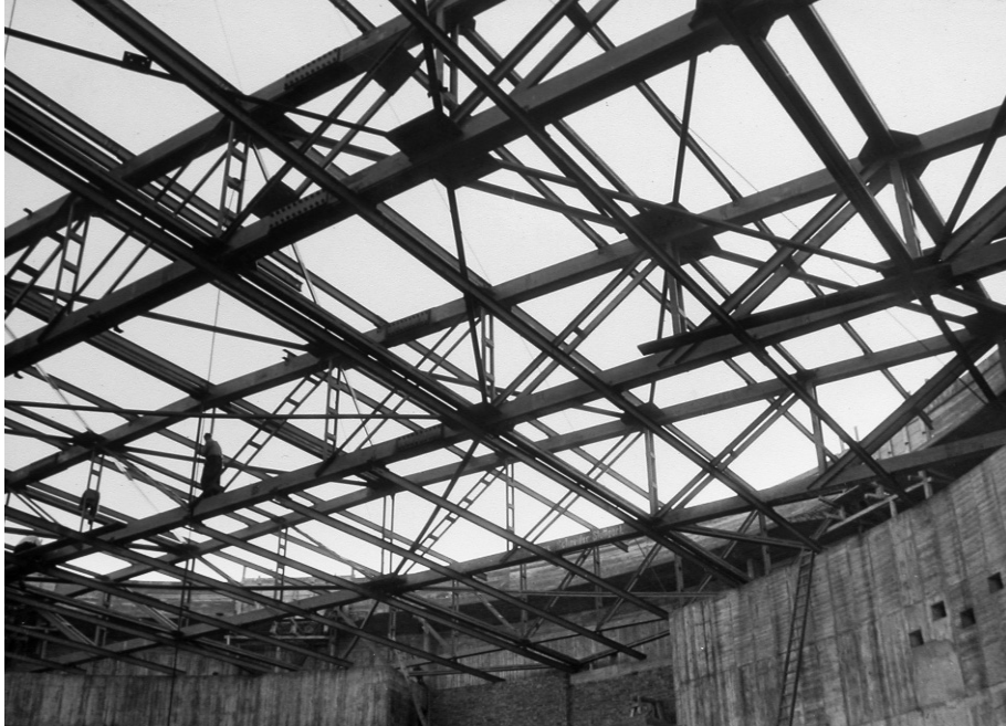
Abb. 66 Stahlfachwerkträger, 3 m Höhe, für Revisionsarbeiten begehbar.
