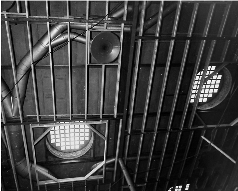
Abb. 92 Deckenuntersicht Innenausbau, Großes Foyer, Belüftung und Oberlichter.
