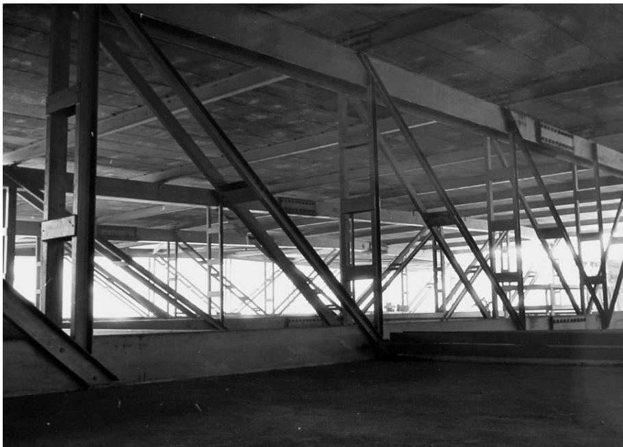
Abb. 67 Stahlfachwerkträger mit Zugdiagonalen, zum Auflager hin steigend.
