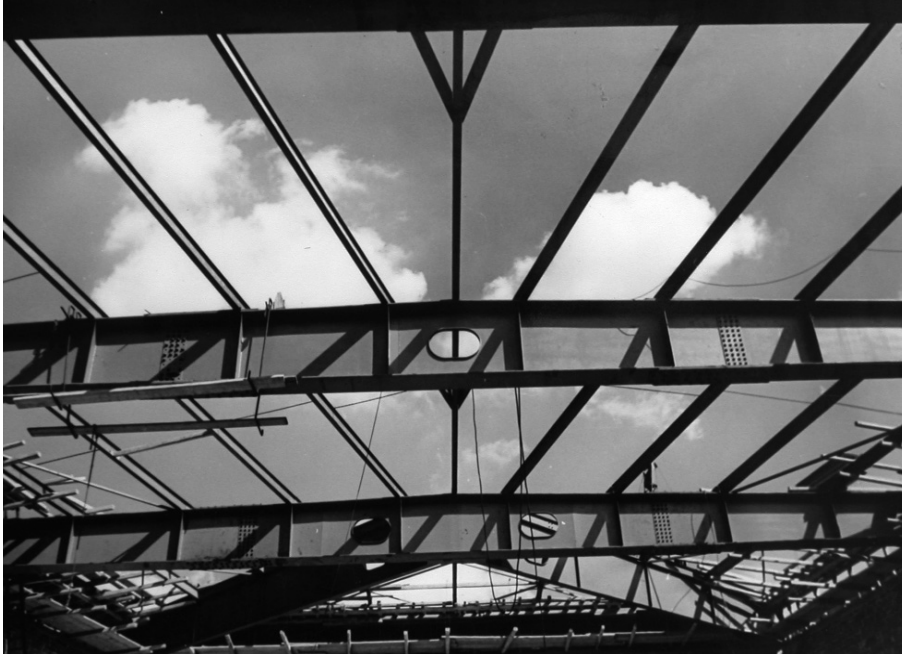
Abb. 79 Vollwandstahlträger als Primärkonstruktion, mit 3% Gefälle, zum First hin ansteigend, Mozartsaal, 1955.
