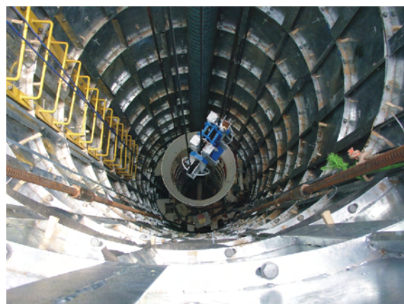
Abb. 9: Blick in den Zugangsschacht
