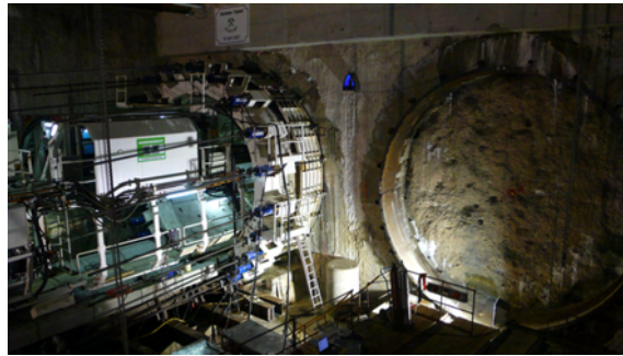
Abb. 19: Tunnelbohrmaschine bei der Einfahrt in den HDI-Dichtblock
