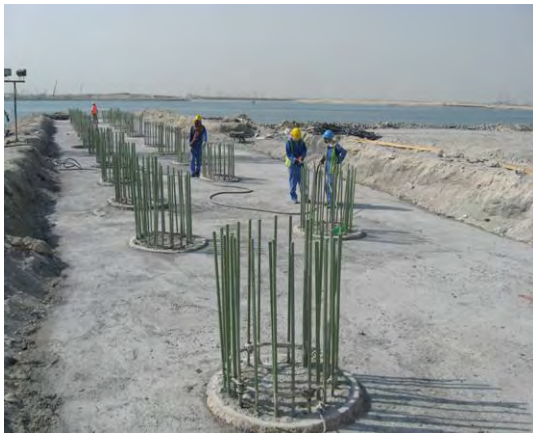
Abb. 11: Epoxid-ummantelte Anschlussbewehrung der Bohrpfähle im Bereich der späteren Pfahlkopfplatte
