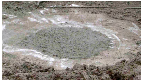
Abb. 10: Frisch hergestellter Pfahlkopf auf vor dem Einbau der Anschlussbolzen
