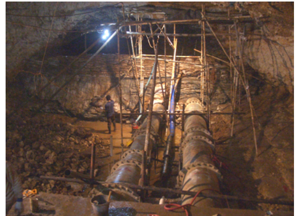
Abb. 14: Stand der Bauarbeiten Dezember 2005
