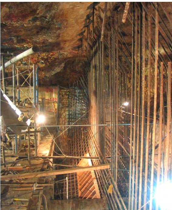
Abb. 21: Blick auf die Bewehrung der Sperrmauer zu Beginn des Schalungsbaus für den 2. Betonierabschnitt. Im unteren Bildbereich sind ein Schalungselement und am linken Bildrand ein Teil der Anlagenplattform zu sehen (Fließrichtung von rechts nach links)
