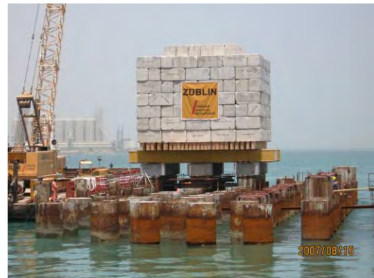
Abb. 13: Durchführung eines Pfahltest auf dem Wasser
