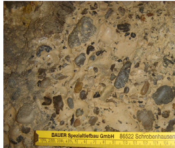
Abb. 20: Freigelegter verfestigter Boden. Detail der Ansichtsfläche aus Abbildung 19 rechts
