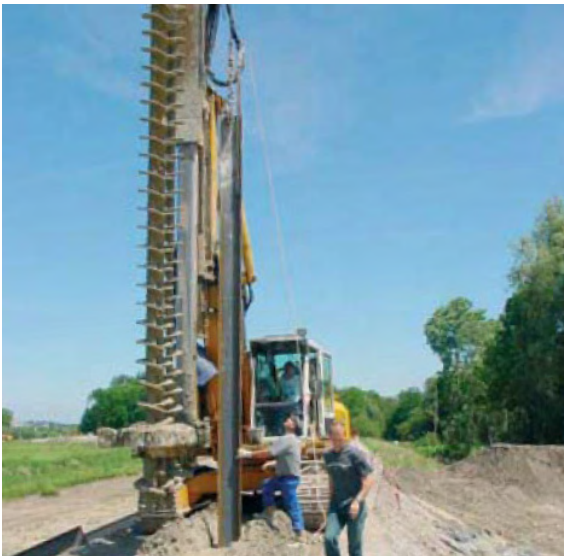
Abb. 29: Trägereinbau in die frische MIP-Wand
