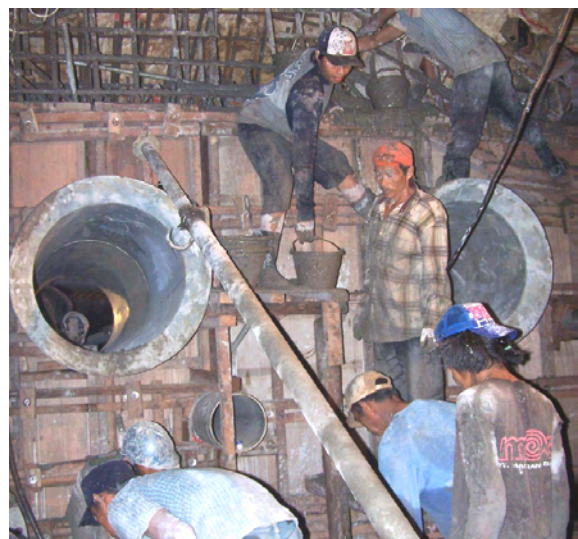
Abb. 24: Händischer Betoneinbau mit Eimern bei der Betonage des 5. Abschnitts
