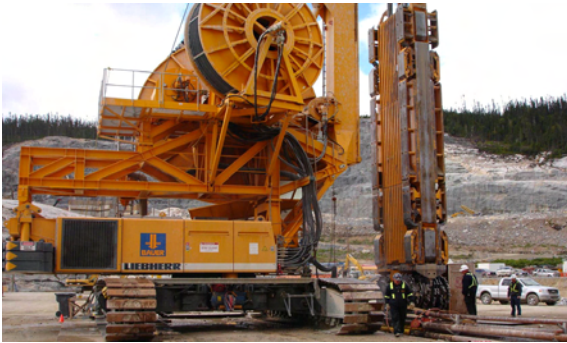
Abb. 18: Schlitzwandfräse für Tiefen bis 135 m
