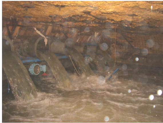
Abb. 15: Partielle Einstau des Sperrwerkes während eines Hochwasserereignisses wenige Tage nach Abschluss der Betonierarbeiten
