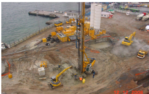
Abb. 26: Drehbohrgerät BG 28 mit 50-m-Mast
