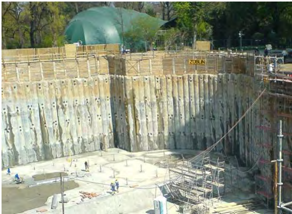
Abb. 7: Ausführung einer bis zu fünffach rückverankerten überschnittenen Bohrpfahlwand bei der KfW-Westarkade in Frankfurt
