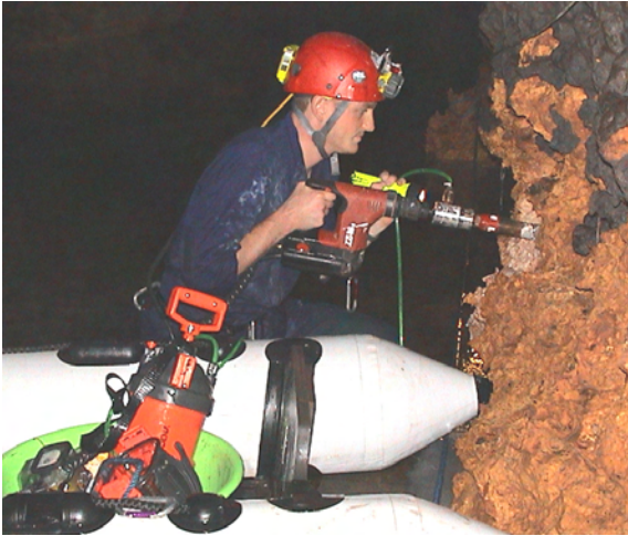
Abb. 5: Bohrkernentnahme mit Akkubohrgerät und Handpumpe im Bereich der späteren Baustelle
