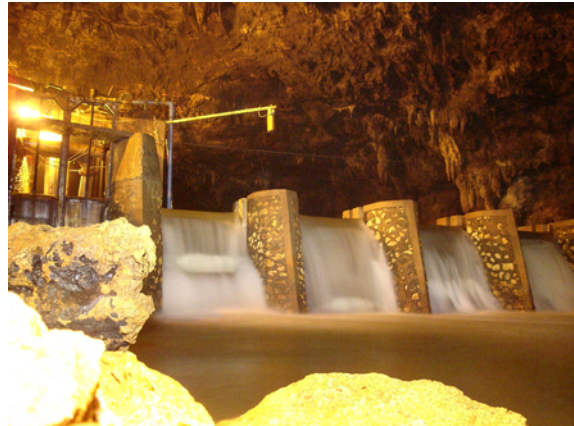
Abb.6: Alte unterirdische Wehranlage mit Radarmesspegel des IWG
