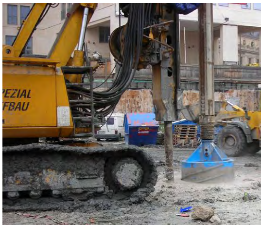
Abb. 8: Bohrgerät beim Einbringen der Verrohrung für einen Gründungsbohrpfahl
