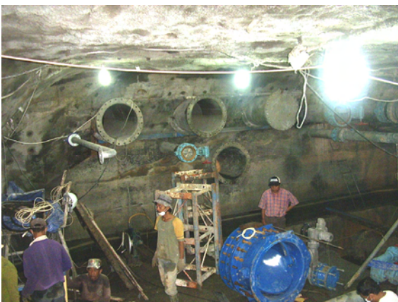
Abb. 26: Fertig gestellte Mauer mit Durchlässen während dem Einbau der Fördermodule (Blick von unterstrom)
