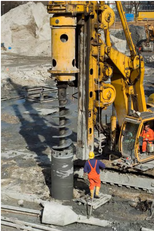
Abb. 5: Herstellung eines verrohrten Bohrpfahles im Kelly-Verfahren
