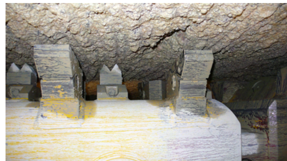
Abb. 21: Frässpuren an der Ortsbrust beim Einfahren in den HDI-Dichtblock
