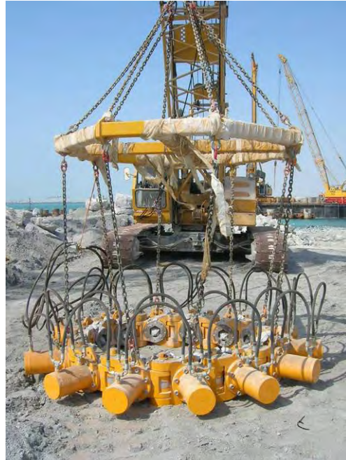
Abb. 12: Hydraulische Kappvorrichtung zum Kürzen der Bohrpfähle
