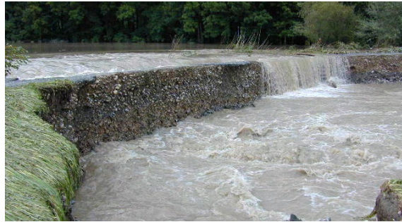
Abb. 31: Überströmung der MIP-Wand
