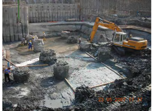
Abb. 9: Freilegen und Herrichten der Pfahlköpfe
