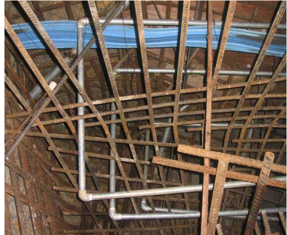
Abb. 22: Bewehrung der Sperrmauer, eingebaute Kühlrohre und Fugenband zwischen dem 2. und 3. Betonierabschnitt vor Einbau des Betons
