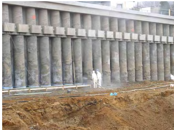
Abb. 6: Beispiel einer aufgelösten Pfahlwand bei der Ortsumgebung Pirna
