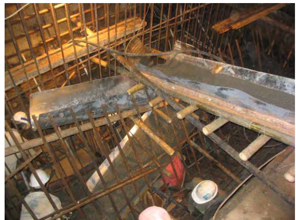
Abb. 23: System aus verzweigten Rinnen zum Transport des Frischbetons vom Schachtfuß in die Schalung
