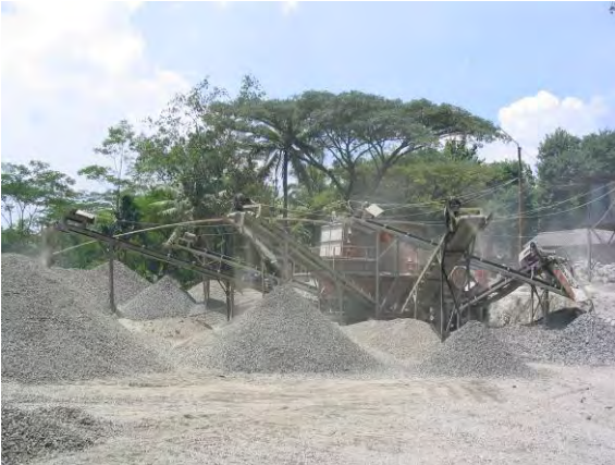
Abb. 15: Maschinelles Brechen und Sortieren von Gesteinskörnungen zur Betonherstellung
