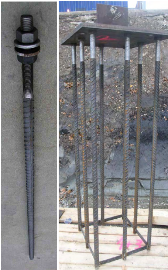
Abb. 9: Anschlussbolzen mit eingefrästem Gewinde und Bolzengruppe vor dem Einbau
