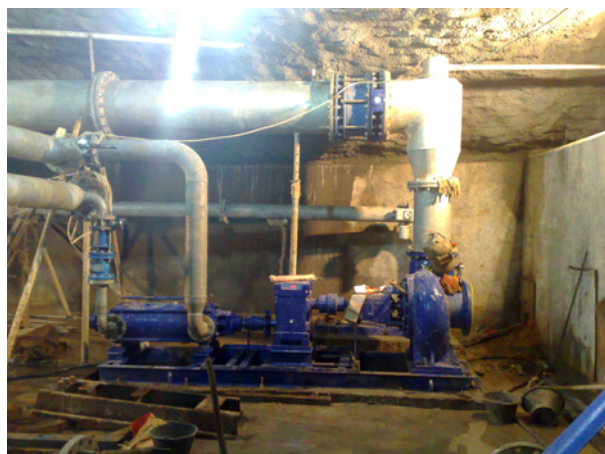
Abb. 16: Installiertes KSB-Fördermodul
