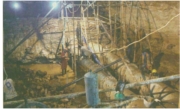
Abb. 19: Blick von unterstrom auf die Baustelle. Am oberen Bildrand ist der oberstromige Kofferdamm aus Ausgussbeton mit einer Erhöhung aus Sandsäcken zu sehen. Rechts sind die beiden Hochwasserentlastungsrohre sichtbar
