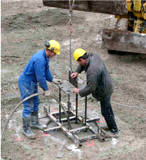
Abb. 11: Einbau der Bolzengruppe mit einer lokalen Lagegenauigkeit von \pm 2,5 mm
