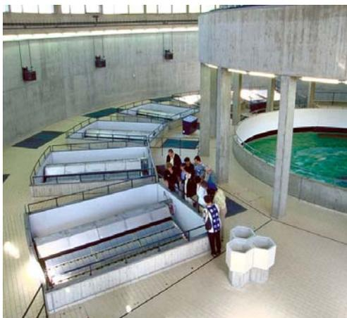
*Wasseraufbereitungsanlage Sipplinger Berg; links Mikrosiebe, rechts das Quellbecken*
