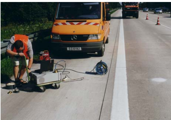
Bild 4.3: Messaufbau zur Bestimmung des Feuchtegehalts im Beton (dielektrische Methode) in verschiedenen Tiefen
