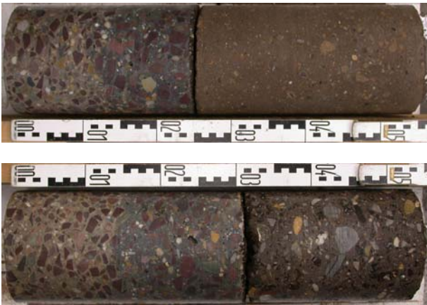
Bild 2.2: Bohrkern aus der Plattenmitte oben: bei Betriebskilometer 594+835 unten: bei Betriebskilometer 597+905 (linkes Probenteil: Betondecke; rechtes Probenteil: Verfestigung)
