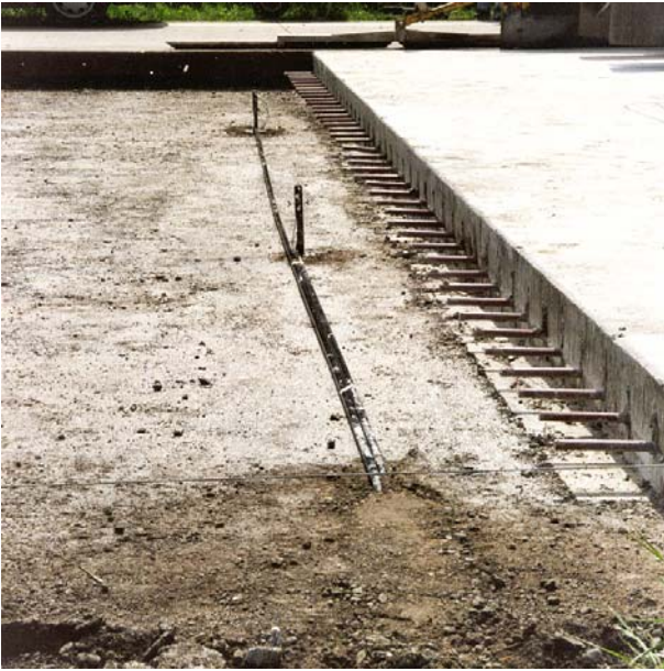
Bild 3.3: Einbau der Haltegestelle mit den Sensoren für die Temperaturmessung im rechten und mittleren Fahrstreifen, jeweils im Bereich der rechten Rollspur
