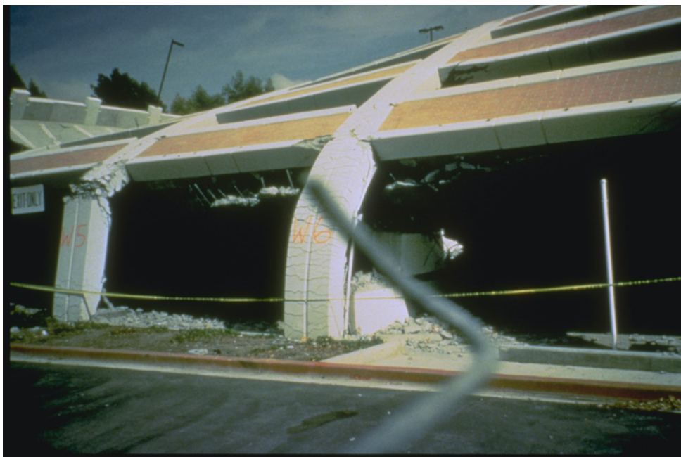
Abbildung 9.14: Versagen eines Krankenhauses infolge seismischer Belastung
