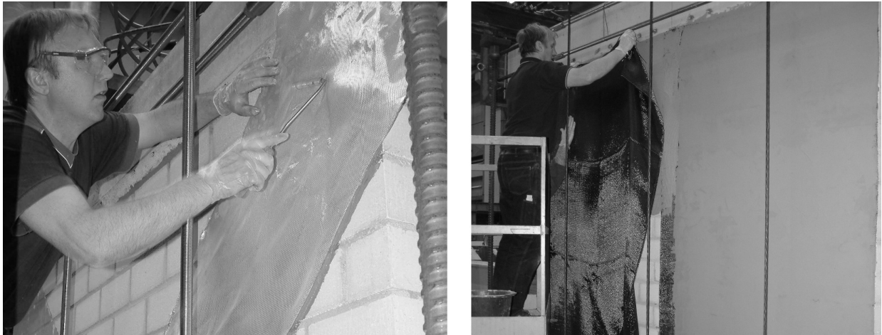
Bild 4.16: Diagonale Applikation des Epoxidharz-Laminates auf WPK 2 (links) und vollflächige Applikation des Zementmörtel-Laminates auf WPK 3 (rechts)
