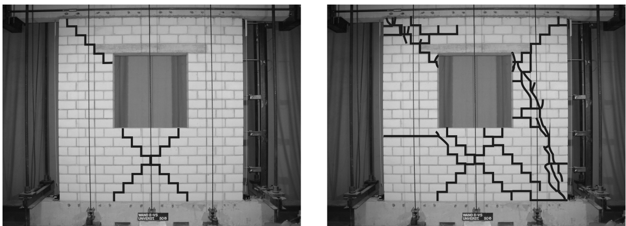
Bild 4.28: Rissbild WPK 7 nach der 100 %-Skalierungsstufe (links) und nach abgeschlossener Prüfung (rechts)
