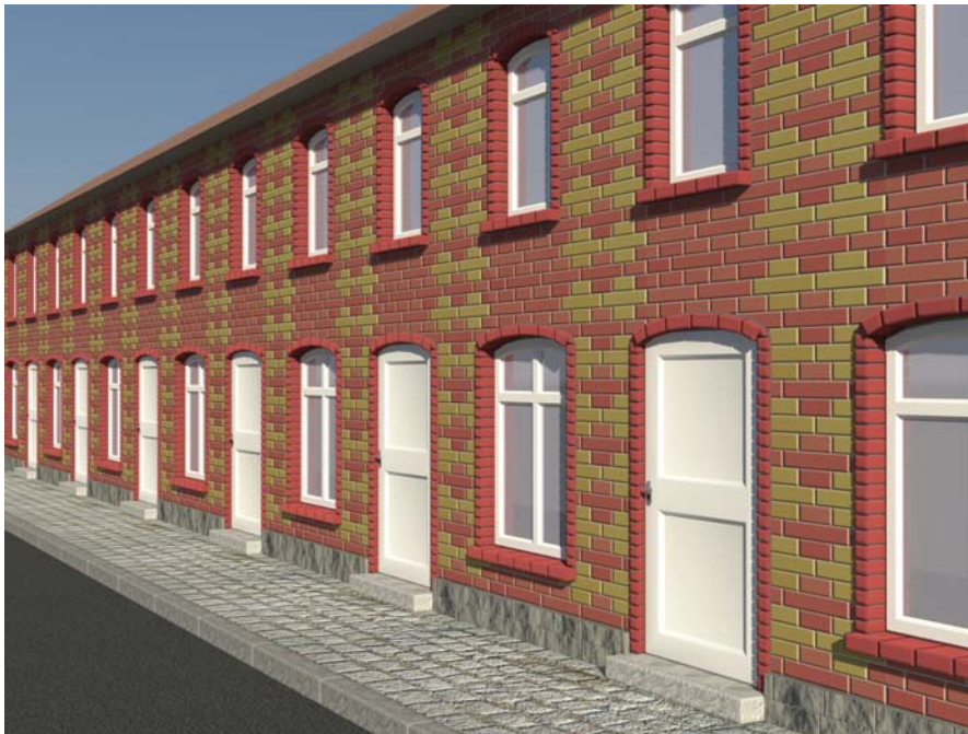
Abbildung 7.15: Die Gebäudezeile mit einem Kreuzverband. Die gesamte Front besitzt unten an der Wand einen Sockel und die Türen sind mit einer Stufe versehen.
