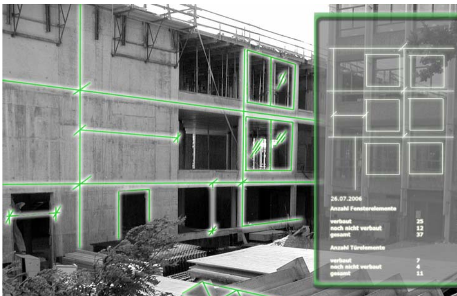
Abbildung 3.22: Soll-Ist-Abgleich mit Unterstützung von Augmented Reality
