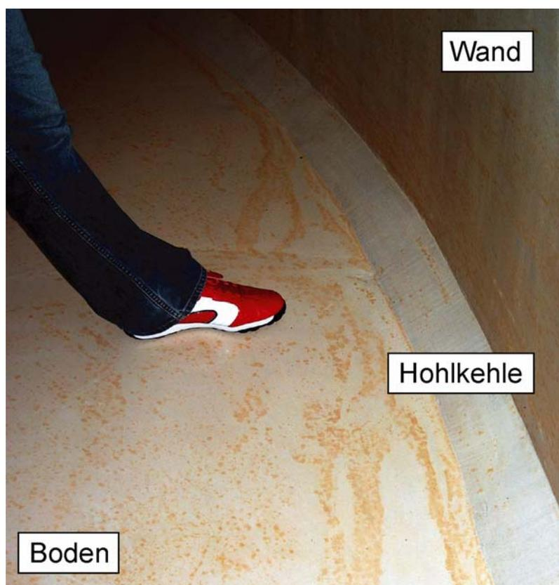
**Abbildung 39:** Erscheinungsbild der Schädigung durch hydrolytische Korrosion in einem Trinkwasserbehälter im Kanton St. Gallen, Schweiz
