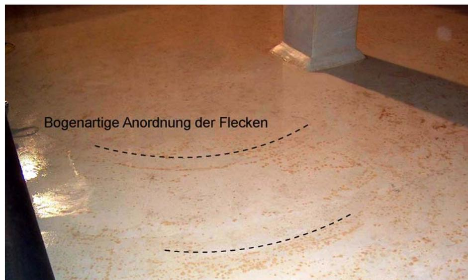
**Abbildung 27:** Bogenartige Anordnung der Flecken im Bodenbereich eines Trinkwasserbehälters
