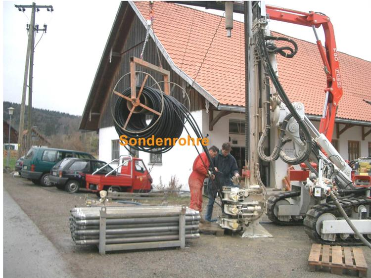
Abbildung 2.2: Einbau der Sondenrohre von einer Haspel in die fertig gestellte Bohrung.
