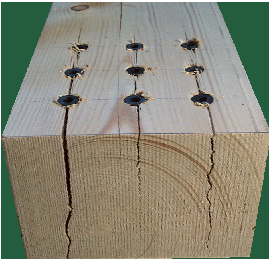
Bild 2-1 Rissbildung und Aufspalten beim Eindrehen von Schrauben aufgrund zu geringer Abstände der Verbindungsmittel untereinander und zu den Rändern
