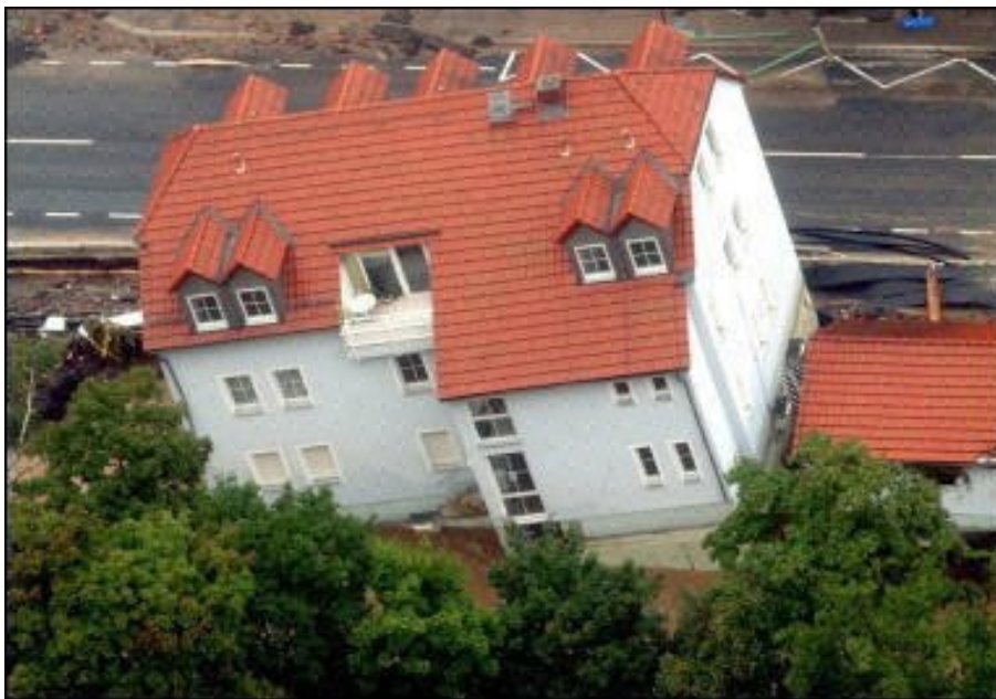
Bild 5-4: Gebäudeschäden durch Erosion (Schiefstellung) (Foto: S. Hickmann)
