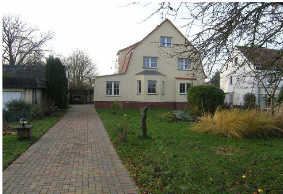
Abbildung 6-13 : Beispiel Schadenserhebung: Grundriß / Foto
