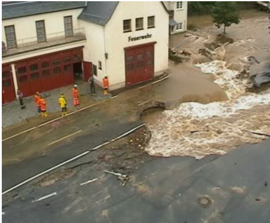
Bild 5-5: Elbehochwasser 2002, Erosion unter Strasse (Foto: S. Hickmann)
