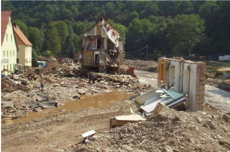
Bild 5-3: Versagen von Gebäuden durch Strömungsangriff (Foto: S. Hickmann)
