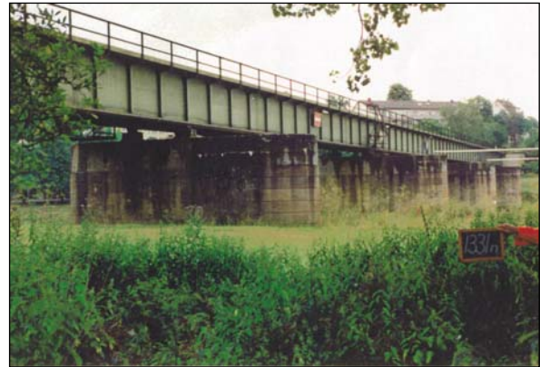
Bild 8-3: Brücke Jagstfeld, Blick von OW
