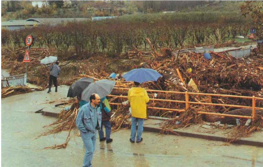
Bild 8-1: Verklausung einer Brücke beim Elbehochwasser2002 (Foto: Münchner Rück)
