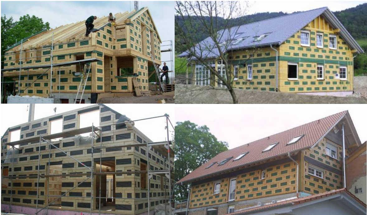
Bild 1-1: Wohngebäude aus vorgefertigten Wandelementen im Rohbau
