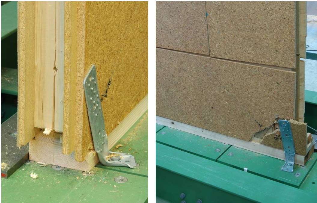
Bild 5-13: Abgleiten der unteren Fuge bei den ersten Versuchen
