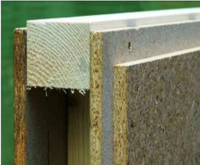
Bild 5-5: Detailausbildung Befestigung des Einbinders
