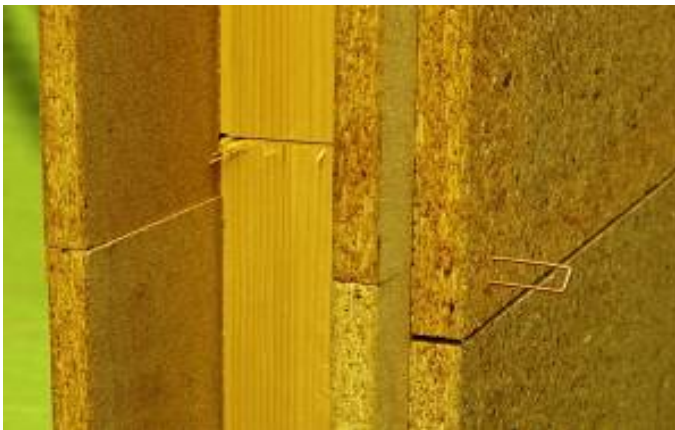
Bild 5-6: Detailausbildung Elementüberlappung
