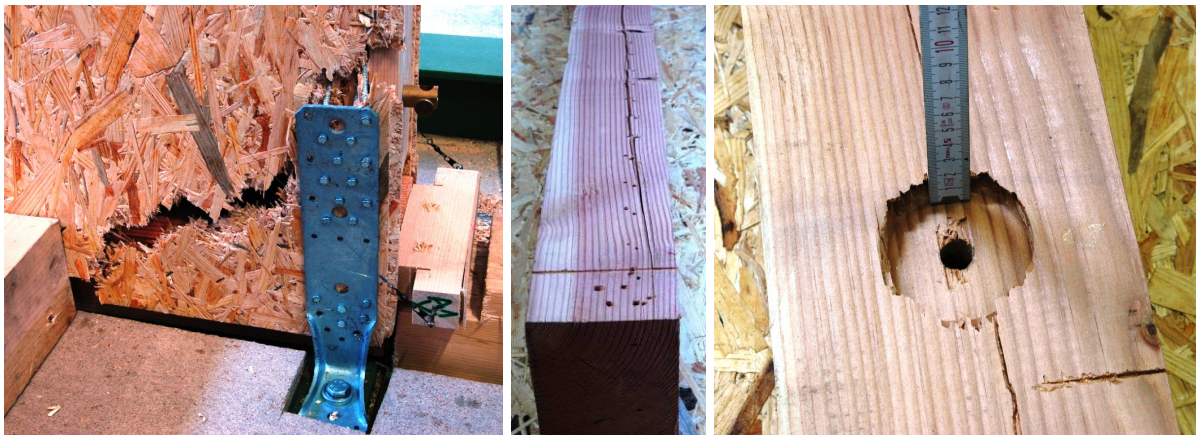
Bild 5-32: Holztafelbauwand mit beidseitiger Beplankung, Abriss der Beplankung auf der Zugseite (links), Quersugversagen der Schwelle (Mitte), Eindrückungen unter Unterlegscheibe Fundamentdübel (rechts)
