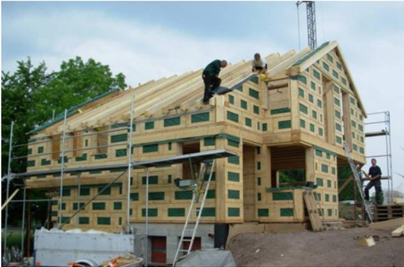
Abb. 2: Wohngebäude aus vorgefertigten Wandelementen im Rohbau
