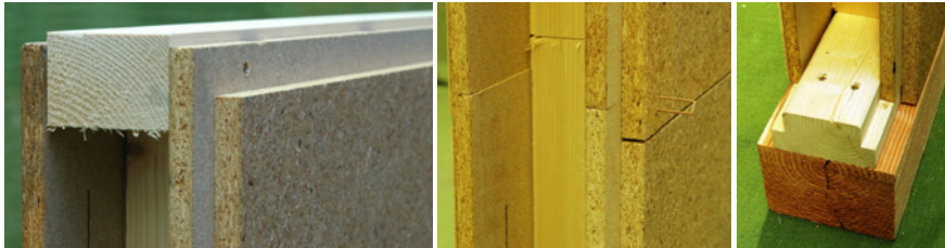
Bild 3: Details der Einzelement-Bauweise: (links) Einbinder bzw. Rähm als oberer Wandabschluss auf oberem Element mit Schrauben befestigt, (mitte) Grundelemente, Überlappung mit Klammern verbunden, (rechts) Schwelle aus Douglasie, Formteil aus Nadelholz zur Befestigung der unteren Elementlage.
