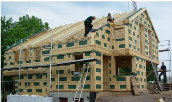
Bild 1: Rohbau eines Wohngebäudes aus vorgefertigten Wandelementen
