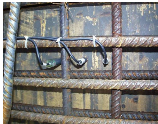
Abb. 7: Befestigung der Elektroden
