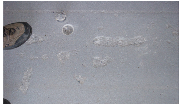
Abb. 7: Abplatzungen auf einem Parkdeck nach dem Kugelstrahlen durch so genannte „Schwartenbildung“
