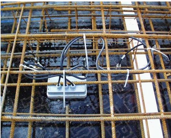
Abb. 8: Befestigung der Messbox
