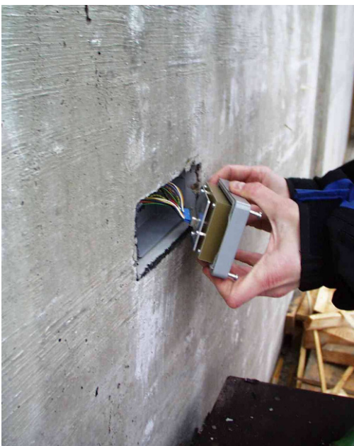
Abb. 9: Einbau der Messelektronik
